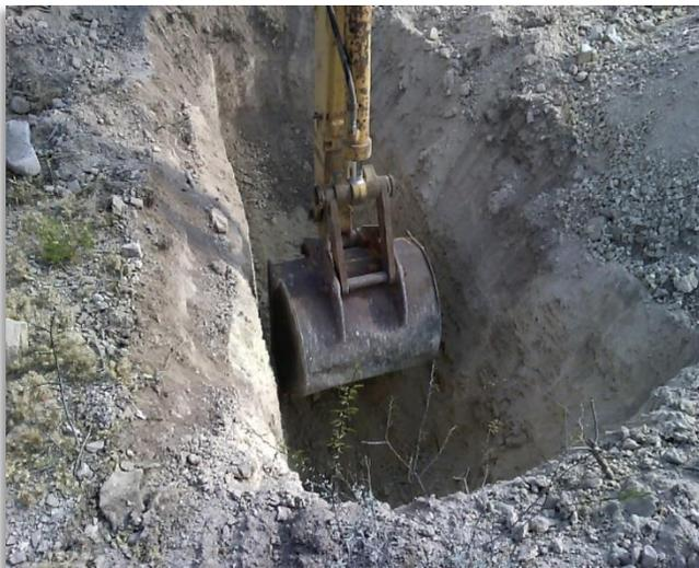
**Fotografía 7.** Se observa el proceso de excavación para el Pozo a Cielo Abierto (PCA-06) para la válvula MLV-207 ubicada en el KP 226+526, en el que se aprecia material compuesto por Grava Arcillosa de compacidad de media a densa.
