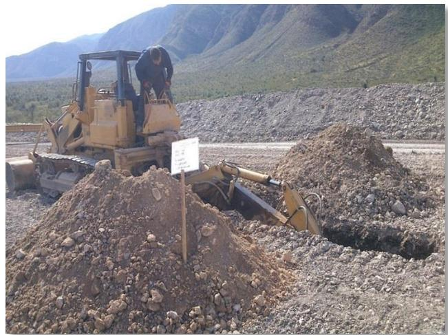
**Fotografía 20.** Se aprecia el material producto de la excavación del Pozo a cielo Abierto (PCA-11) para la MLV-212, conformado por gravas arcillosas y fragmentos medianos de roca y presencia de carbonatos de calcio. Se muestra el proceso de excavación y su deposición al costado de la misma, considerando la separación por estratigrafía para su muestreo y traslado al laboratorio.
