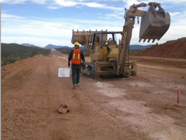
**Fotografía 15.** Se observa el punto de referencia ubicado vía GPS por parte de la Brigada de exploración, a fin dar inicio a los trabajos de excavación para el Pozo a Cielo Abierto (PCA-09) para la válvula MLV-210.
