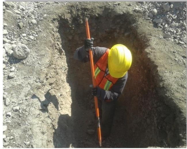
**Fotografía 2.** Personal de la brigada de campo durante la excavación del PCA por medios manuales. Se aprecian las gravas y fragmentos de roca al interior del Pozo a Cielo Abierto (PCA-01) para la válvula MLV-203. El material de cada estrato fue muestreado, protegido contra pérdida de humedad y etiquetado para su traslado al laboratorio.
