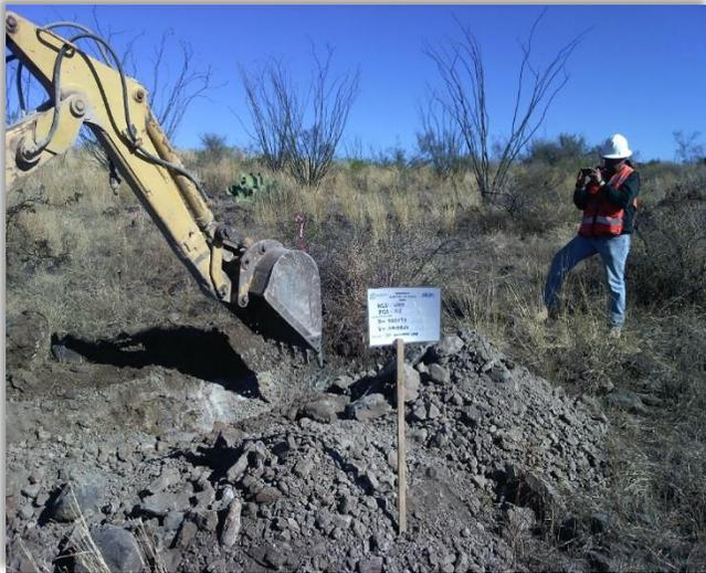
**Fotografía 5.** Se observa el proceso de excavación del Pozo a Cielo Abierto (PCA-03) del MLV-205, el cual se lleva a cabo por medios mecánicos, se observa la presencia de fragmentos medianos de roca con presencia de Gravas y pocos finos, derivado de la desfragmentación del macizo rocoso.
