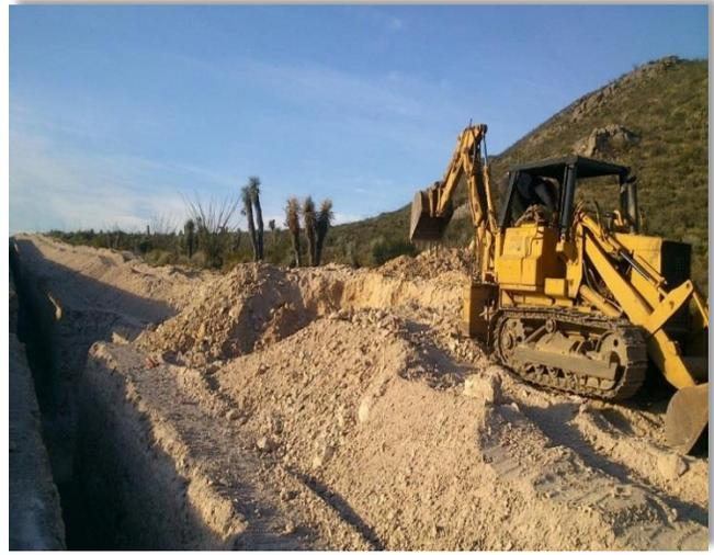
**Fotografía 18.** Se observa la remoción de material producto de la excavación hacia el costado de la excavación en la que se aloja el ducto, a fin de contar con una superficie firme para iniciar con la excavación del Pozo a cielo Abierto (PCA-10) para la válvula MLV-211.
