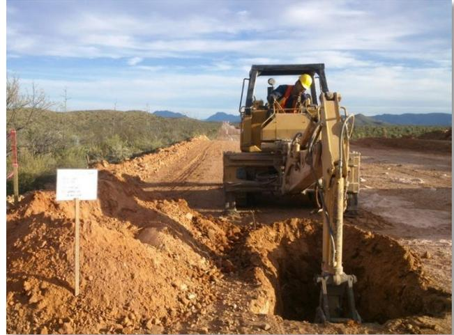
**Fotografía 16.** Material producto de la excavación, alojado al costado del Pozo a Cielo Abierto (PCA-09), clasificándose en el primer estrato como material constituido por Arena arcillosa mal graduada con gravas finas. Dicho material se depositan en el hombro del PCA para su eventual muestreo.
