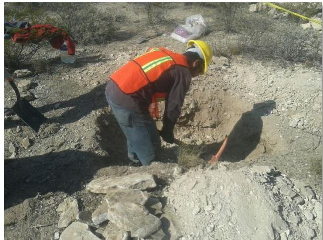
**Fotografía 4.** Vista del área de trabajo debidamente acordonada, la brigada con su respectivo equipo de seguridad, inicia con los trabajos de muestreo considerando que el material sea representado, esto es para el Pozo a Cielo Abierto (PCA-02).
