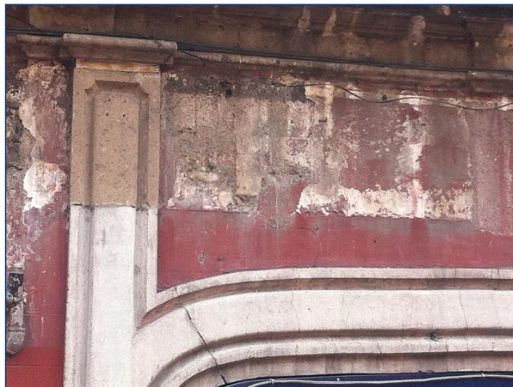
Figura B.1.4. Edificios del centro histórico de la Ciudad de México
