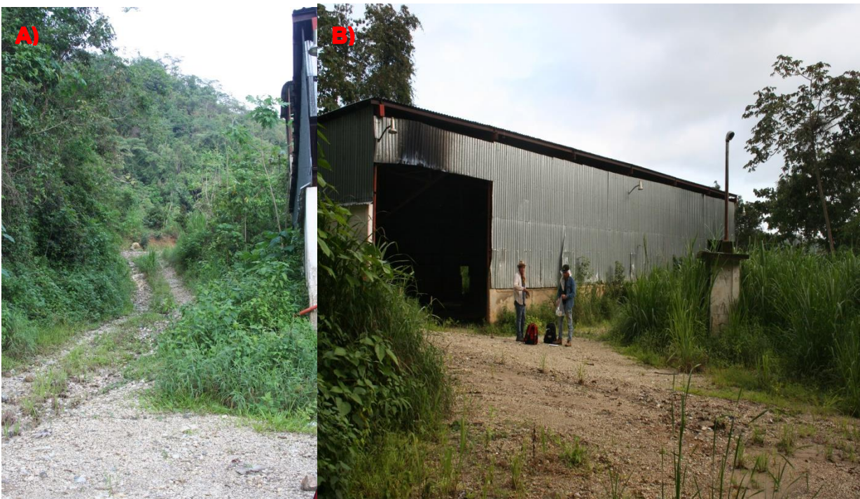
Figura 23. A) Acceso a la planta de beneficio de la Mina Tizúr. B) Planta de beneficio abandonada de la Mina Tizúr.
