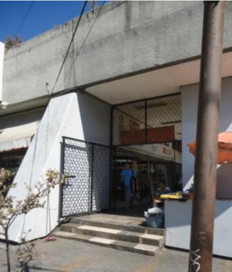
Figura 13; Acceso a Metro Zapata (2014) Emmanuel Tapia Mendoza.
