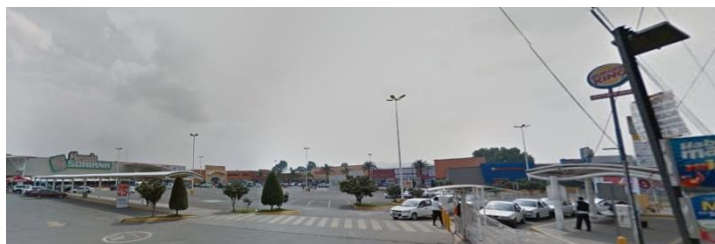
Plaza Comercial Galerías Chicoloapan
