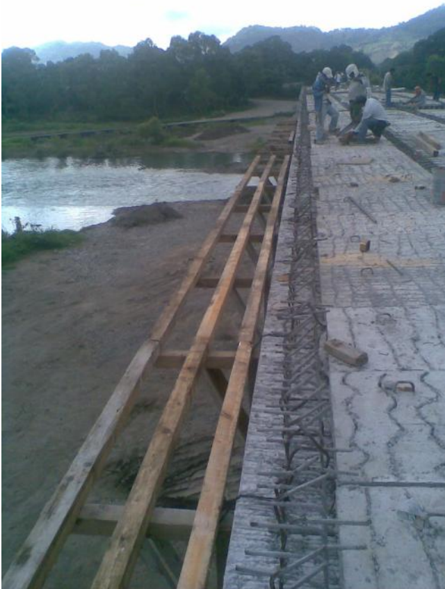
Foto No. 115 y 116 Cimbrado de volados de losa sujetos a trabe.
