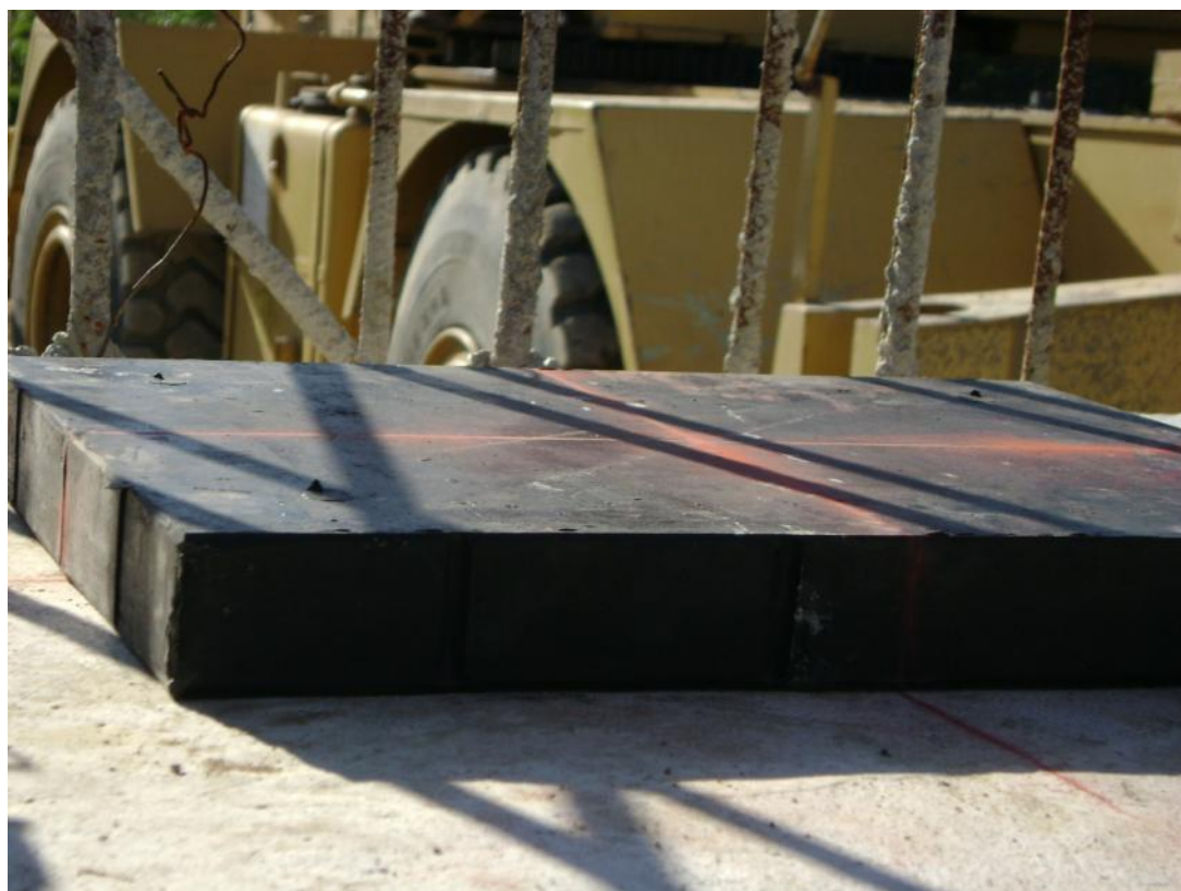
Foto No. 98 Neopreno colocado en banco de apoyo y el trazo tanto en neopreno como en banco para referenciar bien la colocación de este.
