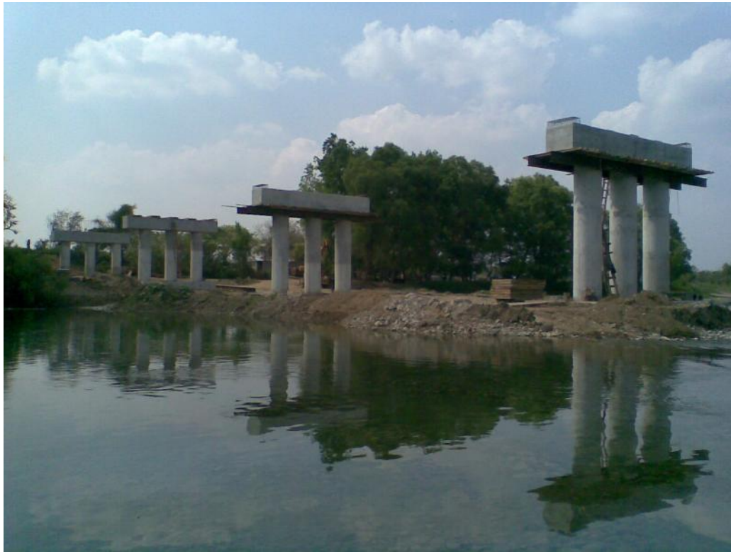
Foto No. 75 Imagen panorámica de varios cuerpos de pilas construidas
