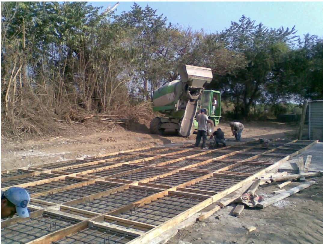
Foto No. 102 Cimbrado de varias prelosas y al fondo se está colando.
