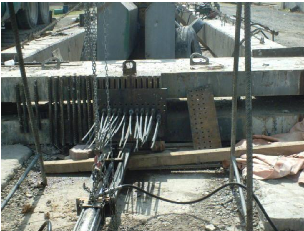
Foto No. 78 Se observa el tensado del presfuerzo de la trabe.
