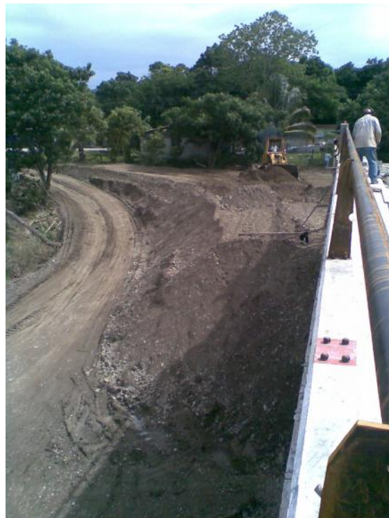
Foto No. 152 y 153 Colocadas las pilastras en guarnición para después colocar las tuercas.
