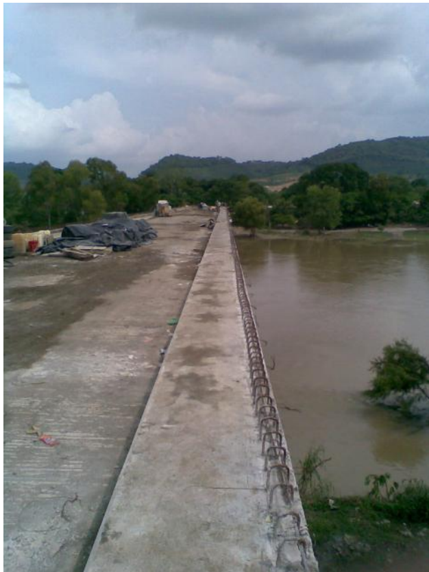
Foto No. 143 y 144 Banquetas coladas desde un extremo al otro
