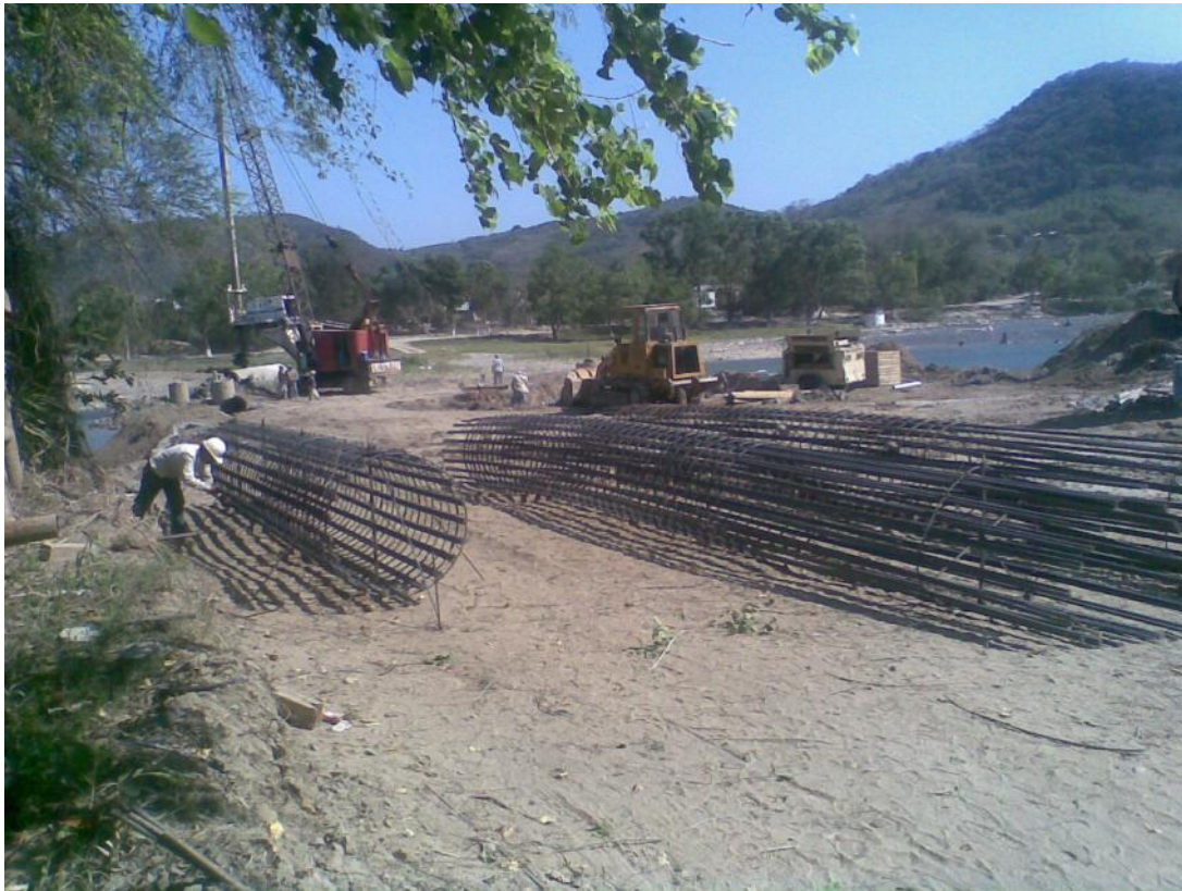
Foto No. 23 Reforzando armado para poder ser izado por la maquina.
