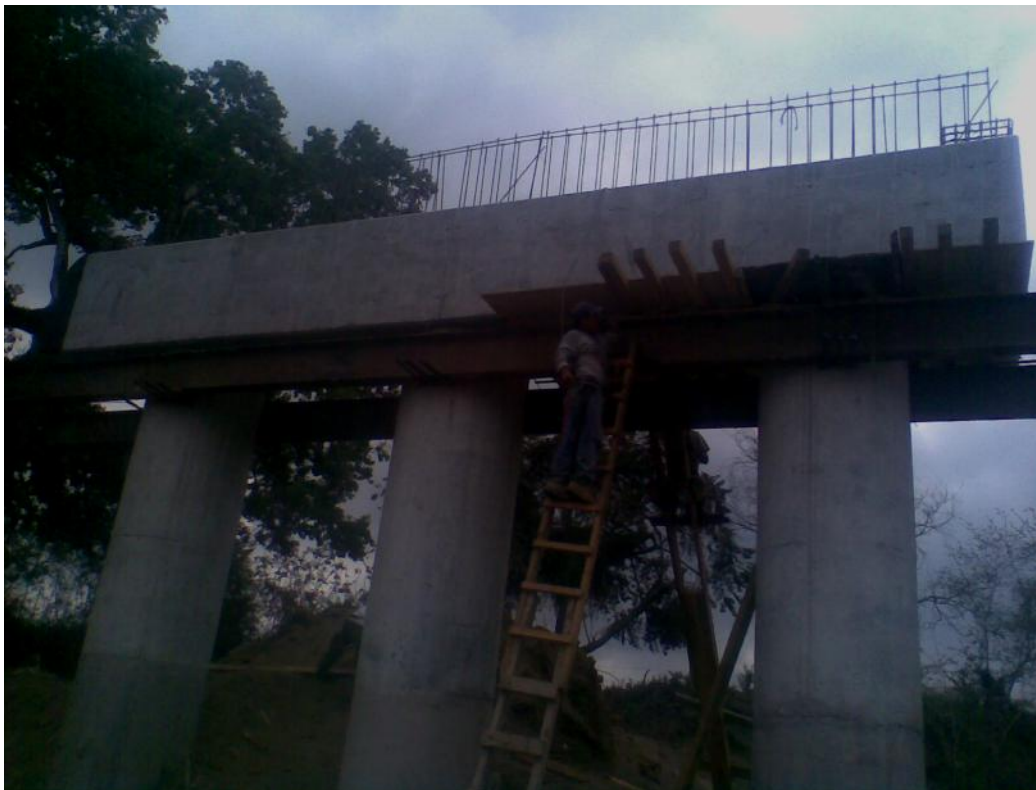
Foto No. 62 Descimbrado de cabezal de caballete
