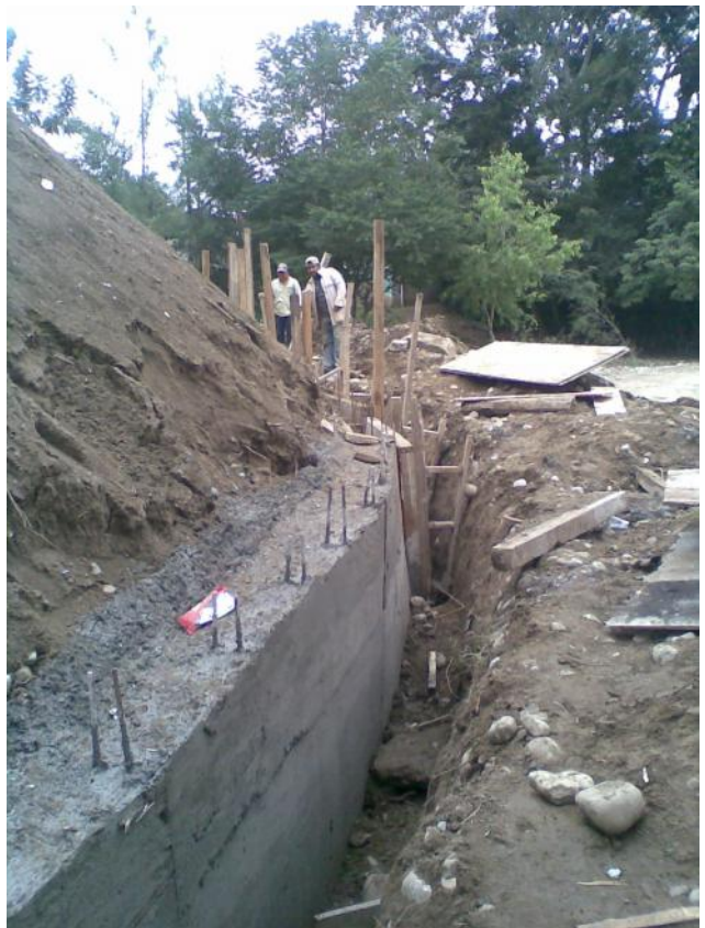
Foto No. 188 y 189 Terminado el dentellón y cimbra de este.
