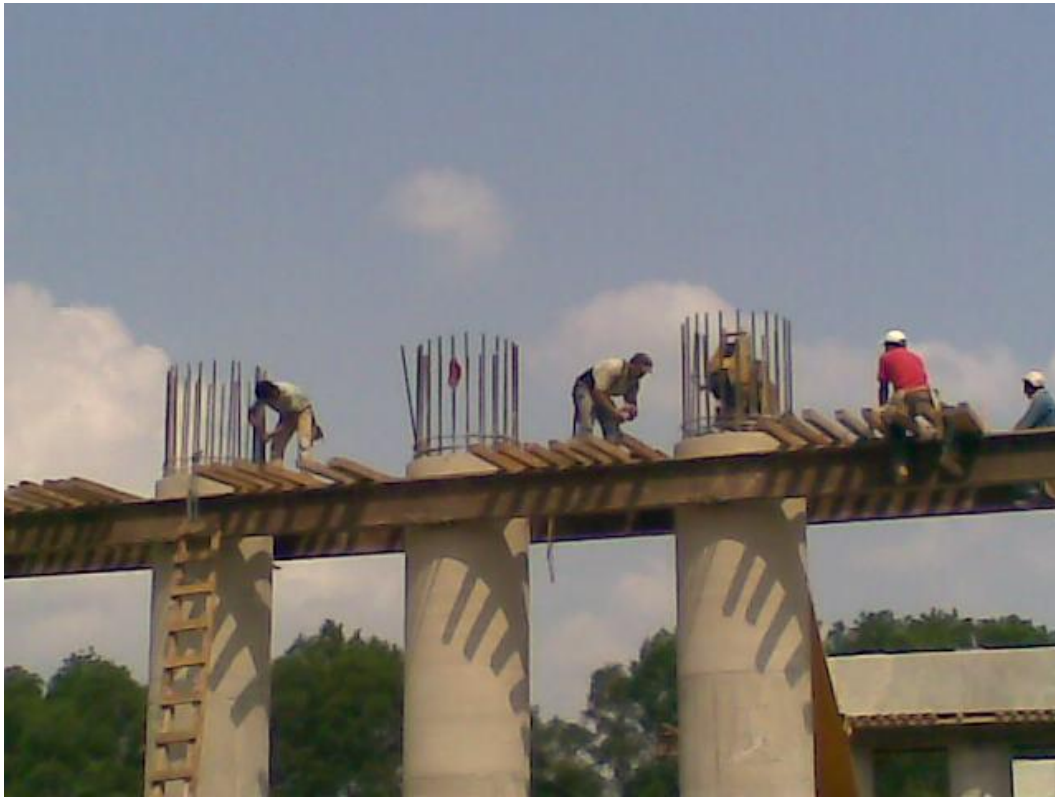
Foto No. 65 Carpinteros cimbrando el fondo del cabezal de cuerpo de pila.
