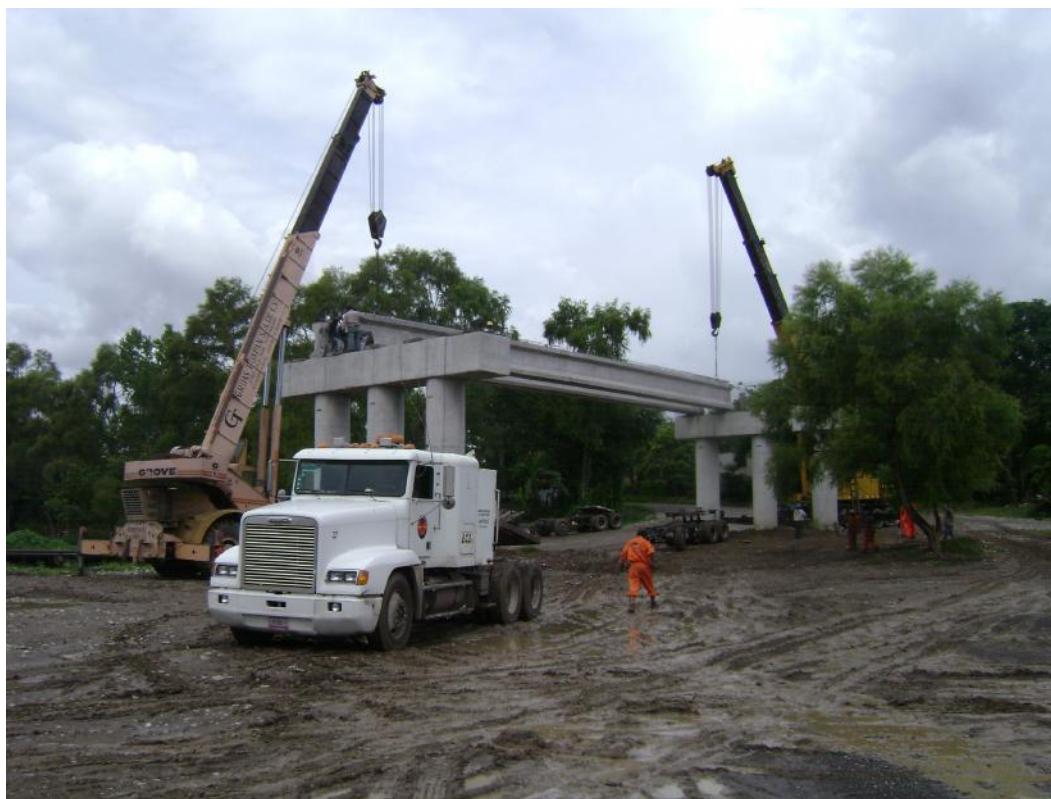
Foto No. 92 Colocando traves de la margen derecha del caballete 1 al 2, en malas condiciones del terreno por las lluvias excesivas de días anteriores y crecimiento del río.
