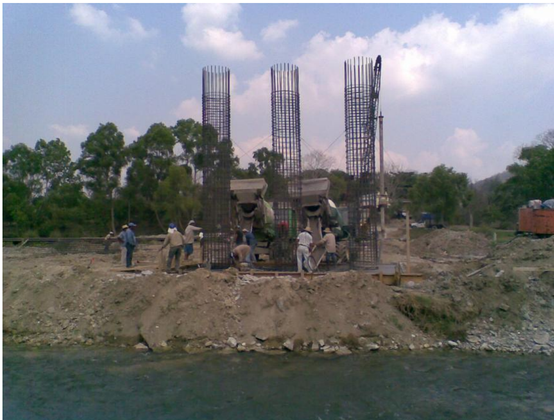
Foto No. 41 Imagen de vaciado de concreto con dos autohormigoneras en zapata.
