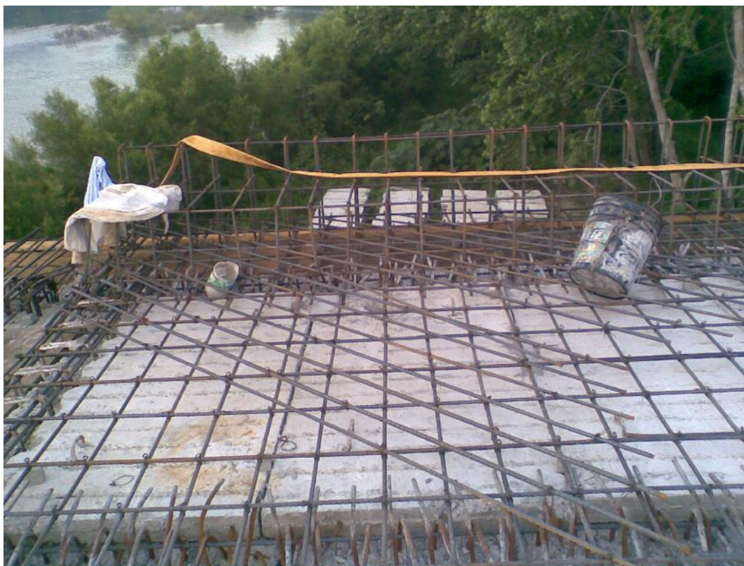
Foto No. 120 Refuerzos en las esquinas de la losa.
