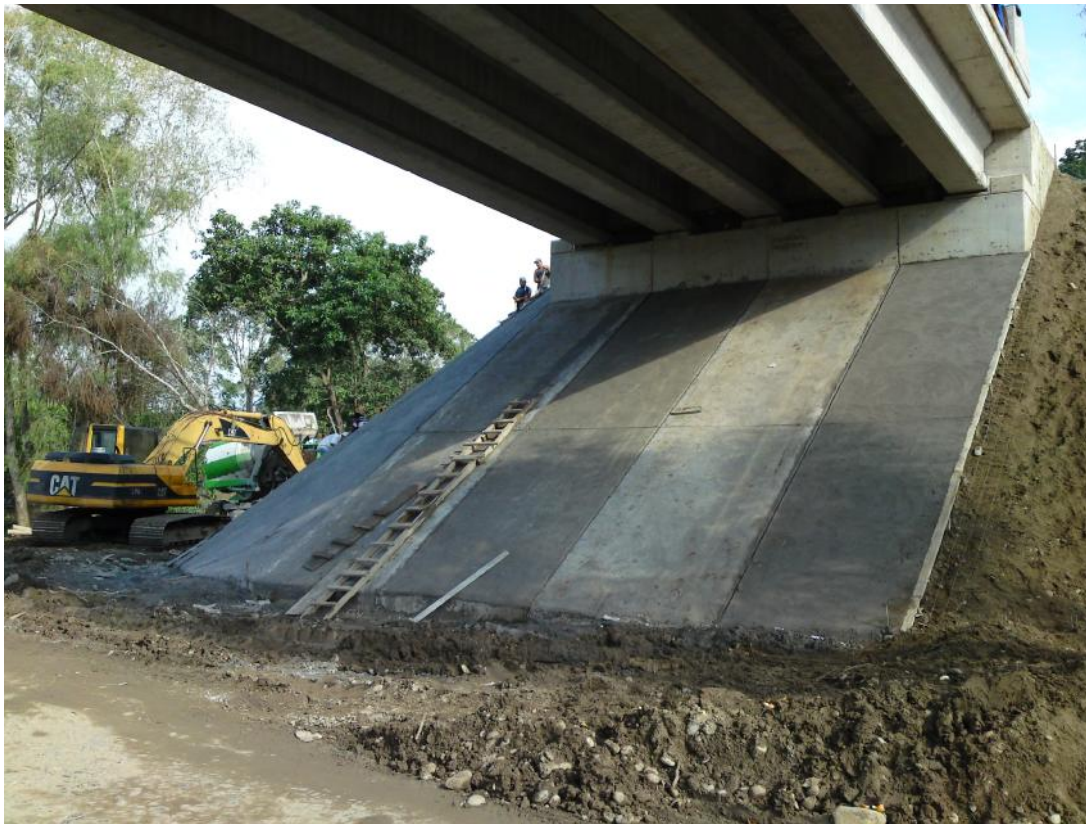
Foto No. 191 Se muestra losas debajo de cono de derrame del apoyo 1.
