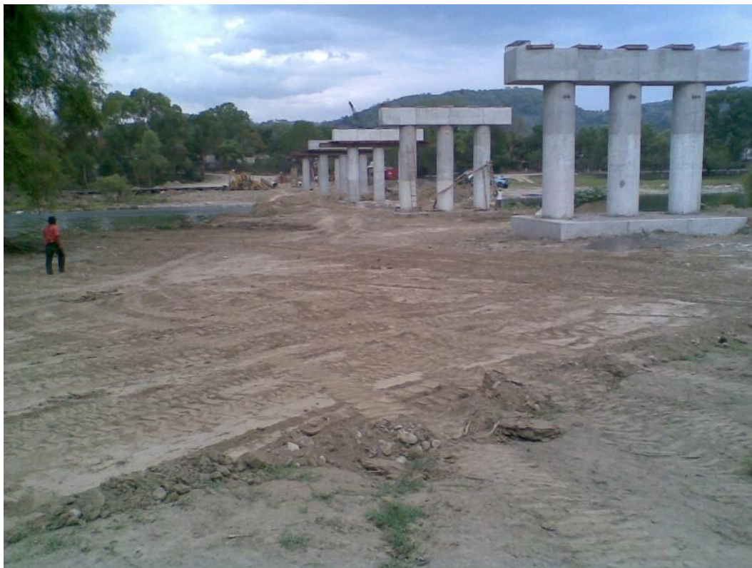
Foto No. 76 En esta imagen se observa el proceso de avance en la construcción de pilas y se puede ver el proceso en cada pila y se puede ver que fue constante la construcción.
