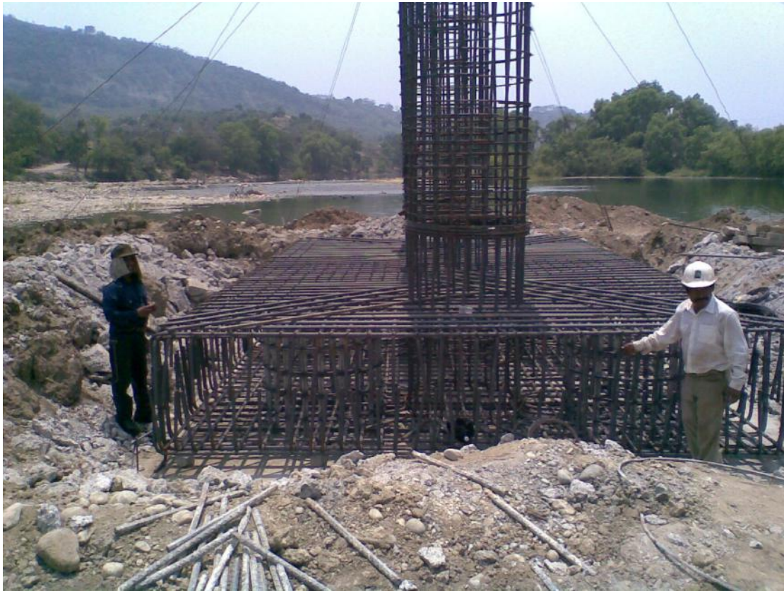
Foto No. 38 Se observa el armado de la zapata en perfil.
