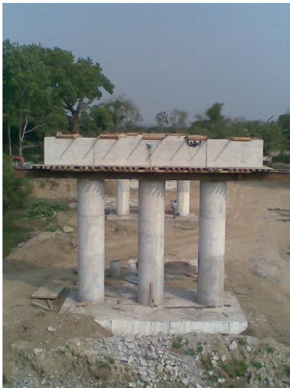
Foto No. 73 y 74 Cimbrado y armado de bancos y topes sísmicos.
