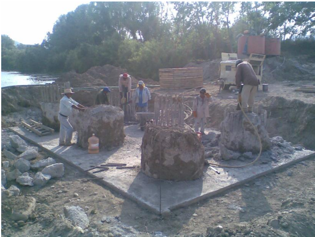
Foto No. 33 Demolición de pilotes de apoyos intermedios
