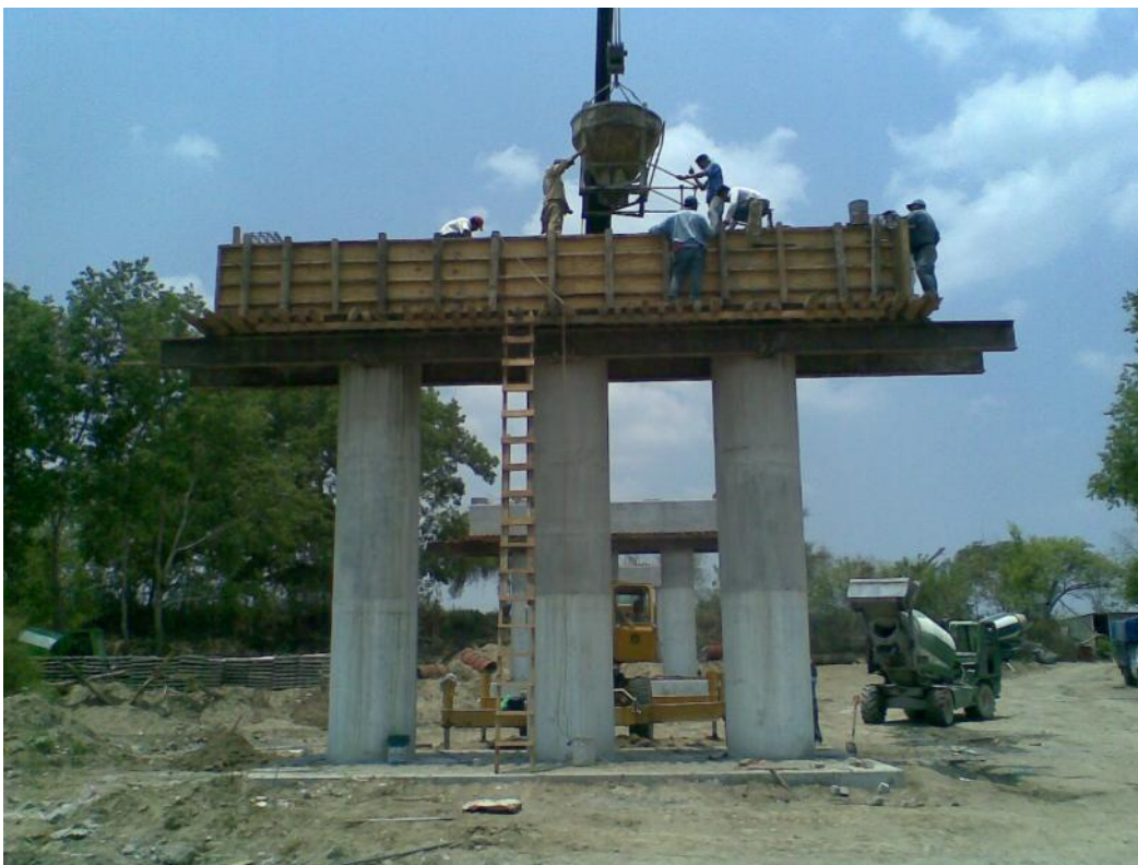
Foto No. 71 Colado de cabezal con bacha de un apoyo intermedio.
