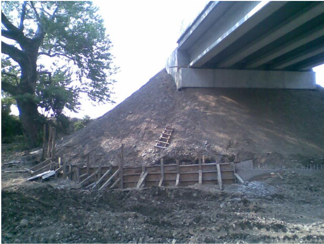
Foto No. 182 El dentellón del apoyo 8 cimbrado y en una parte colado.
