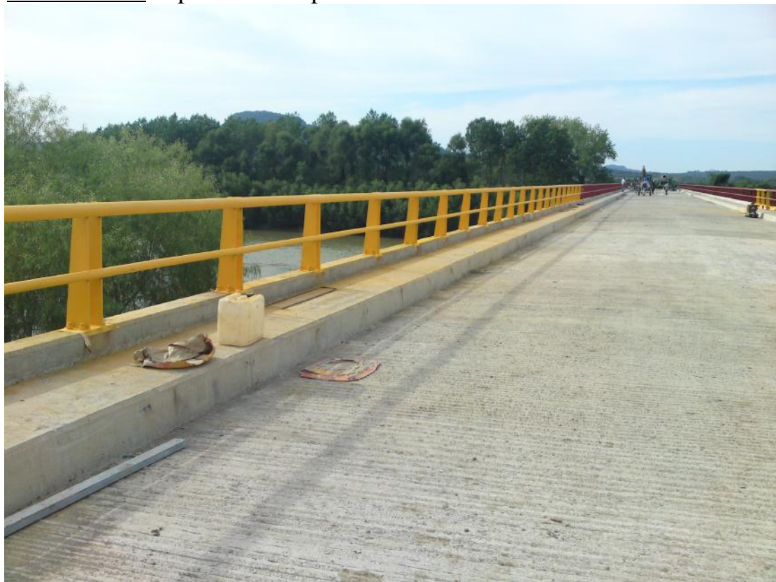
Foto No. 159 Aplicación de pintura de acabado en color amarillo tráfico.
