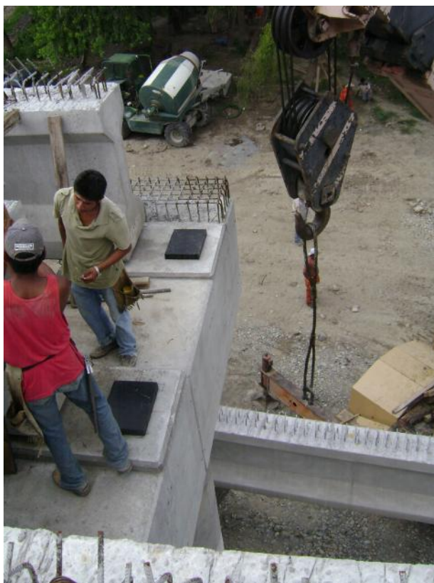
Foto No. 100 Aquí se observa la colocación de neoprenos para recibir las traves es muy importante ver dónde van los apoyos fijos y móviles.
