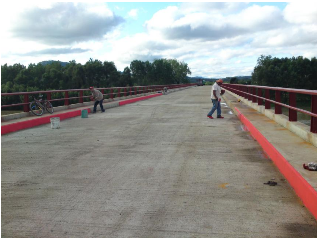
Foto No. 161 Aplicación de pintura de acabado en color rojo por indicaciones del cliente.
