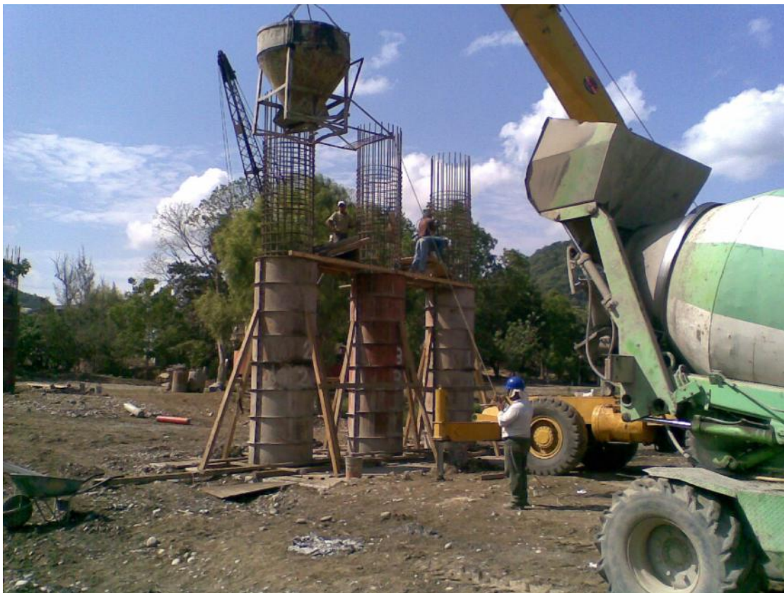
Foto No. 55 Se observa el colado de columnas por medio de bacha y grúa telescópica
