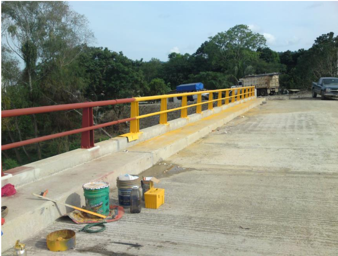
Foto No. 159 Aplicación de pintura de acabado en color amarillo tráfico.
