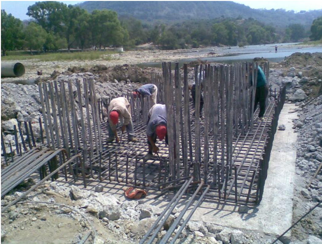
Foto No. 36 Se observa casi terminada la parrilla inferior de la zapata, solo están amarrando.
