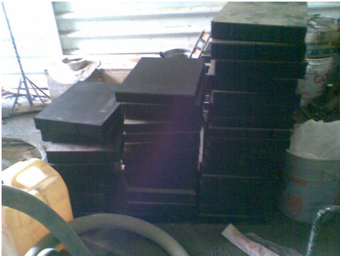
Foto No. 97 Se observa varios neoprenos en bodega para ser colocados para el montaje de trabes.
