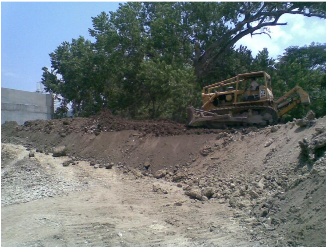
Foto No. 166 Terraplén con un avance del 80 % y como se puede ver contiene mucho boleó.
