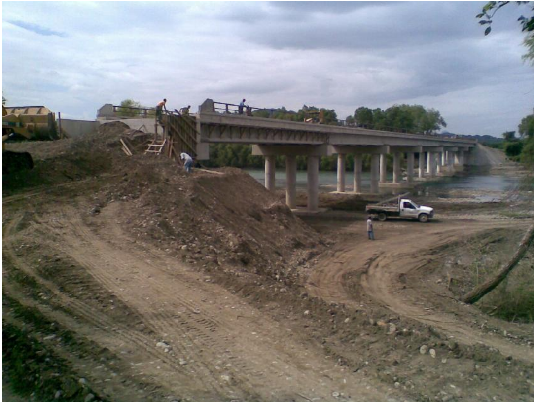
Foto No. 177 Se apoya con traxcavo para bandear y conformara el terraplén.
