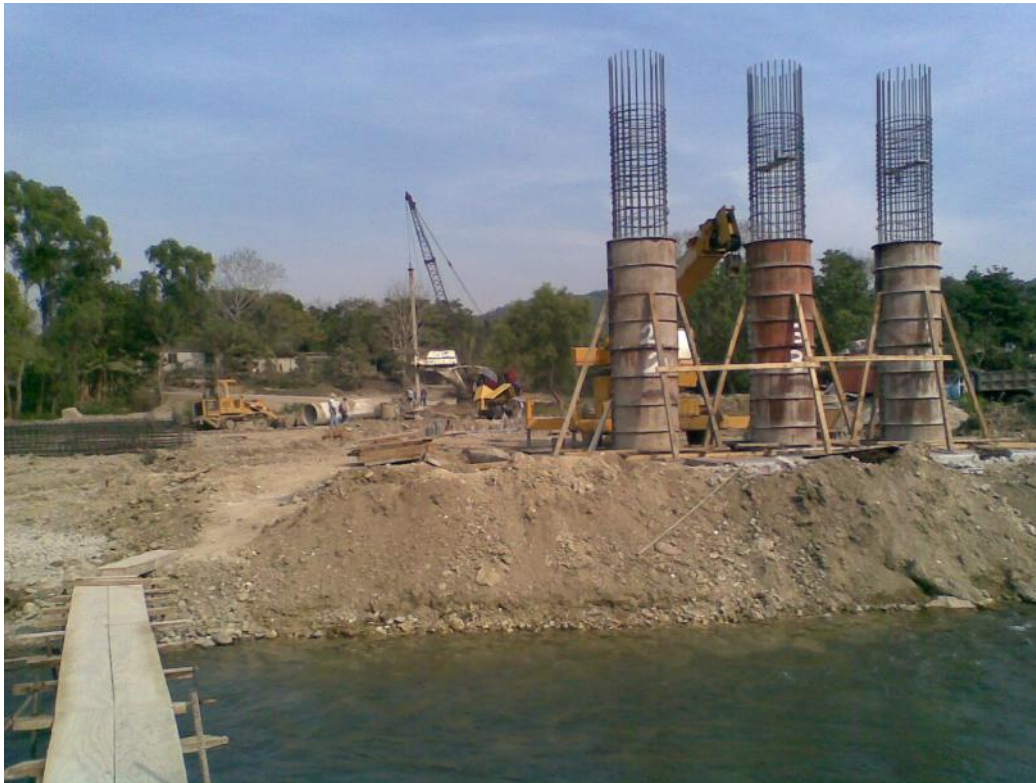
Foto No. 52 Se observa el cimbrado de otras tres columnas en las pilas intermedias.
