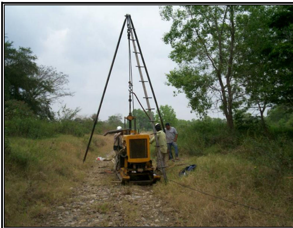
FOTO No. 8 PERSONAL TRABAJANDO EN EL SONDEO S-5
