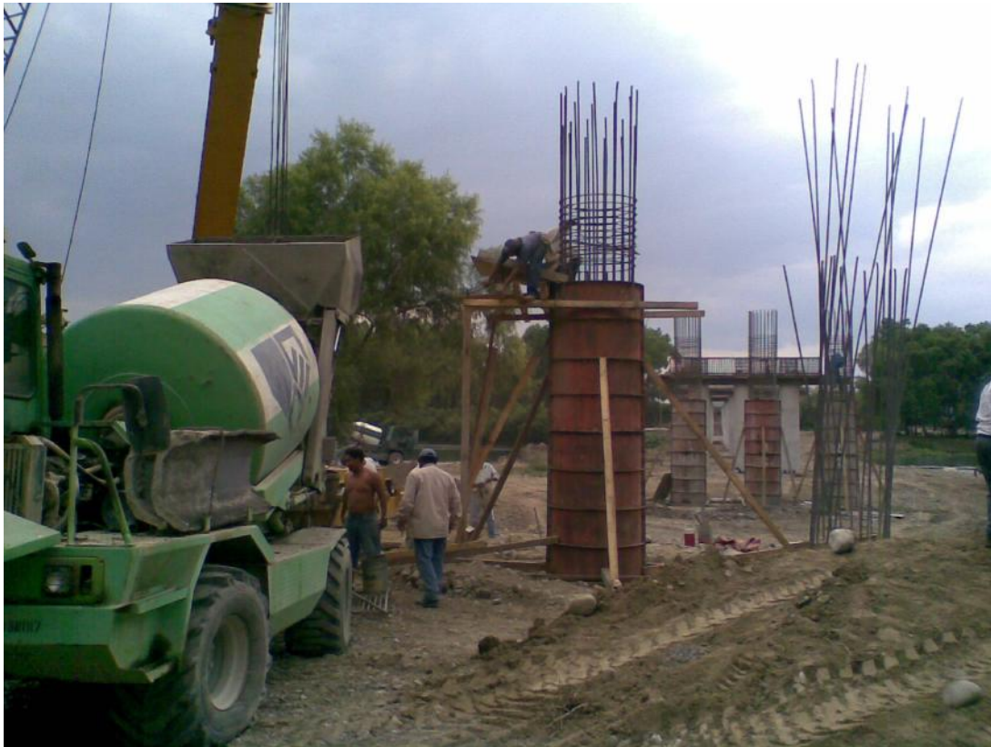
Foto No. 54 Se cimbra columnas de caballete No. 1
