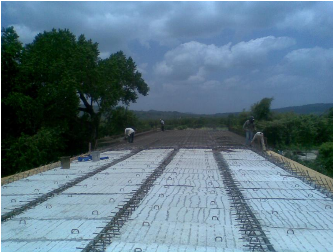
Foto No. 117 Armado de losa y una losa limpia esperando ser armada.
