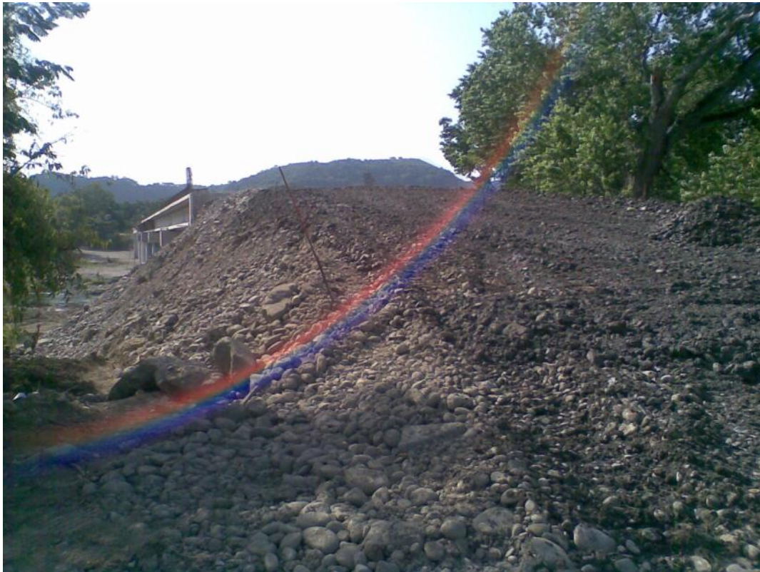
Foto No. 168 Se muestra la cantidad de boleo que contiene el terraplén atrás del caballete 8.
