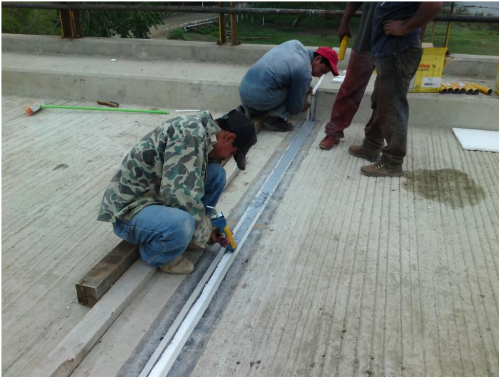
Foto No. 133 En cuanto se termina de realizar limpieza sobre la losa se comienza a colocar el Sikaflex 1-A en la junta de dilatación.
