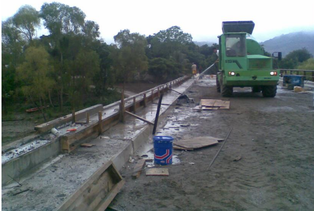
Foto No. 146 Terminado de colar la guarnición
