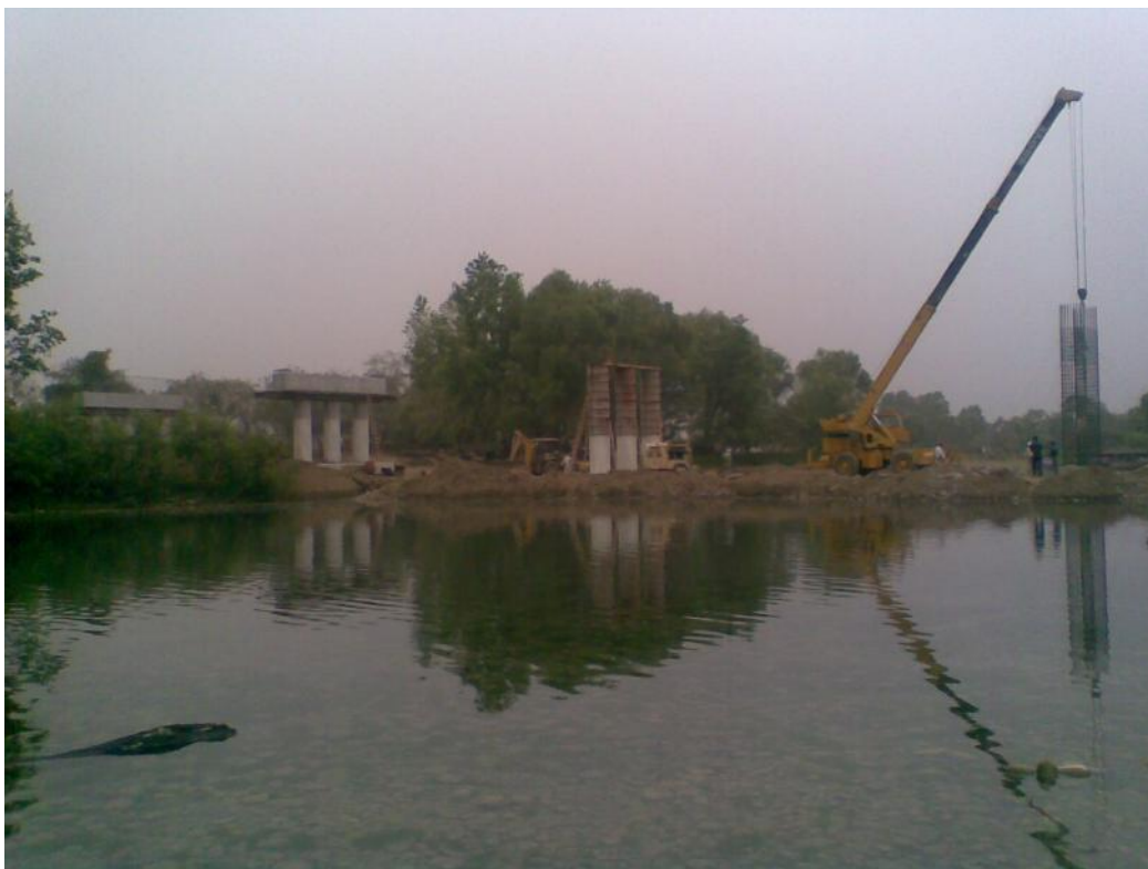
Foto No. 57 Se observa una imagen general de colocación de las columnas de acero y otras columnas coladas y a la espera de descimbrar.
