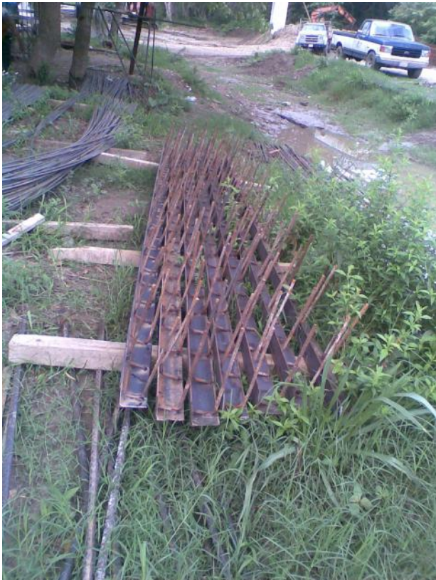
Foto No. 123 Acero estructural de la junta de dilatación y se observa ya colocada con la junta de unicel.
