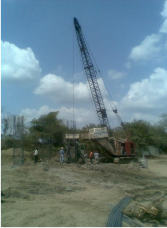
Foto No. 25 Inmediatamente de haber colocado el armado en pilote se coloca el concreto con resistencia de acuerdo a proyecto, esto con la finalidad de que no se presente caídos.
