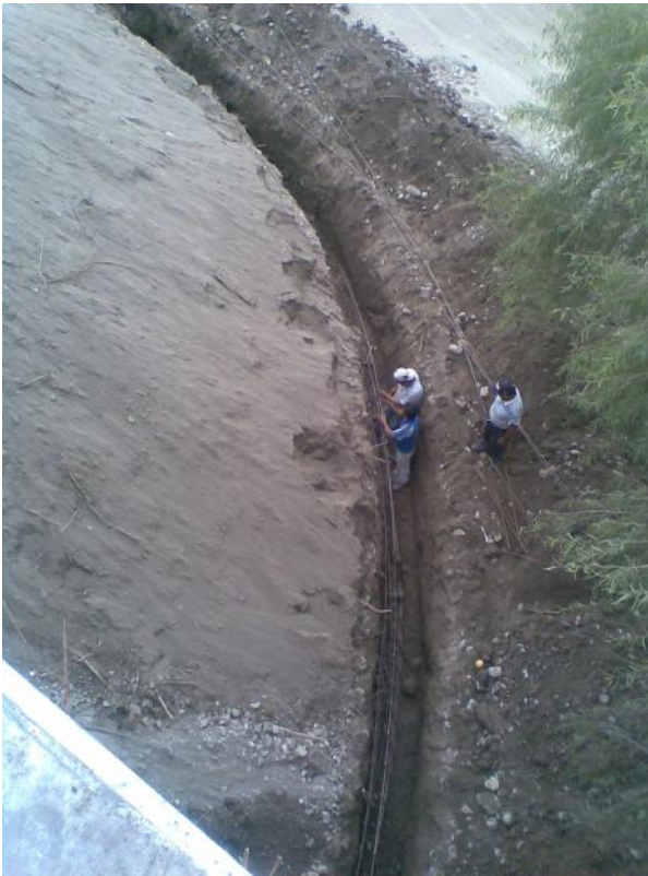
Foto No. 186 y 187 Excavación de dentellón, armado de este y cimbra
