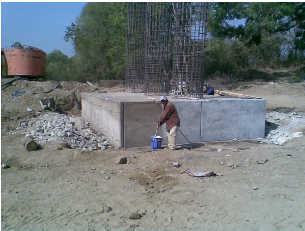
Foto No. 45 Se le coloca inmediatamente que se descimbra el curacreto para que no pierda humedad el concreto.
