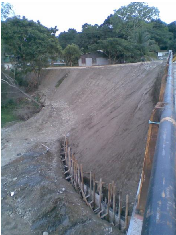
Foto No. 188 y 189 Terminado el dentellón y cimbra de este.
