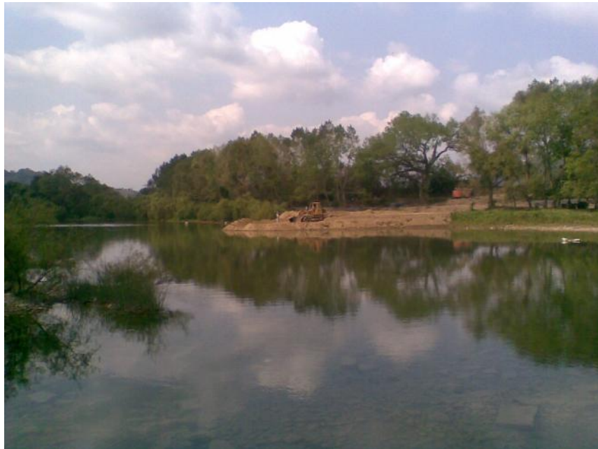
Foto No. 12 Se observa la creación de plataforma y penínsulas en el eje del trazo
