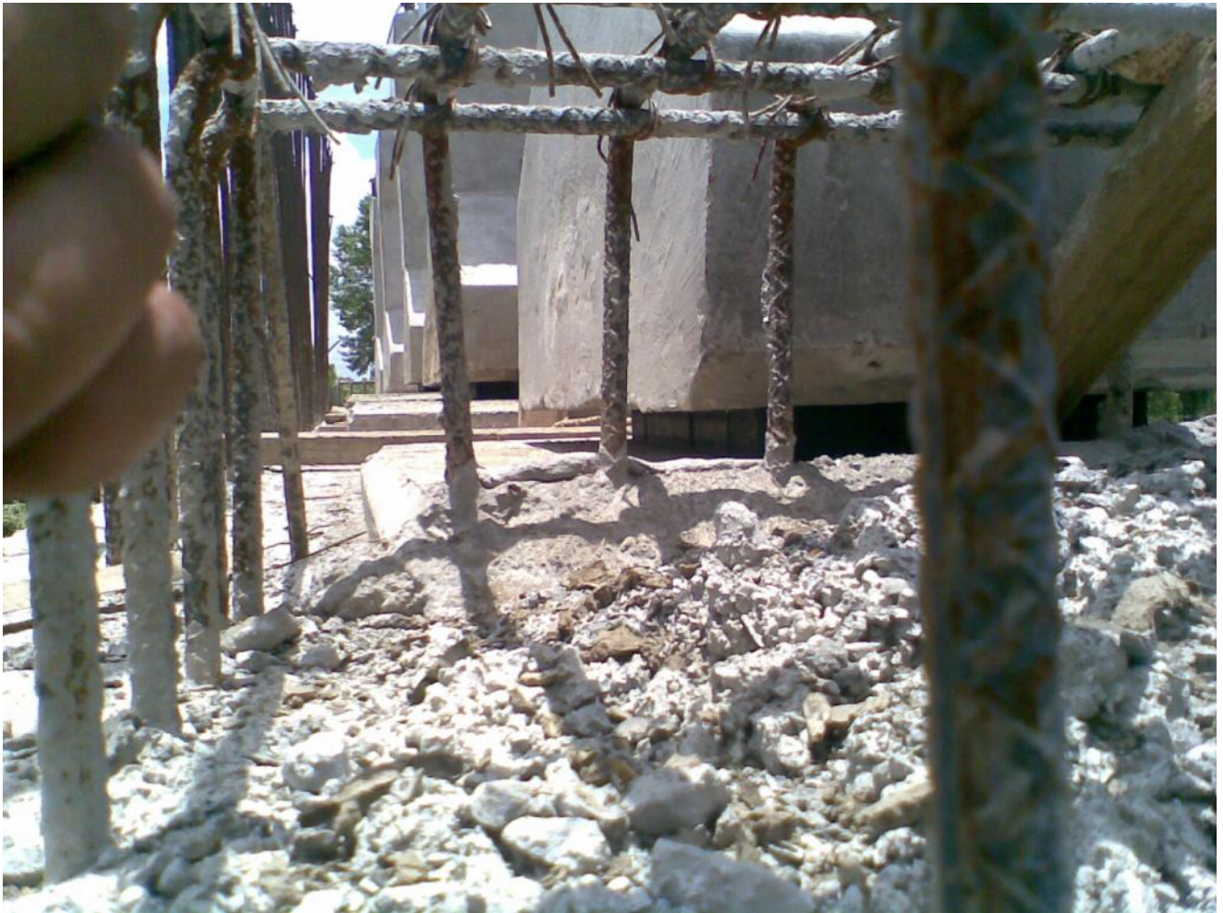
Foto No. 101 En esta imagen se observa ya las trabes colocada encima del neopreno.
