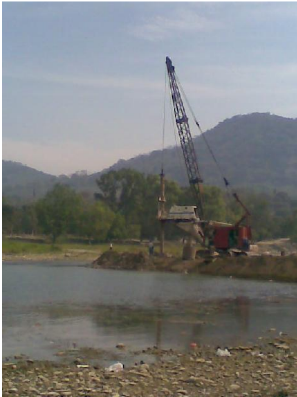
Foto No. 19 Se observa la perforación de pilotes sobre península en apoyo intermedio, en la cual se observa que se está colocando ademe metálico, para proteger los derrumbes de boleas.
