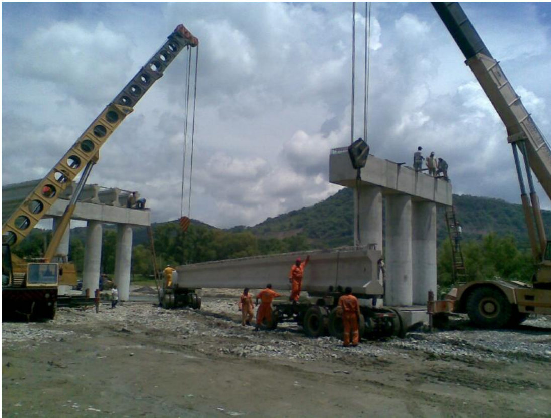
Foto No. 87 El suelo presenta mucha humedad por las lluvias sucedidas unos días antes por eso la necesidad de revestir los accesos para montar las traveses.
