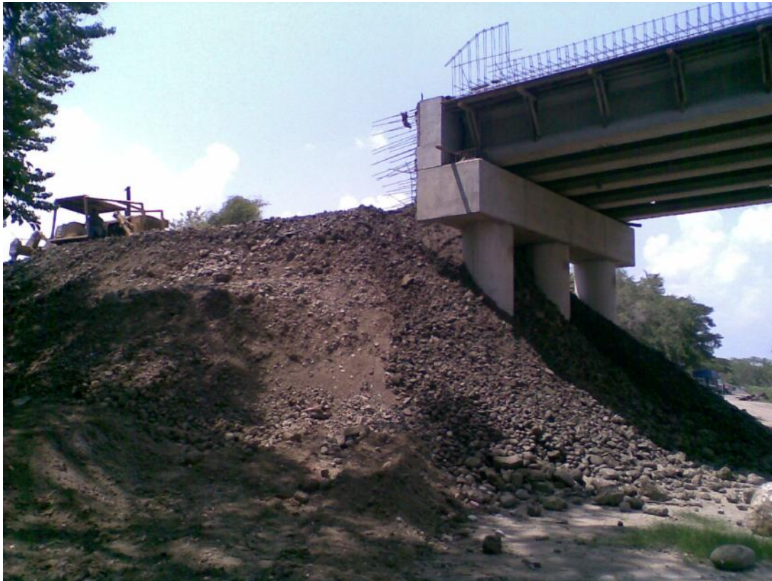
Foto No. 166 Terraplén con un avance del 80 % y como se puede ver contiene mucho boleó.
