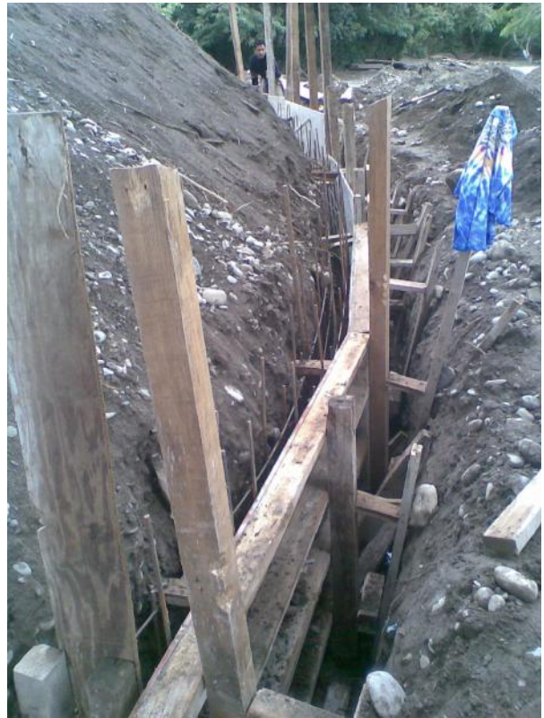
Foto No. 186 y 187 Excavación de dentellón, armado de este y cimbra
