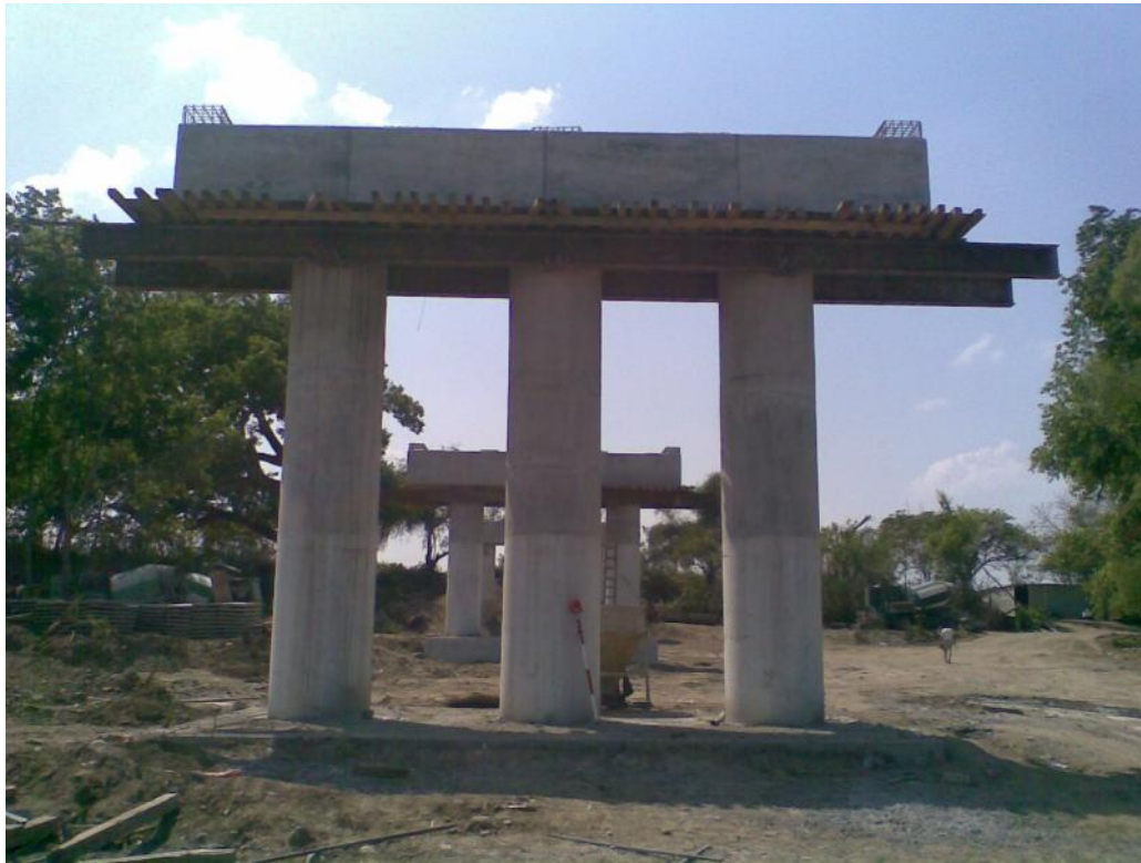
Foto No. 72 Se observa cuero de pila y cabezal completos.
