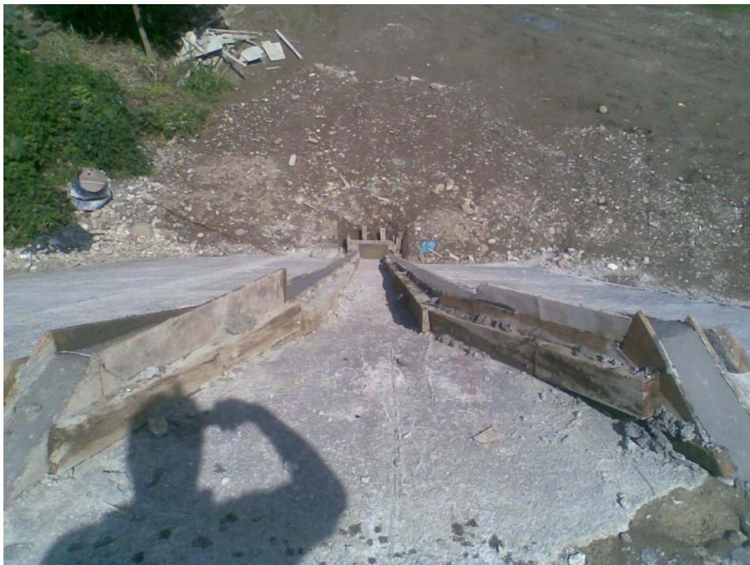
Foto No. 196 Lavadero colado del apoyo 1.
