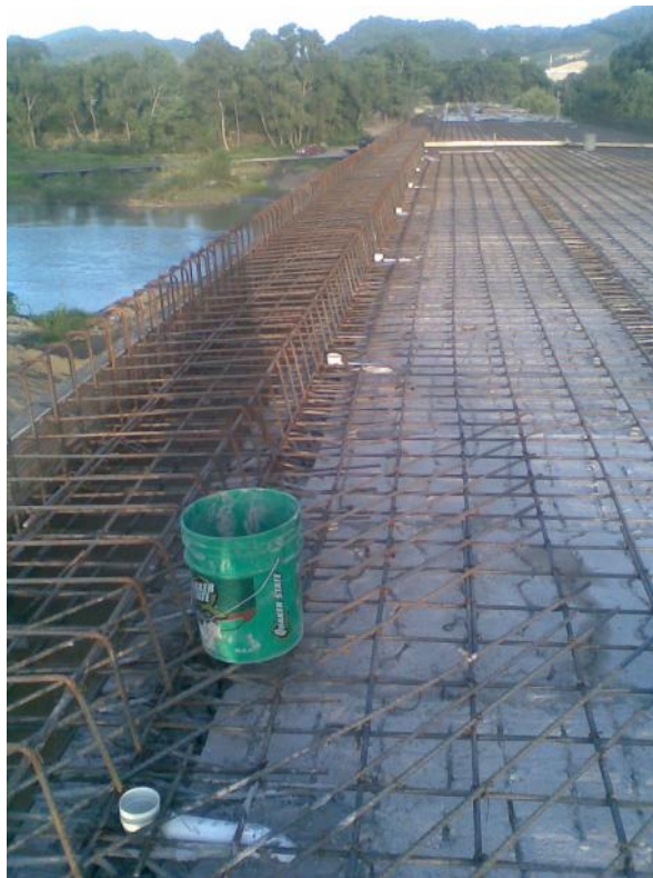
Foto No. 135 y 136 El armado de guarniciones y banquetas, así como el volado de losa
