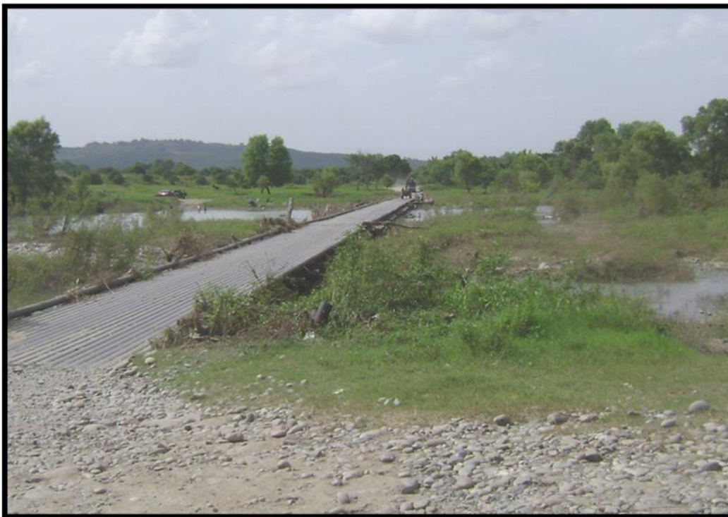
Foto No. 4 Vista general del sitio del cruce
