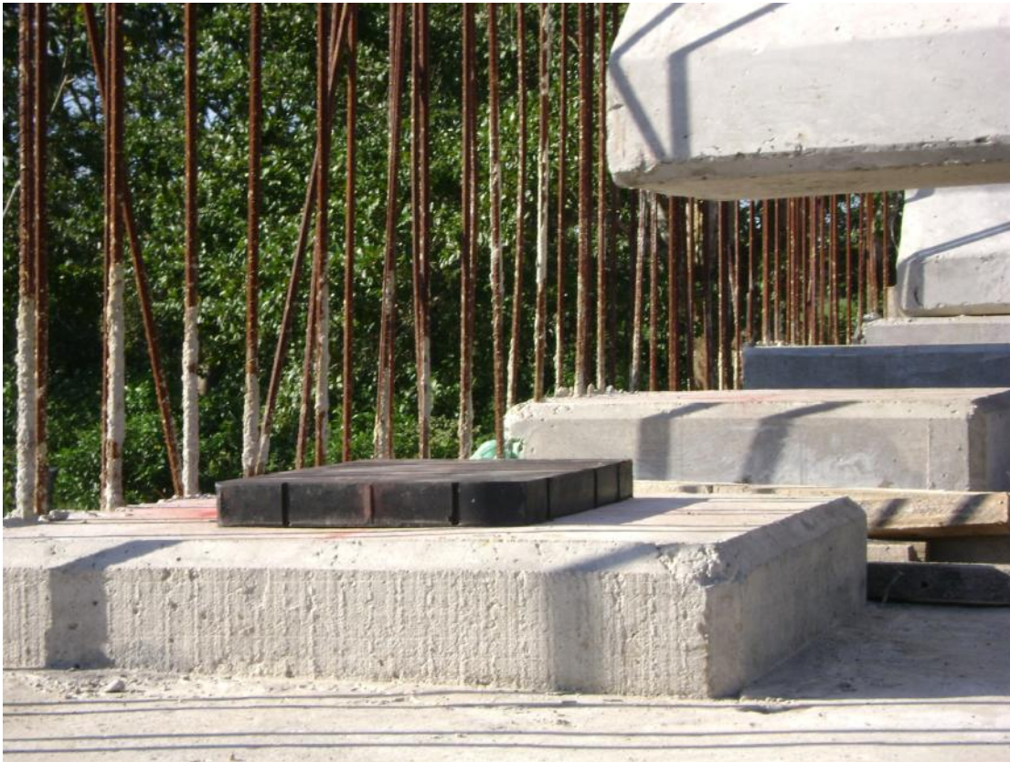
Foto No. 99 Neopreno sobre el banco para recibir la trabe.
