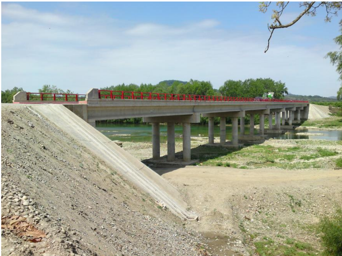
Foto No. 198 Se muestra terminado el puente y lavadero en apoyo 1.
