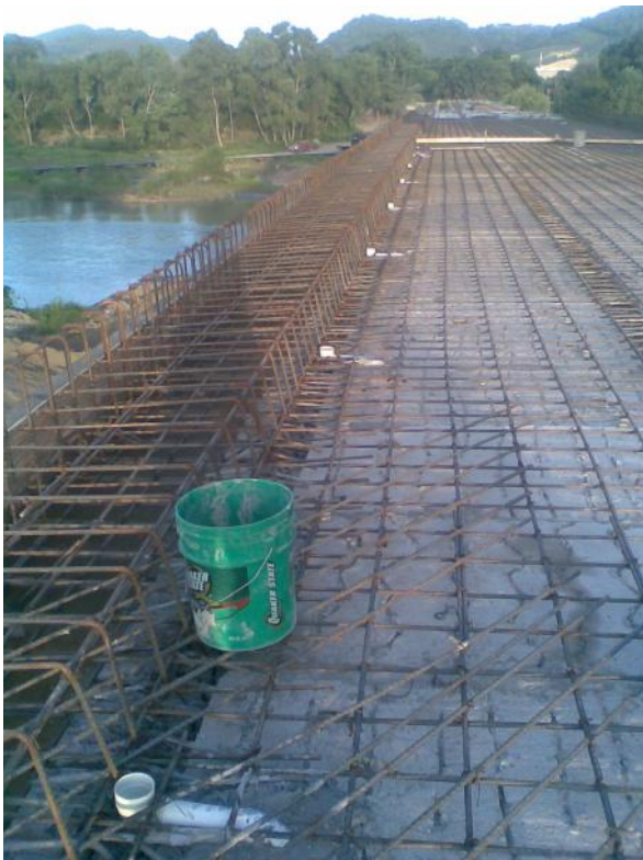
Foto No. 121 Ya se tiene el armado en su totalidad y se están armando las siguientes trabes.
