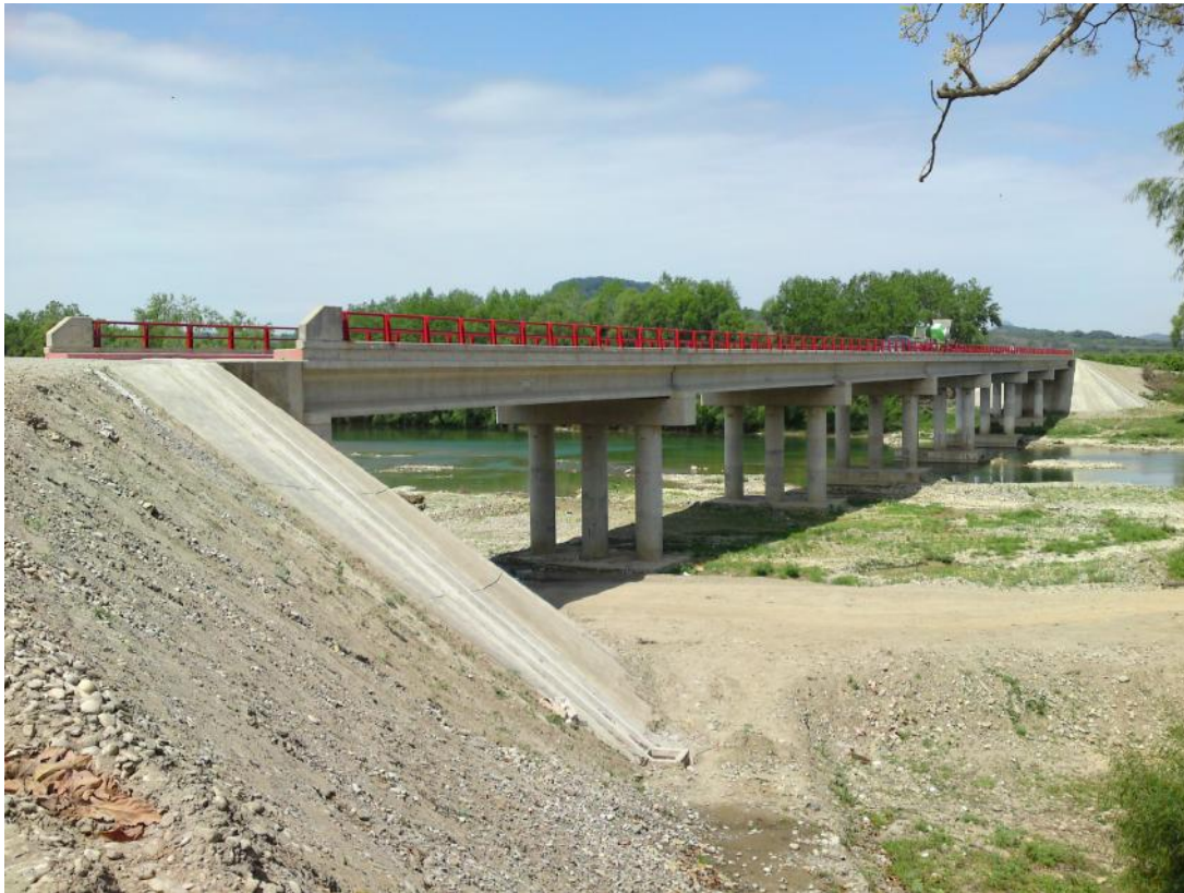
Foto No. 163 Puente terminado con parapetos completos y con acabado en rojo.
