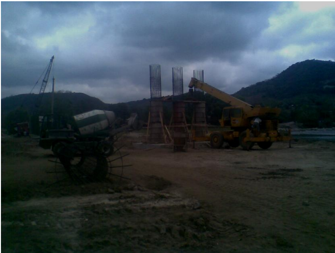
Foto No. 51 Se prepara el vaciado de concreto en las columnas, con concreto elaborado en sitio con autohormigonera.
