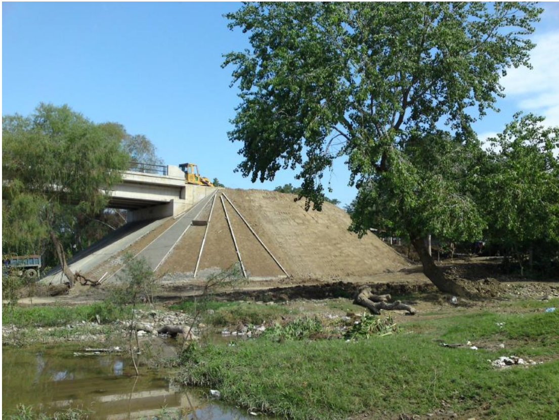
Foto No. 192 Cimbrado de losas de cono de derrame aguas arriba apoyo 1.
