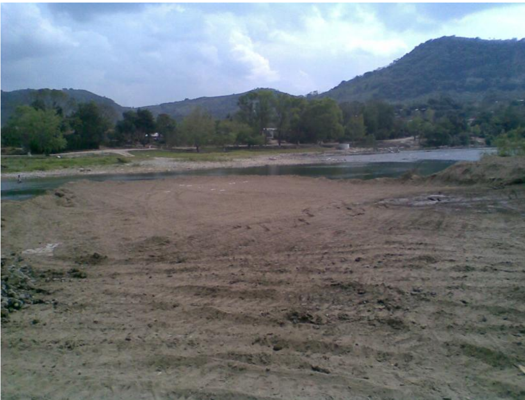
Foto No. 14 Se observa la plataforma parcialmente terminada y se puede ver al fondo lo puntos a perforar de la pila No. 6
