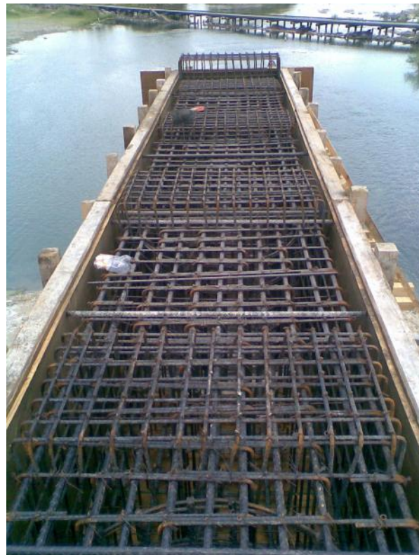
Foto No. 68 y 69 Se observa que los fierros están terminando de armar los bancos de apoyo y topes sísmicos.
