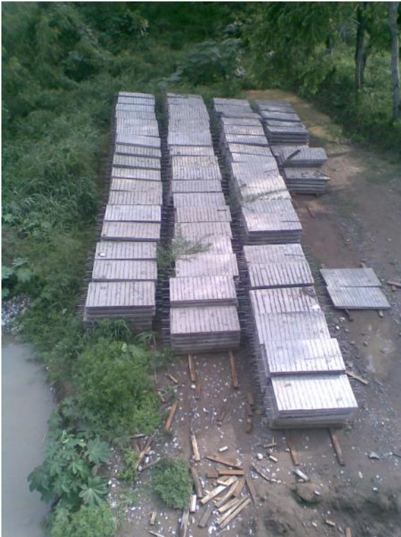
Foto No. 104 y 105 Prelasas Estibadas y con ayuda de draga o grúa se colocan prelasas, acercadas en un camión, para agilizar el montaje de estas.
