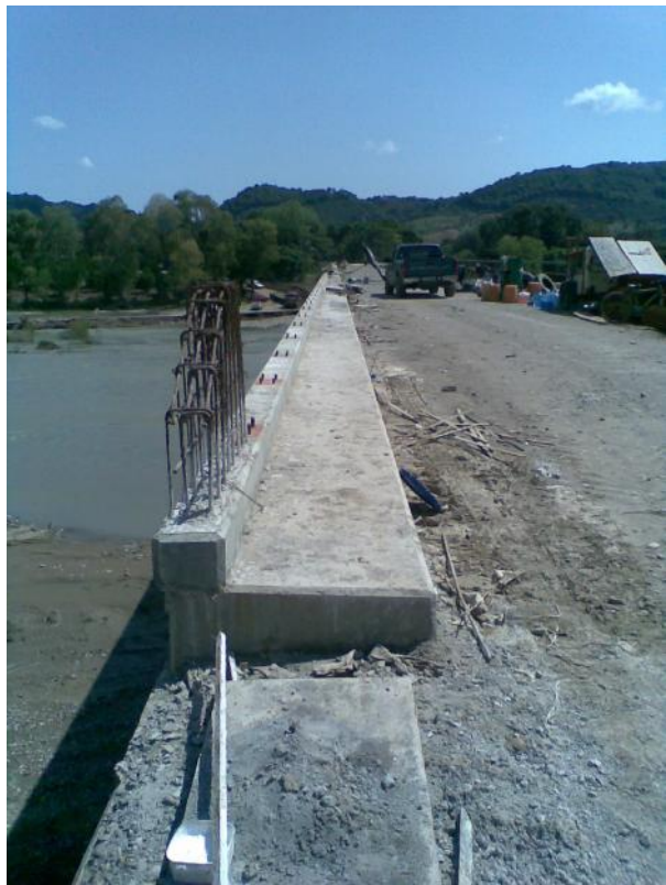
Foto No. 147 y 148 Se observa guarniciones terminadas y se puede observar que cuentan con chaflanes y están bien alineadas.
