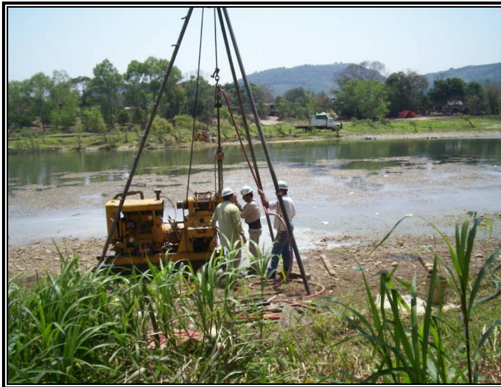
FOTO No. 7 VISTA DE LA EXPLORACION EN EL SONDEO S-4
