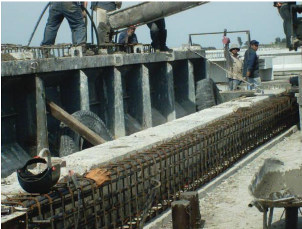
Foto No. 80 El proceso de vaciado del concreto debe iniciar de un extremo, llenando hasta arriba e ir nivelando conformando el concreto, hasta salir al otro extremo.
