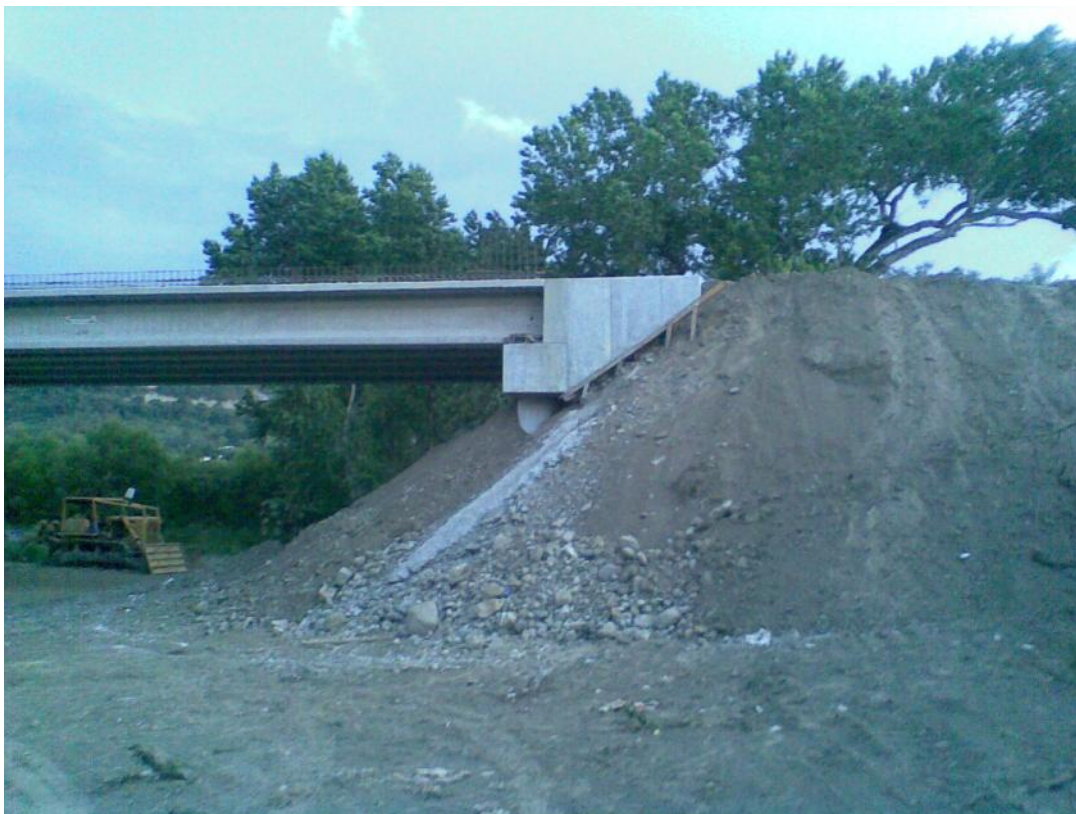
Foto No. 171 El terraplén casi en su totalidad, faltando recargar en el cono de derrame.
