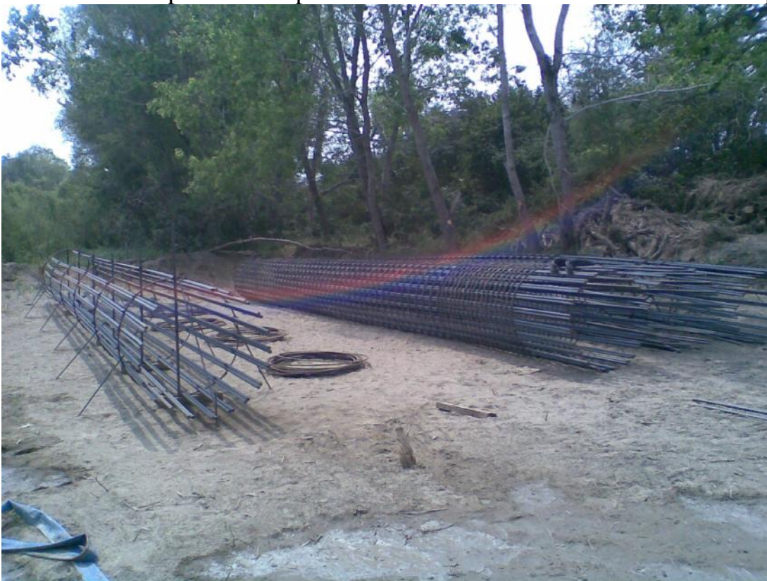
Foto No. 22 Elaboración de pilotes en área determinada, de acuerdo como indica el proyecto.
