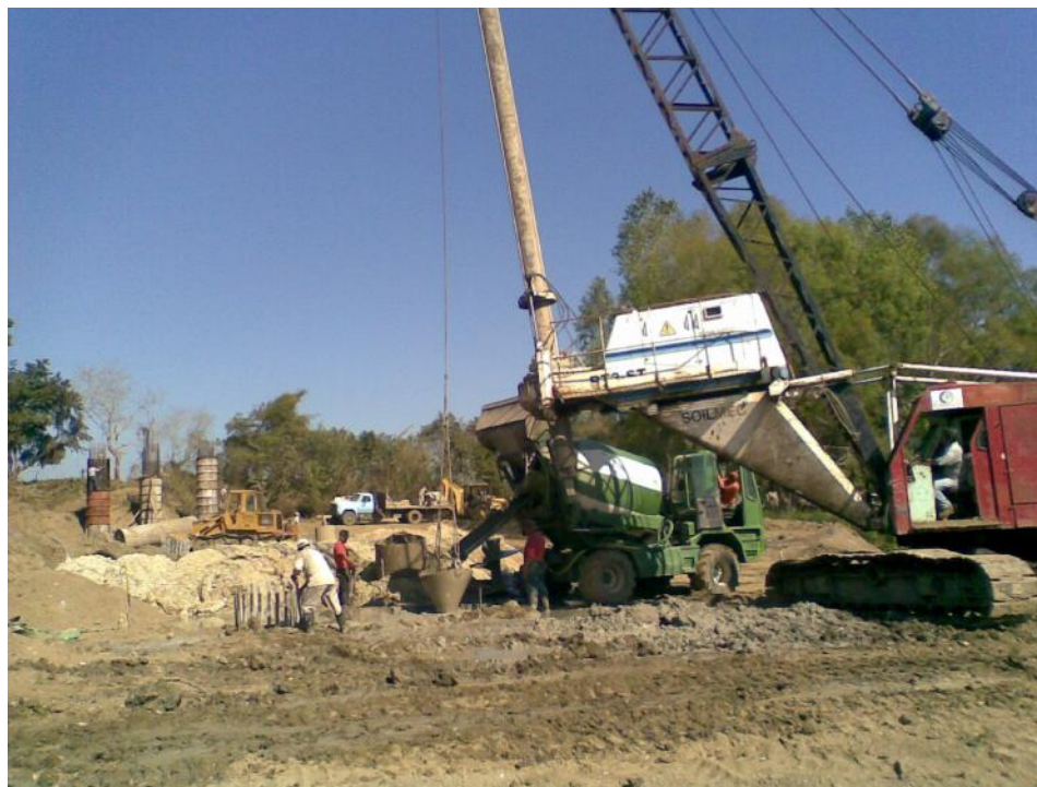
Foto No. 18 Se observa el colado de un pilote con autohormigonera, concreto hecho en obra para más rapidez ya que las concreteras mas cercanas estaban a mas de 100 Km de distancia.
