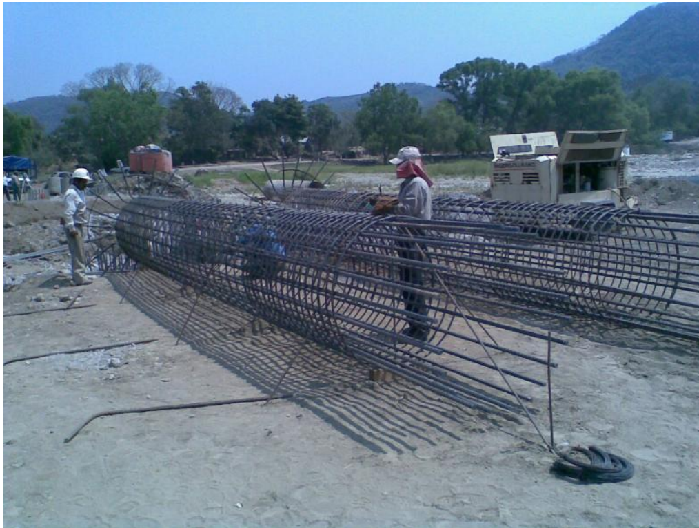
Foto No. 46 Armado de columnas con escuadras, como indica el proyecto.
