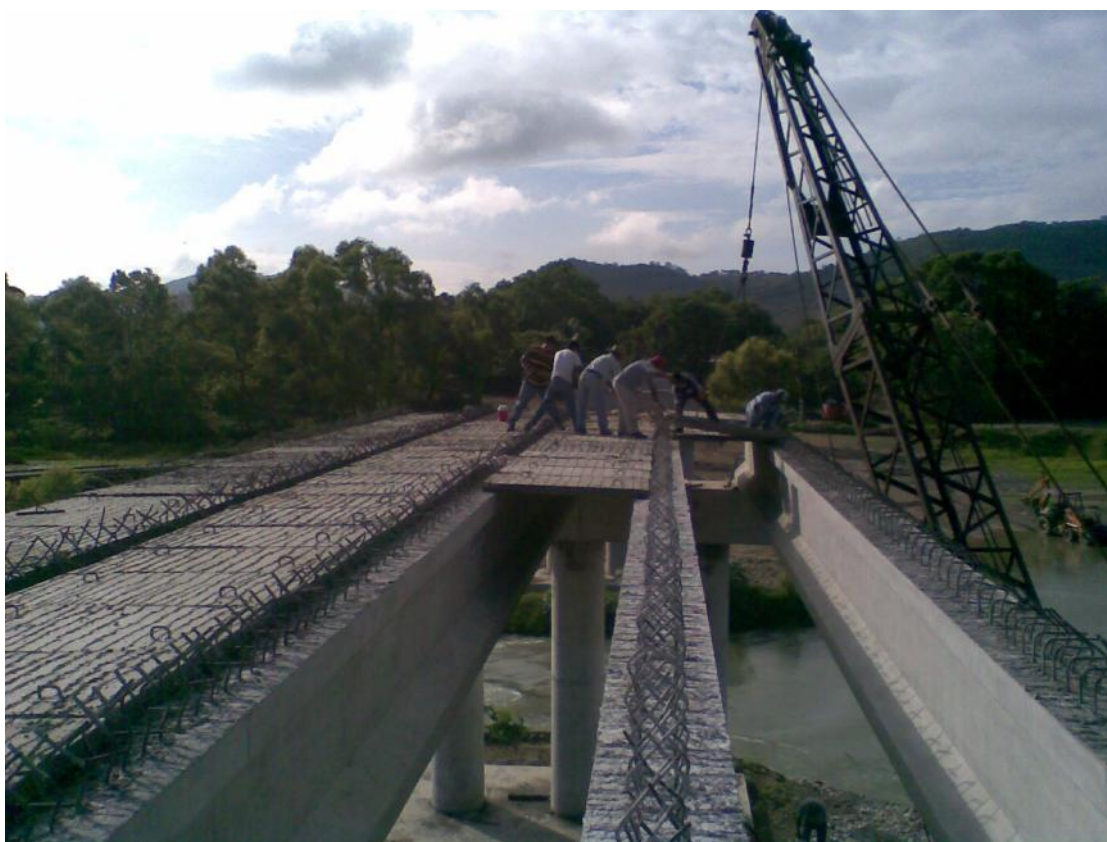
Foto No. 107 Aquí se observa la colocación de prelosas encima de las traves, se puede ver que se debe de enderezar un poco las varillas de las traves para poder colocarlas.
