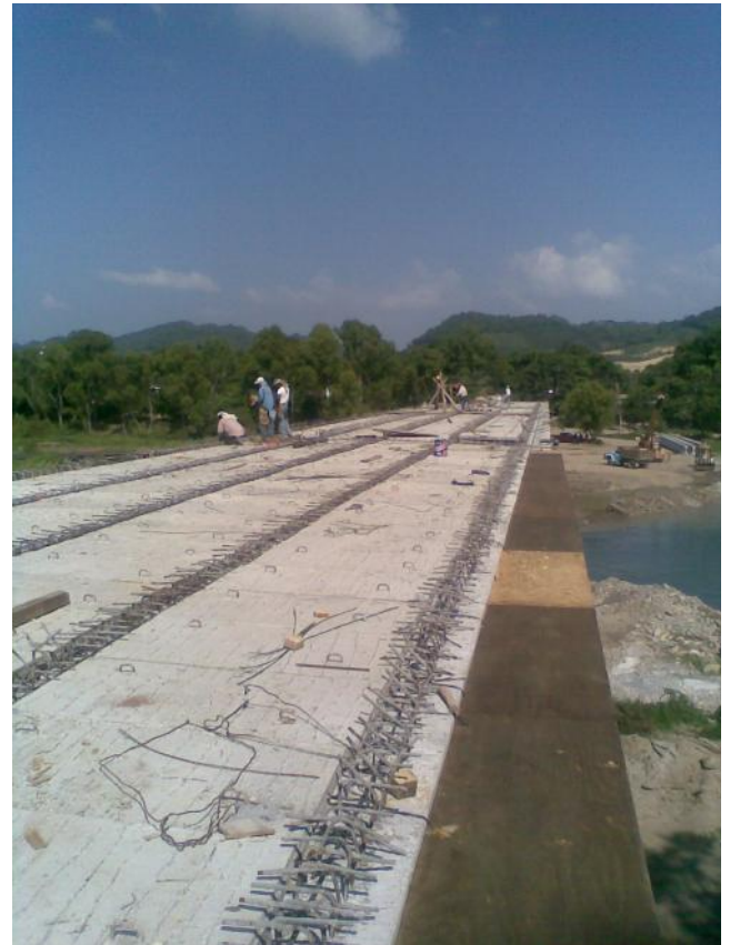
Foto No. 115 y 116 Cimbrado de volados de losa sujetos a trabe.
