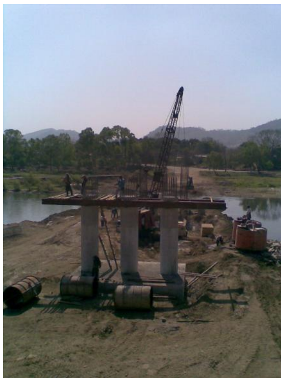
Foto No. 63 y 64 En las siguientes fotos se observa el cimbrado de obra falsa en cuerpos de pilas para los cabezales, para poder cimbrar el fondo del cabezal.
