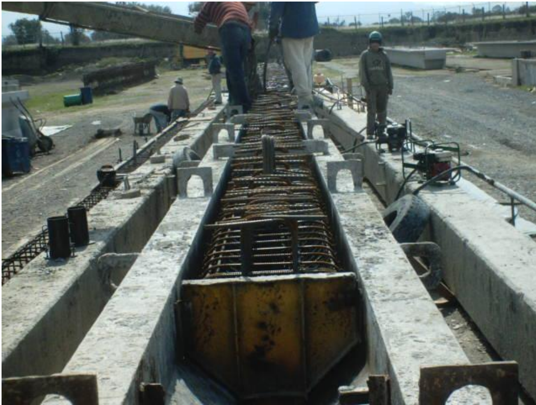
Foto No. 79 Aquí se muestra el cimbrado, centrado del armado y el colado de una trabe, y como se puede ver se tiene mínimo 2 vibradores para el acomodo de la trabe.
