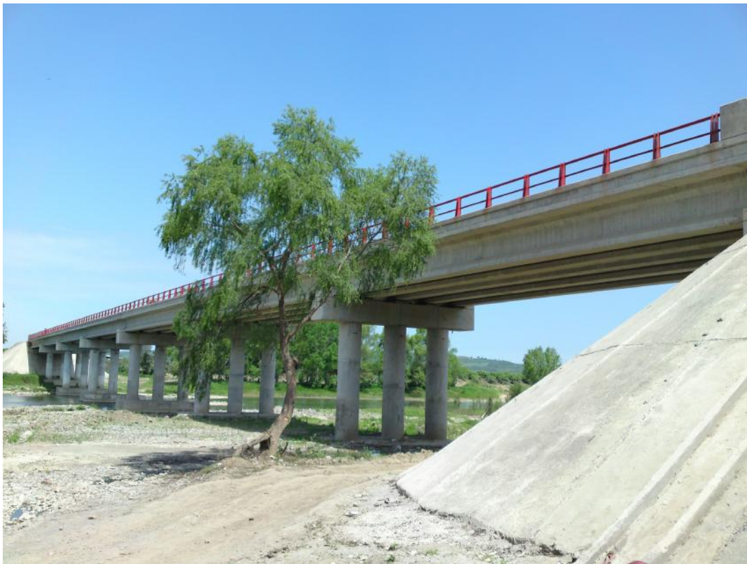
Foto No. 164 Panorámica de Puente Terminado.
