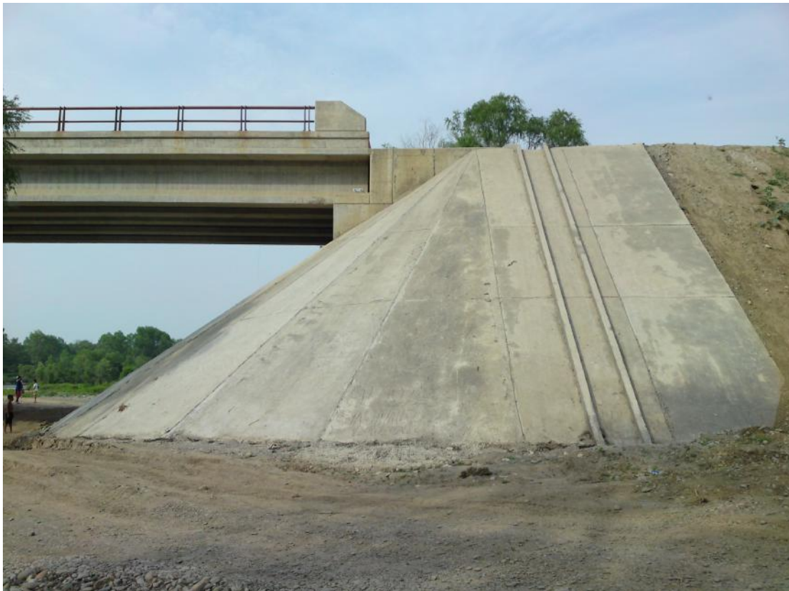
Foto No. 193 Se muestra terminado cono de derrame aguas arriba apoyo 1.
