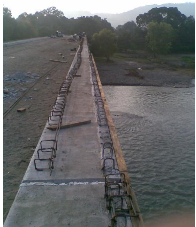
Foto No. 143 y 144 Banquetas coladas desde un extremo al otro
