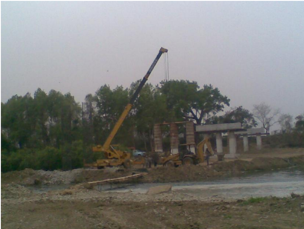
Foto No. 56 Se observa el cimbrado de la parte superior de las columnas de pila intermedia.
