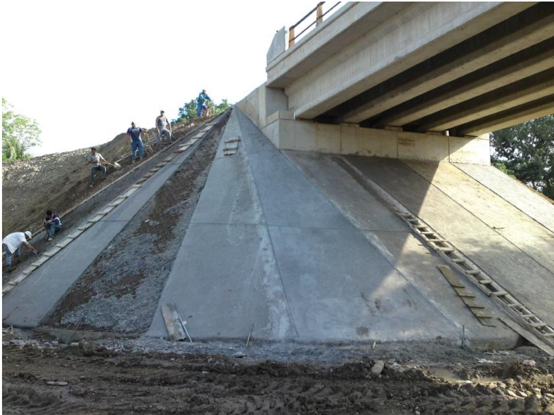
Foto No. 190 Colando una losa de cono de derrame.
