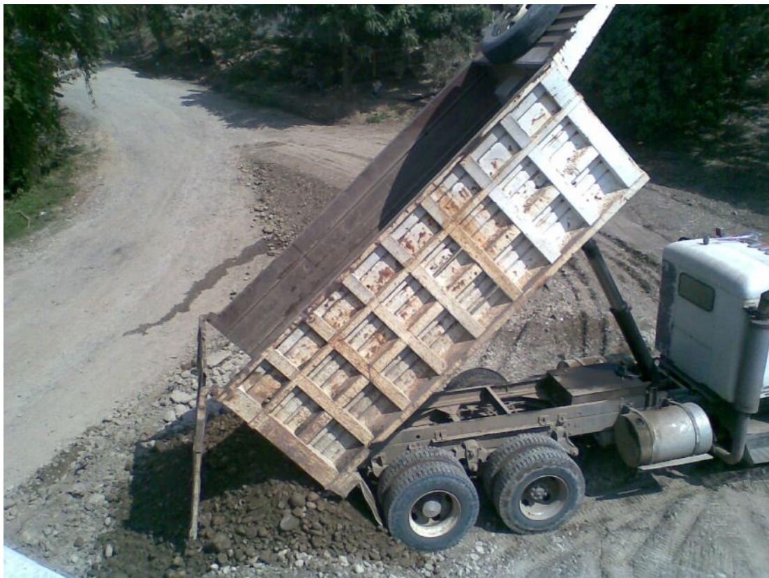
Foto No. 173 Aquí se observa el tiro de un camión de volteo en apoyo 1.
