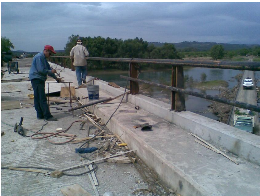
Foto No. 156 Trabajos de colocación de parapeto.
