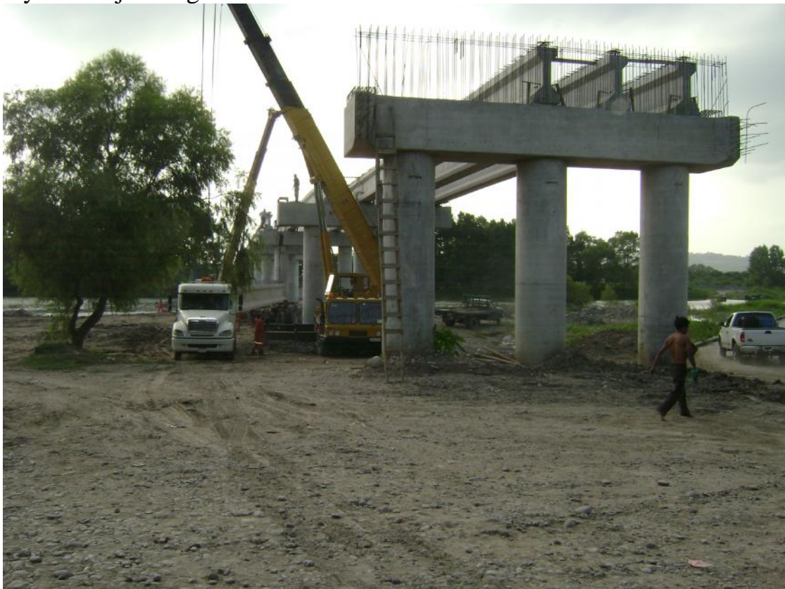
Foto No. 94 Montaje de traves en el claro 2-3
