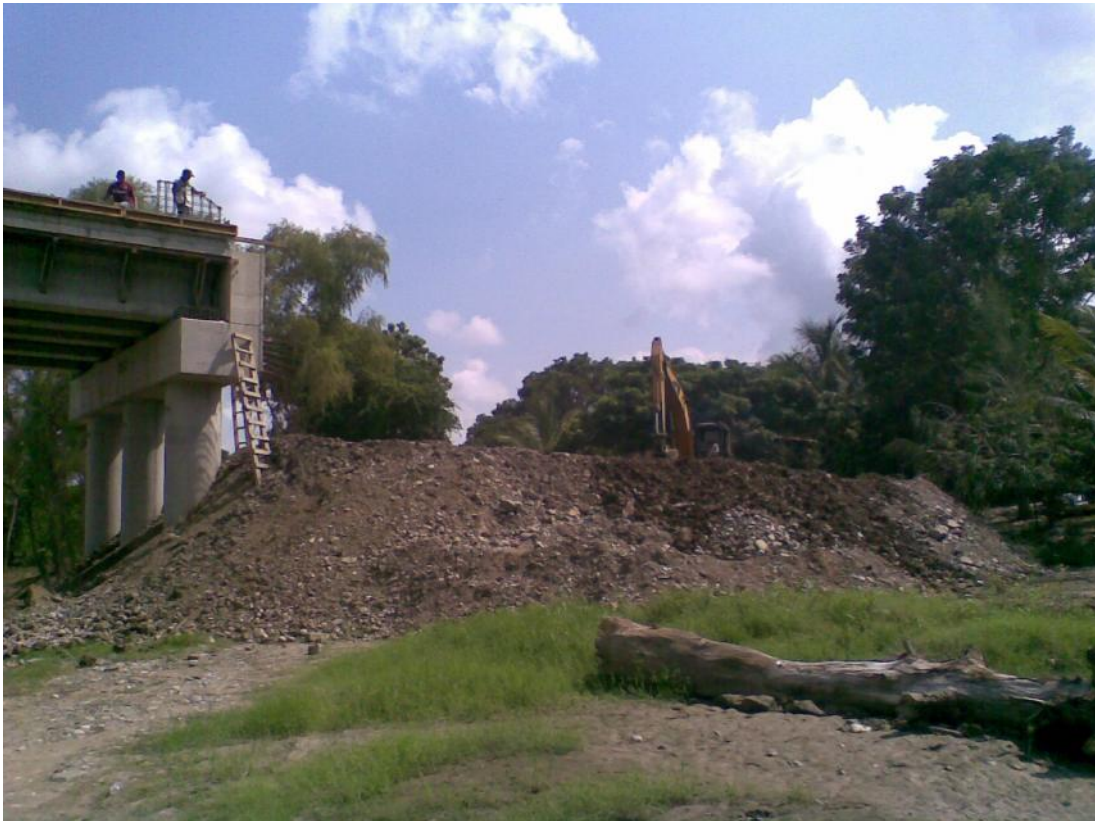
Foto No. 174 Avance de carga de material de un 50% atrás del apoyo 1.
