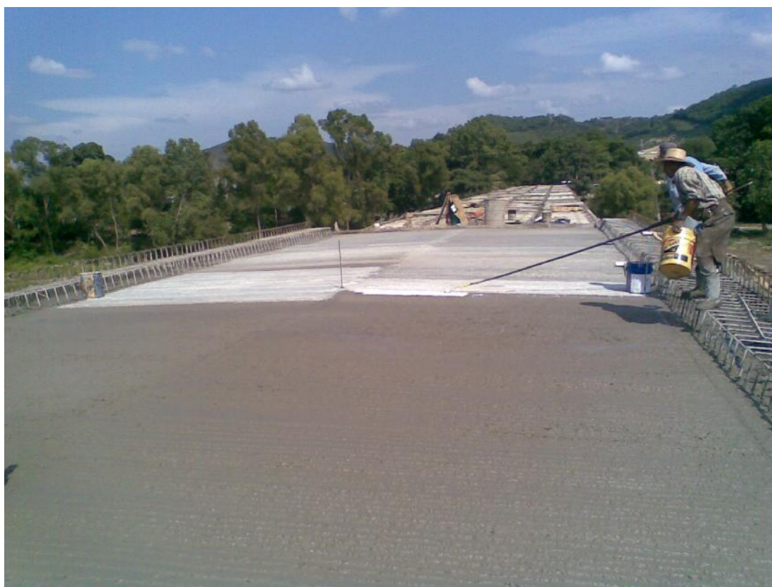
Foto No. 128 Aplicando curacreto en losa
