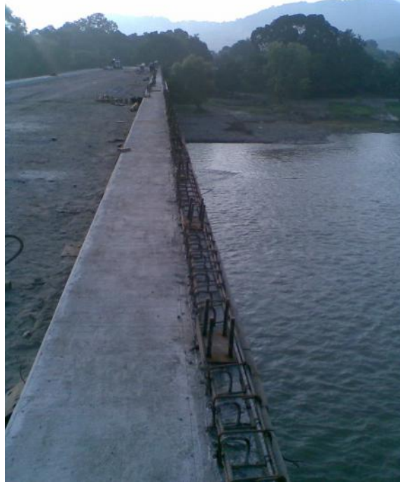
Foto No. 150 y 151 Punteando los tornillos y las pilastras colocadas en guarnición.
