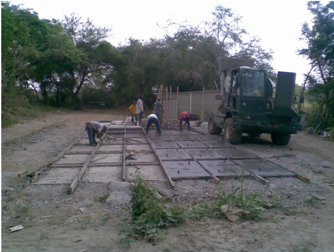
Foto No. 103 Colando prelasas con la autohormigonera.
