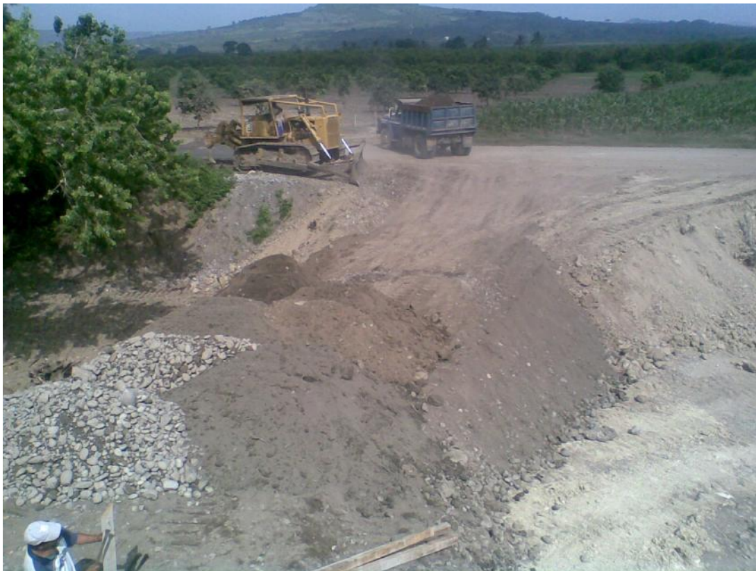
Foto No. 165 Inicio de formación de terraplén atrás del caballete 8.
