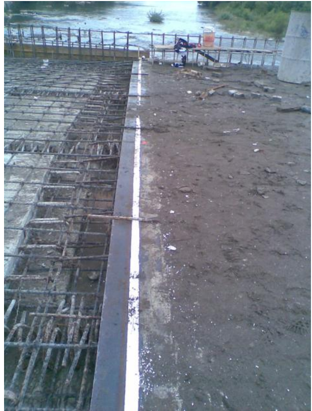
Foto No. 123 Acero estructural de la junta de dilatación y se observa ya colocada con la junta de unicel.
