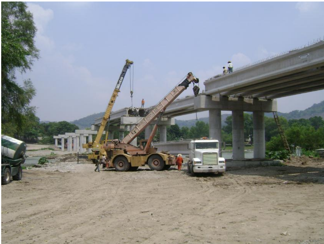
Foto No. 91 Aquí se observa cómo se acomodan las grúas para hacer el izaje de las traves.
