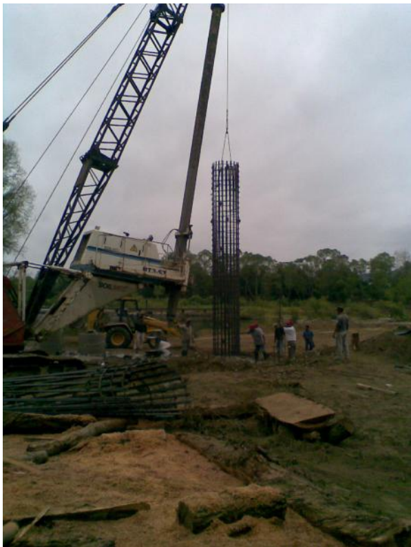
Foto No. 23 Reforzando armado para poder ser izado por la maquina.
