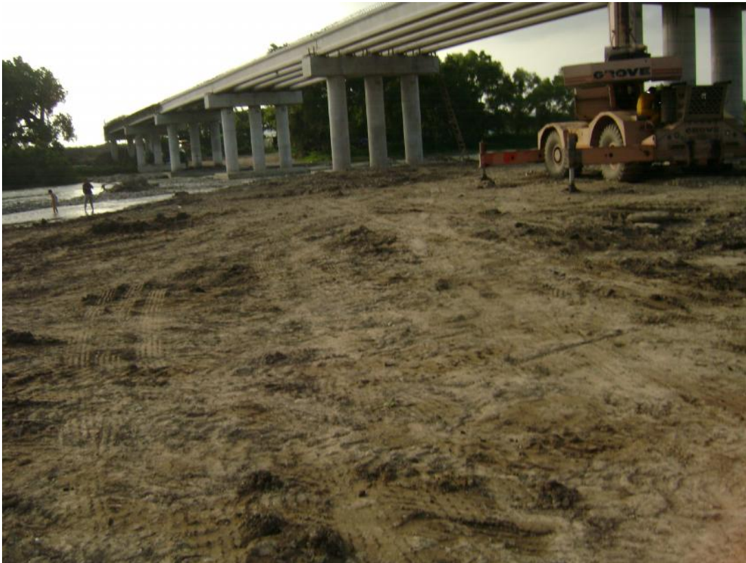
Foto No. 95 Se observa que ya se colocaron las traves en su totalidad.
