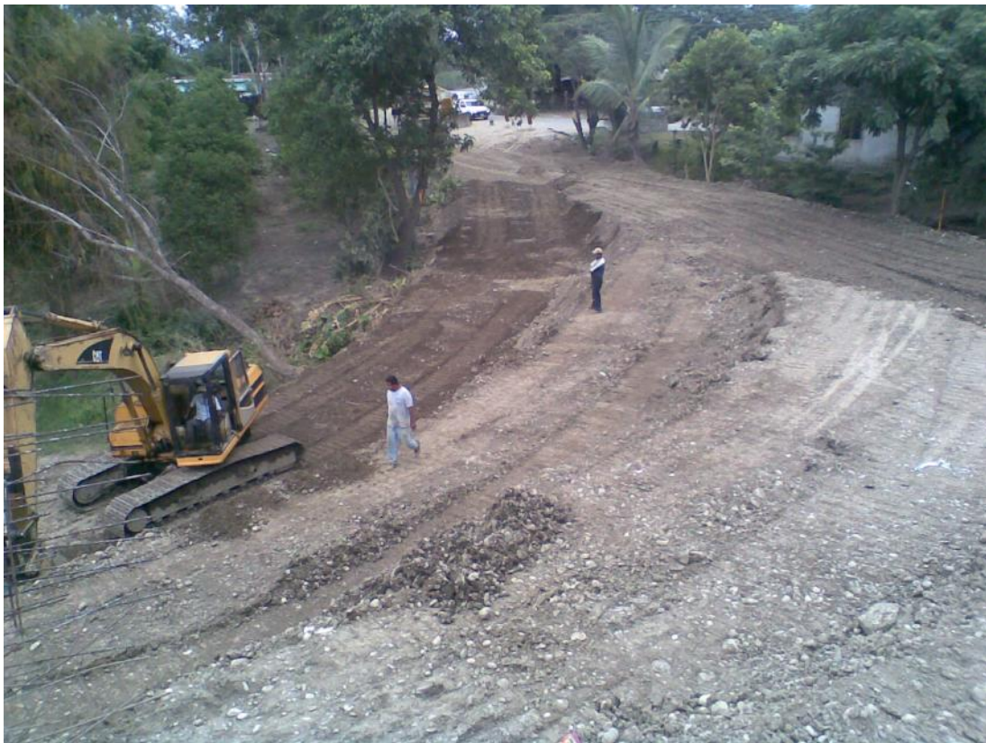
Foto No. 179 Se realiza un escalón en terraplén ya liberado el terreno afectado.
