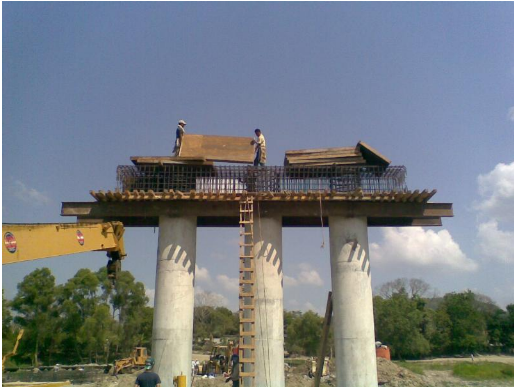
Foto No. 67 Cabezal armado en su totalidad y se procede a cimbrar este
