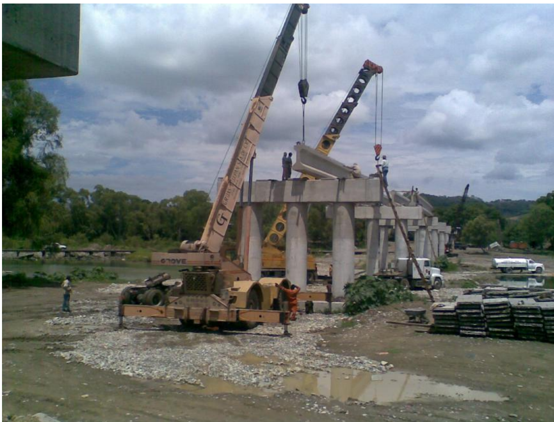
Foto No. 90 Colocación de una trabe, con una grúa de menor capacidad atrás de la pila.
