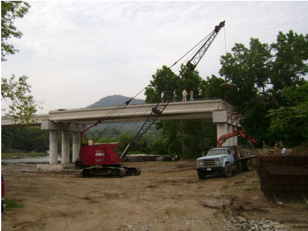
Foto No. 106 Se va montando de una en una sobre las traves.
