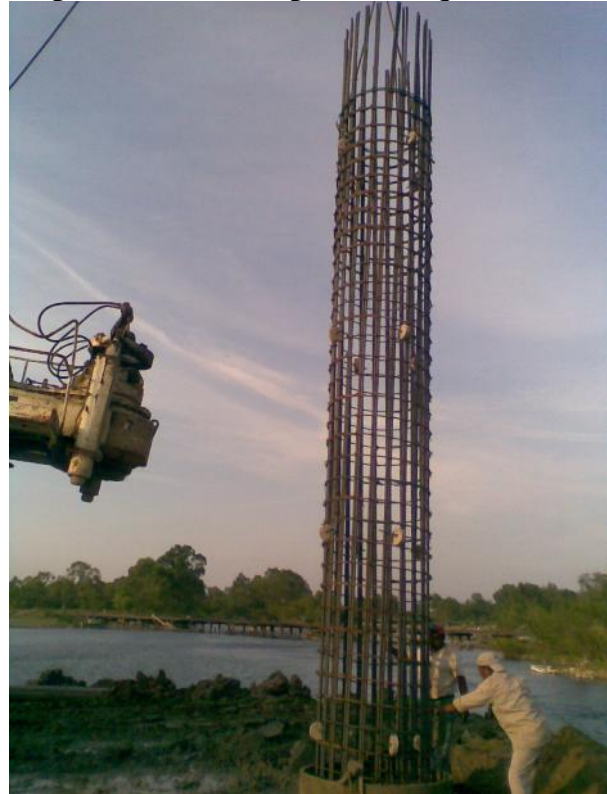
Foto No. 23 Reforzando armado para poder ser izado por la maquina.
