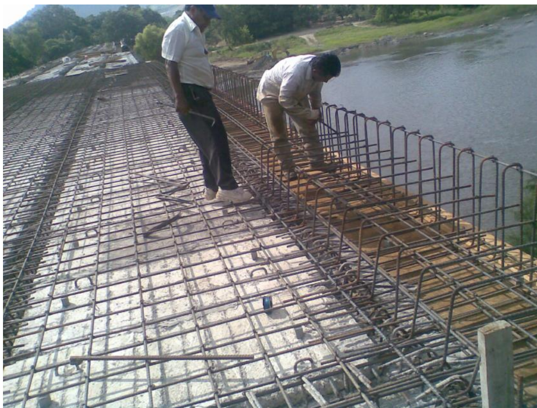
Foto No. 137 Se muestra el armado de banquetas
