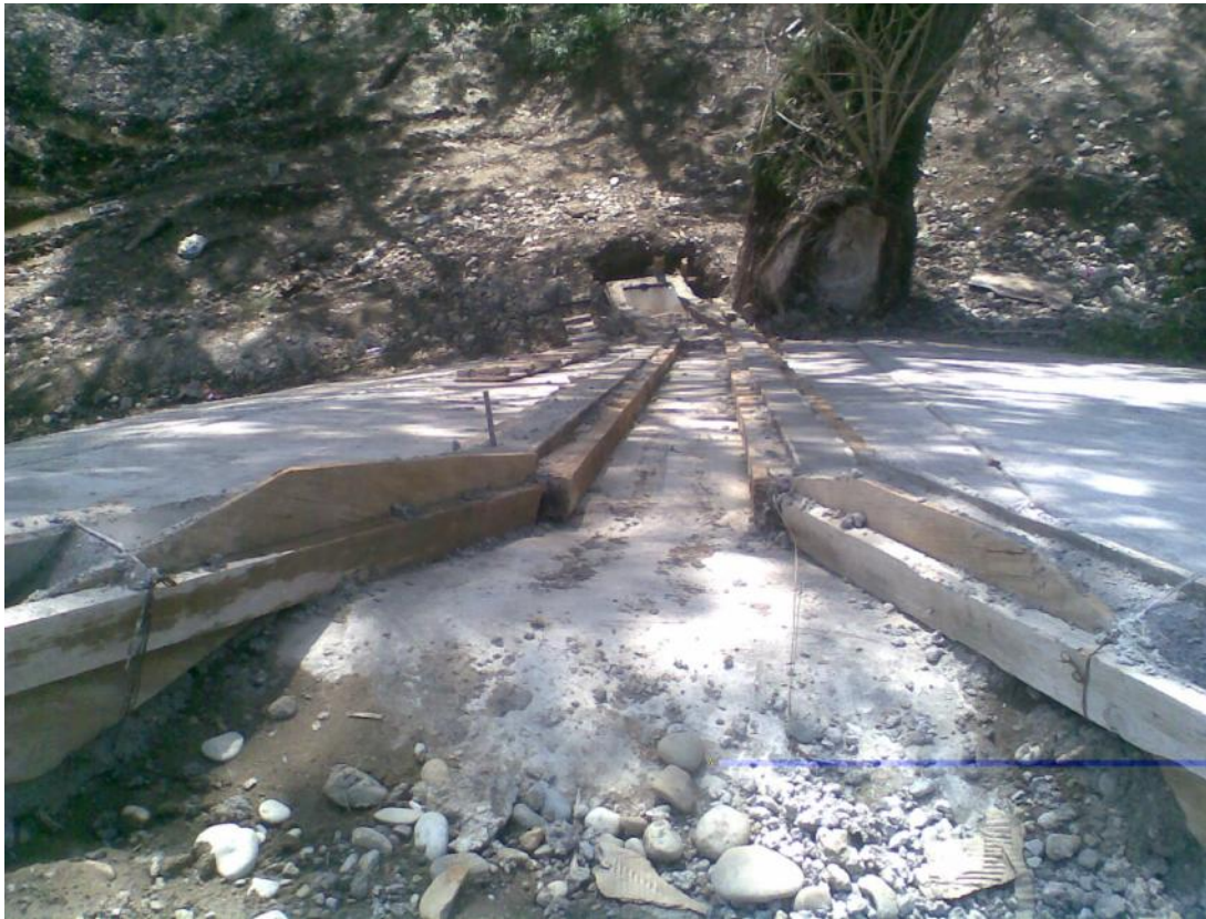
Foto No. 195 Se muestra ya colado los muretes del lavadero.
