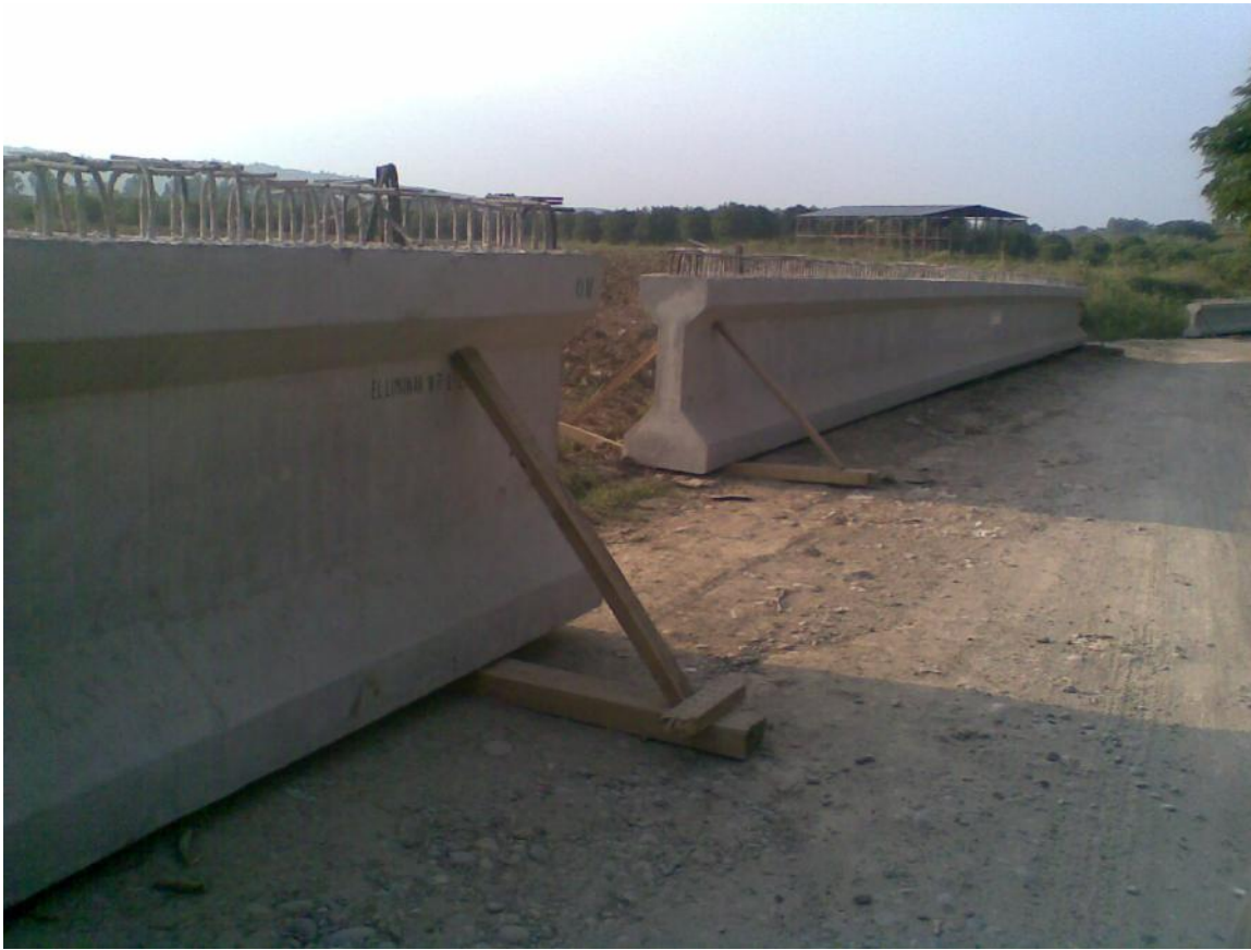
Foto No. 83 Por el poco espacio se decidió colocar las traveses a lo largo del camino.
