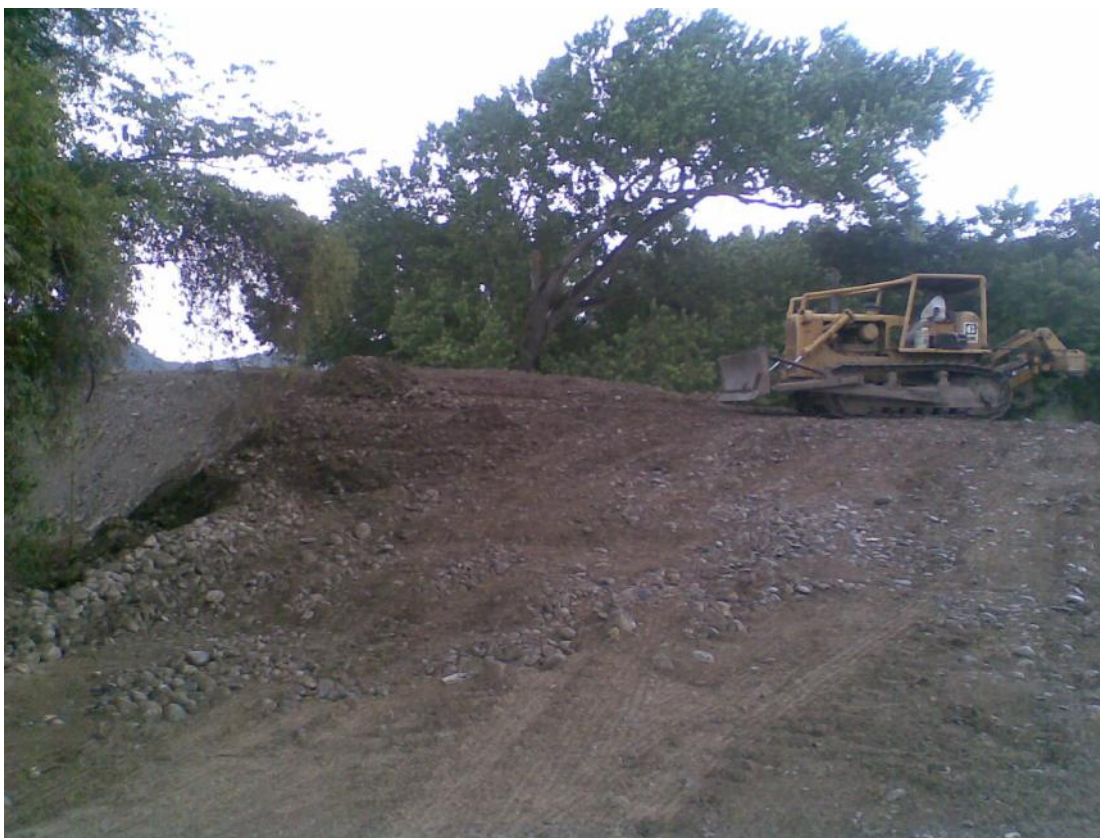
Foto No. 169 El tractor bandeando el terraplén atrás del caballete 8.
