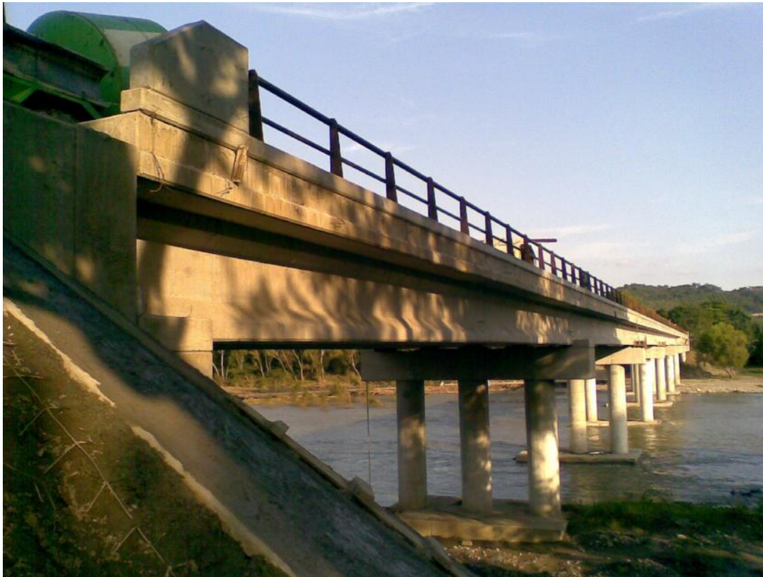
Foto No. 155 Vista de parapeto punteado y se va completando la pareja de pilastras y la soldadura.
