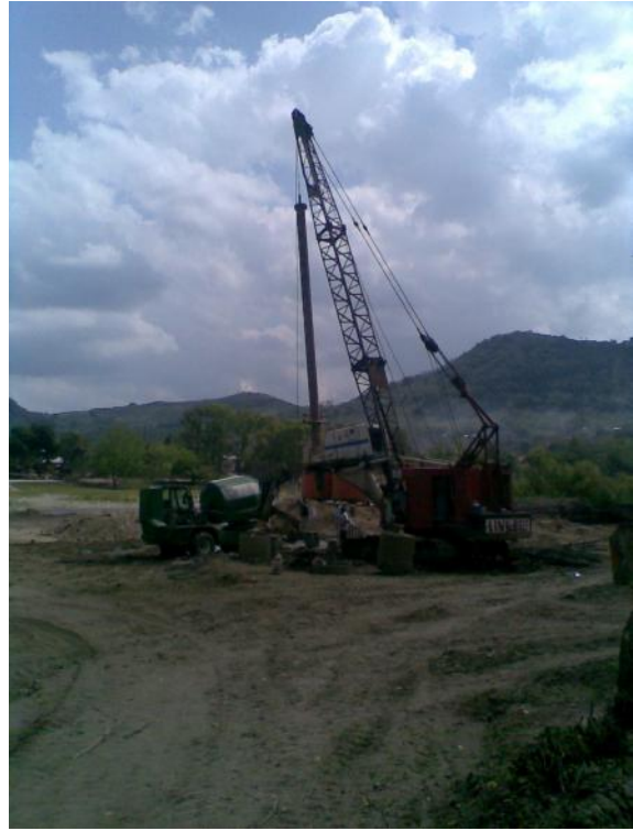
Foto No. 25 Inmediatamente de haber colocado el armado en pilote se coloca el concreto con resistencia de acuerdo a proyecto, esto con la finalidad de que no se presente caídos.
