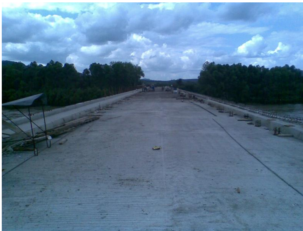
Foto No. 132 Se observa el terminado de losas.
