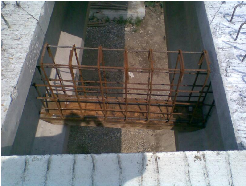
Foto No. 111 Armado de un diafragma, así como el escarificado en traves.
