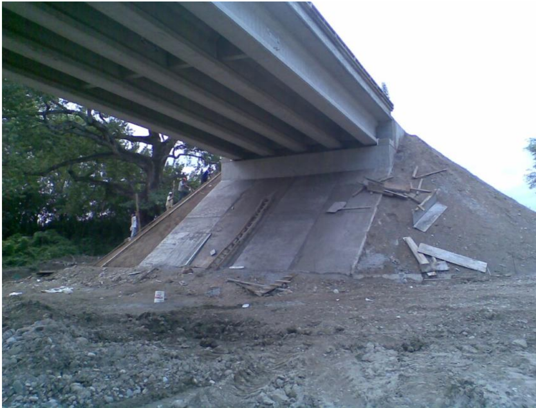
Foto No. 184 Losas de cono de derrame debajo del puente en apoyo 8
