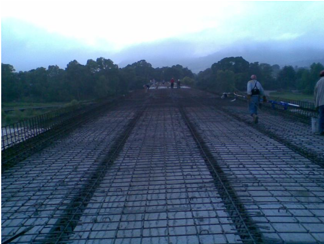
Foto No. 121 Ya se tiene el armado en su totalidad y se están armando las siguientes trabes.
