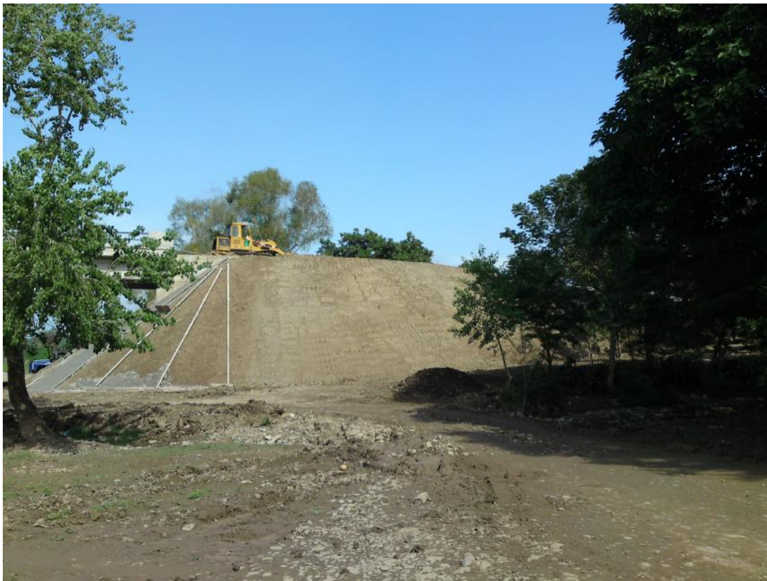
Foto No. 180 Los terraplenes al final se perfilan y compactan de acuerdo al talud, la compactación por bandeado es tan eficiente como utilizar el tractor con pata de cabra, ya que estos cuentan con la garra muy larga y las bandas son angostas y el peso del tractor es de 30 ton, y como es bandeado continuo el material se compacta adecuadamente.
