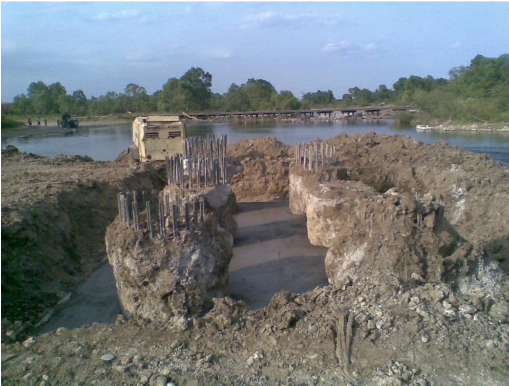
Foto No. 31 Se observa ya colada la plantilla y lo pilotes a descabezar, para nosotros es más importante realizar primeramente la plantilla y si se ve mejor hasta donde se va descabezar.
