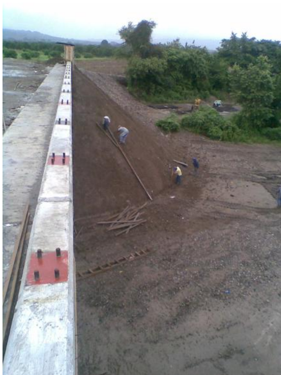
Foto No. 152 y 153 Colocadas las pilastras en guarnición para después colocar las tuercas.
