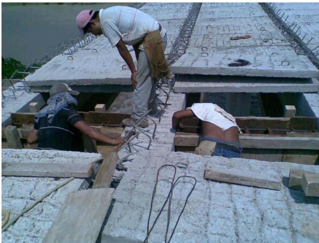
Foto No. 112 Cimbrado de diafragmas intermedios.
