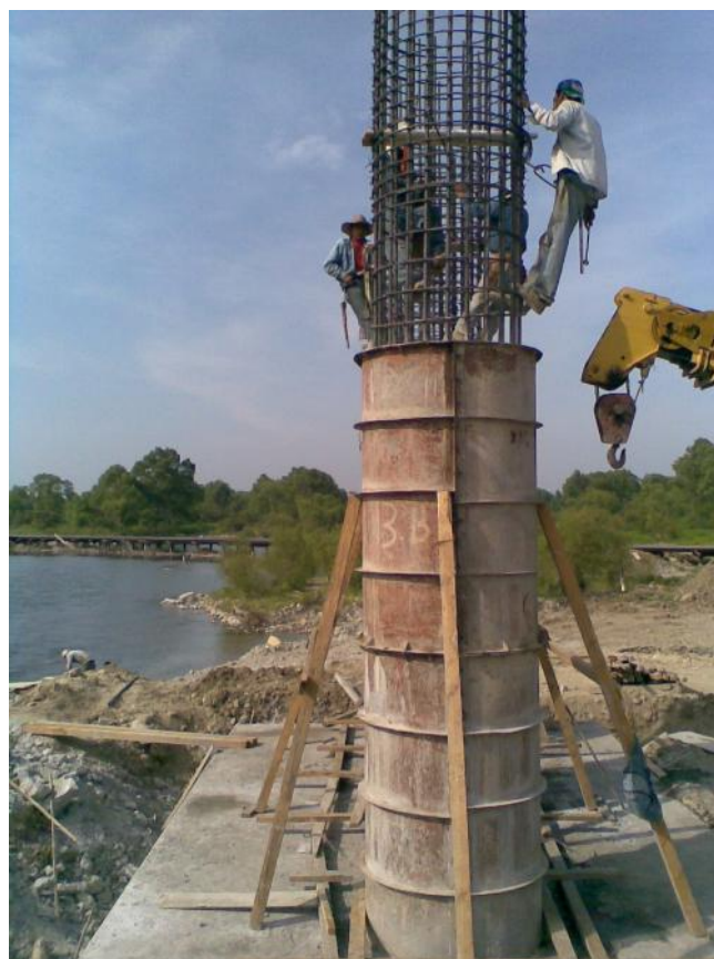
Foto No. 53 Los carpinteros colocan tubos de PVC para colocar la obra falsa para cabezales.
