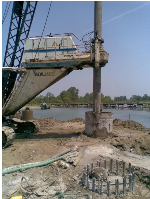
Foto No. 19 Se observa la perforación de pilotes sobre península en apoyo intermedio, en la cual se observa que se está colocando ademe metálico, para proteger los derrumbes de boleas.
