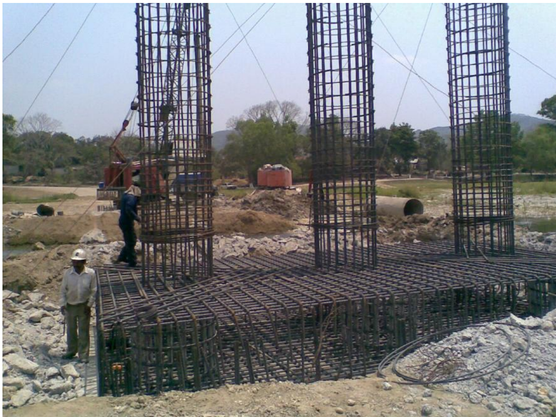
Foto No. 39 Se observa el armado de la zapata en corte transversal.
