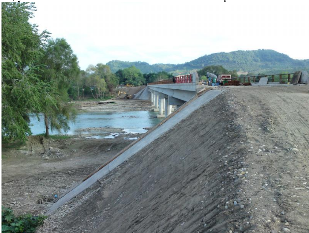
Foto No. 180 Los terraplenes al final se perfilan y compactan de acuerdo al talud, la compactación por bandeado es tan eficiente como utilizar el tractor con pata de cabra, ya que estos cuentan con la garra muy larga y las bandas son angostas y el peso del tractor es de 30 ton, y como es bandeado continuo el material se compacta adecuadamente.
