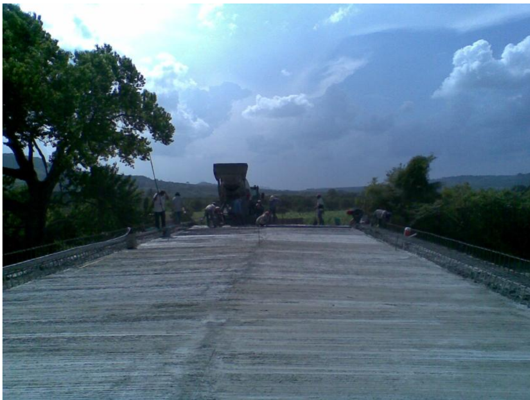
Foto No. 127 Aquí se observa casi por terminar de vaciar el concreto en la losa.
