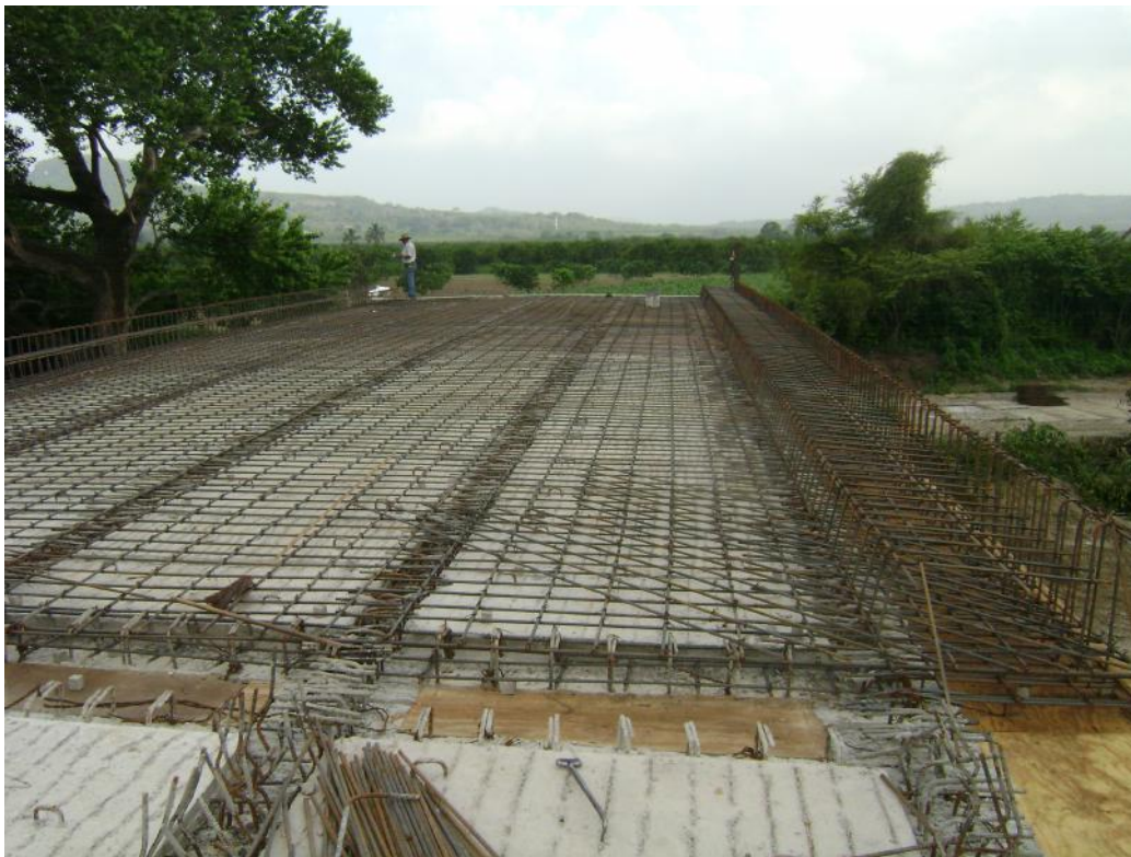
Foto No. 119 Aquí se observa el acero de refuerzo ya terminado, solo esperando cimbrar las fronteras de la losa, y colocación de junta.
