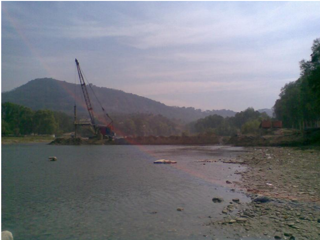
Foto No. 19 Se observa la perforación de pilotes sobre península en apoyo intermedio, en la cual se observa que se está colocando ademe metálico, para proteger los derrumbes de boleas.
