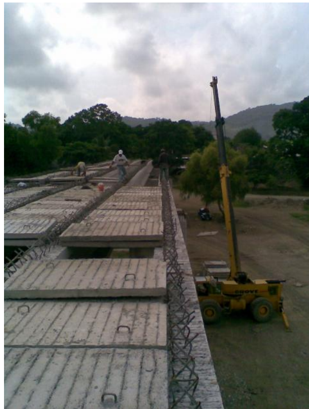
Foto No. 109 y 110 Aquí se observa cómo se colocan prelosas con grúa telescópica, y se observa que se dejan prelosas abiertas para poder colocar los diafragmas intermedios y extremos.
