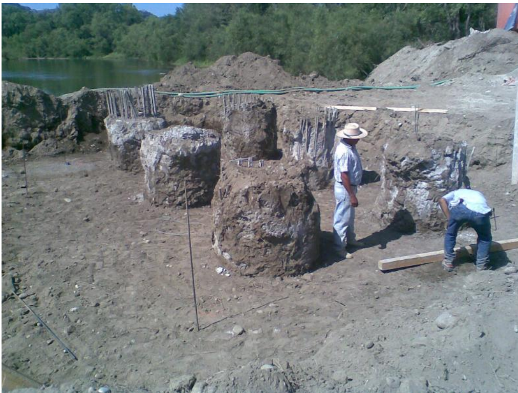
Foto No. 30 Se realizo una excavación previa del apoyo No. 6, y se está afinando y trazando la plantilla, como se observa se dejo aproximadamente 1 metro de descabece en la mayoría de pilotes, esto es muy importante porque por lo regular la parte superior del pilote, el concreto está contaminado y queda expuesto el acero.
