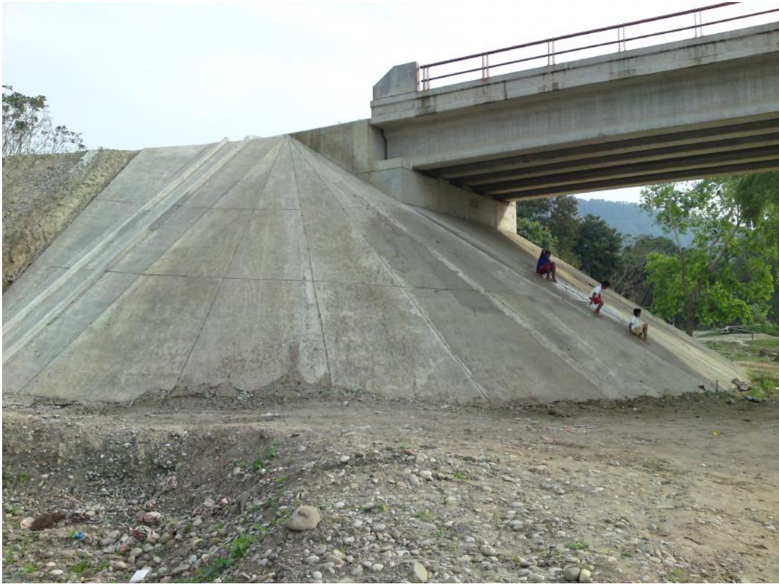
Foto No. 197 Lavadero y cono de derrame del apoyo 1.
