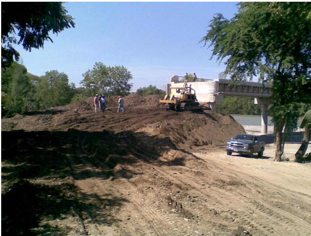
Foto No. 175 Tendido y conformación de material en terraplén con tractor.
