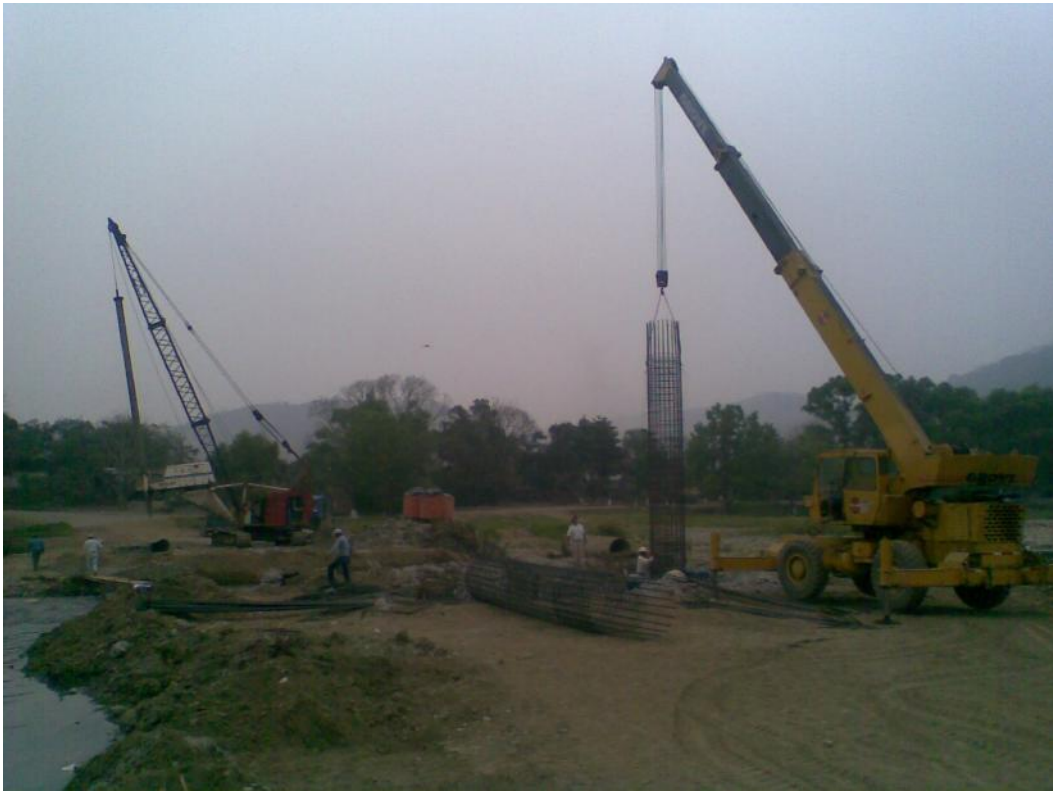
Foto No. 48 Colocación de columnas con grúa telescópica.
