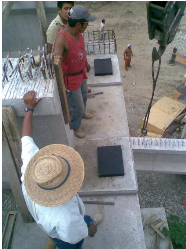
Foto No. 100 Aquí se observa la colocación de neoprenos para recibir las traves es muy importante ver dónde van los apoyos fijos y móviles.
