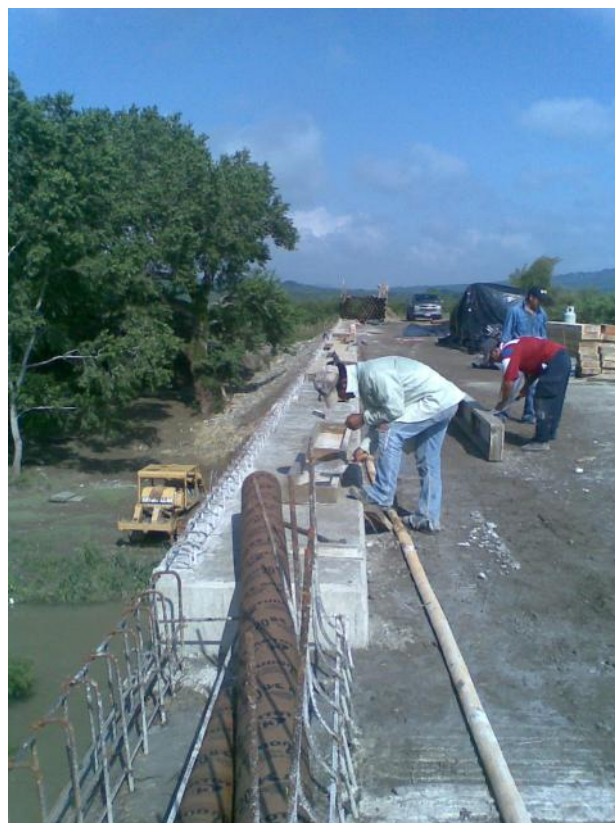
Foto No. 139 y 140 Colocación de tubo de cartón o sonotubo, y en dos líneas
