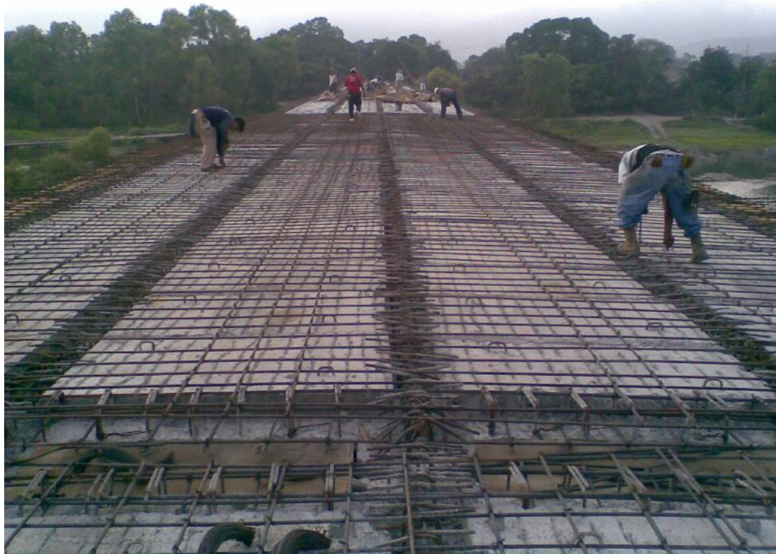
Foto No. 118 Armado y sujeción de la parrilla de acero de refuerzo.
