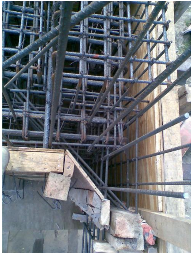
Foto No. 59 y 60 Se observa el armado de un cabezal de un caballete.
