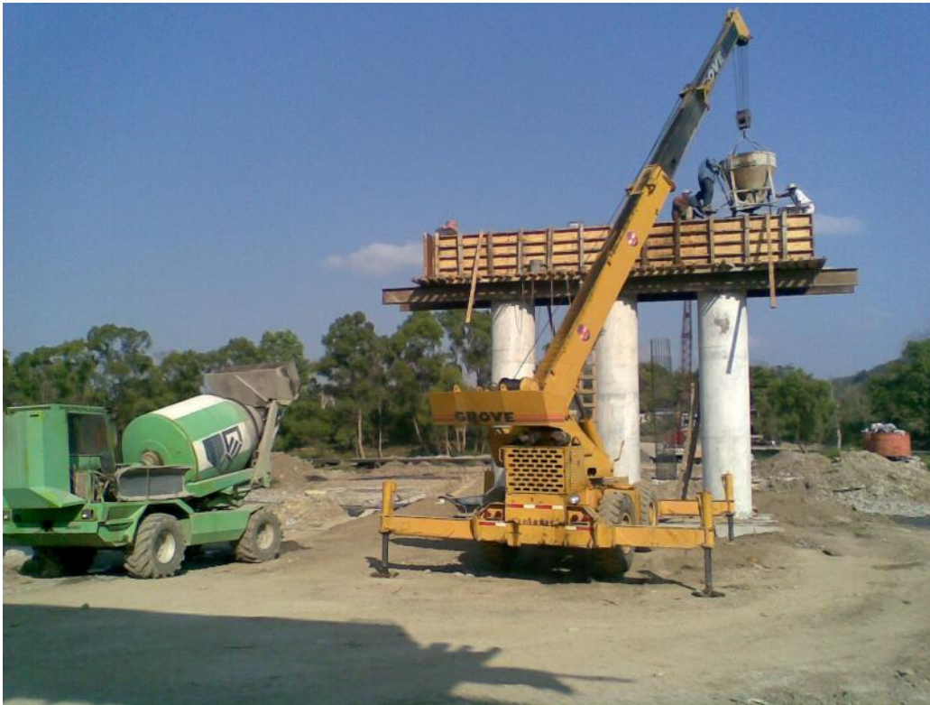
Foto No. 70 Se observa el colado de cabezal con bacha y con concreto elaborado en sitio
