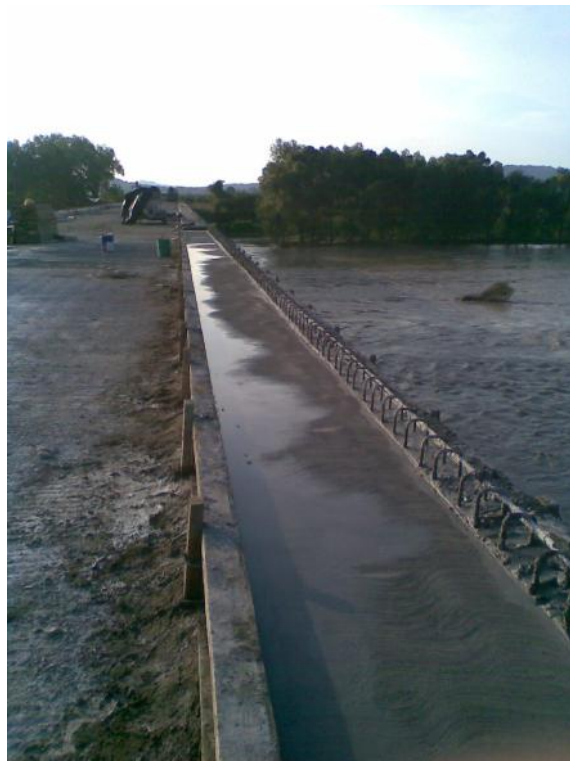
Foto No. 141 y 142 Cimbrada una banqueta y el colado de otra escobillada y con pendiente hacia la calzada.
