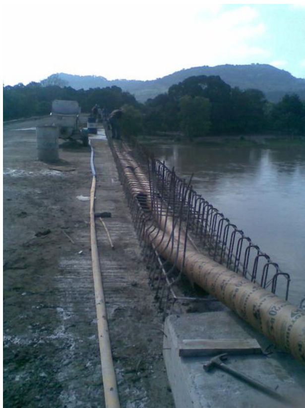
Foto No. 139 y 140 Colocación de tubo de cartón o sonotubo, y en dos líneas
