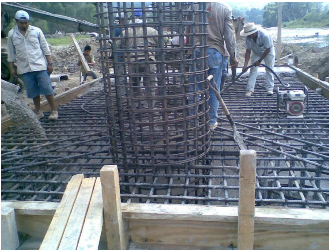
Foto No. 40 Se observa el colado de una zapata de un apoyo intermedio, como se puede ver se está atacando con dos autohormigoneras y se observa también la cimbra de madera.
