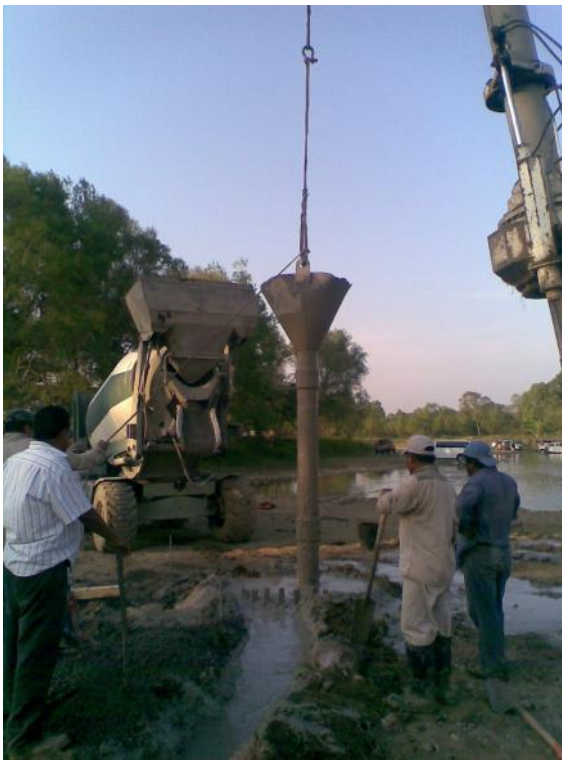
Foto No. 25 Inmediatamente de haber colocado el armado en pilote se coloca el concreto con resistencia de acuerdo a proyecto, esto con la finalidad de que no se presente caídos.
