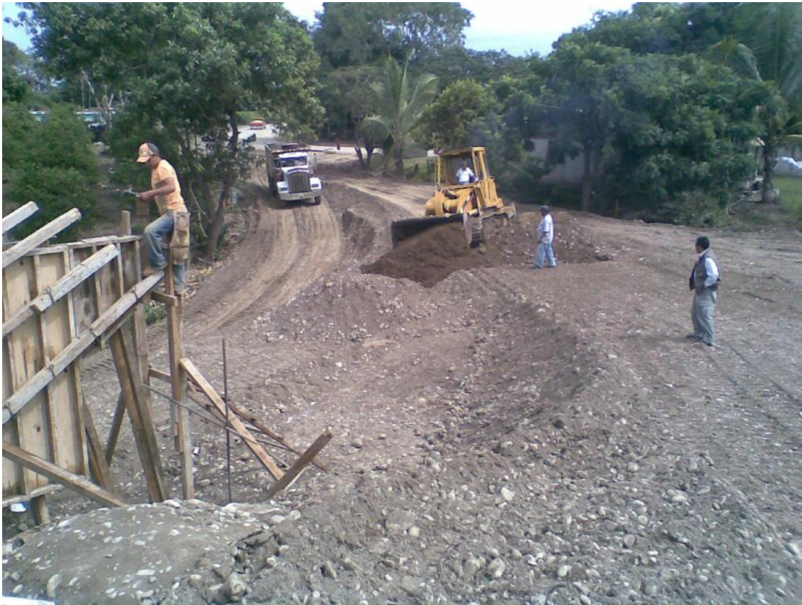
Foto No. 178 Se conforma terraplén con traxcavo
