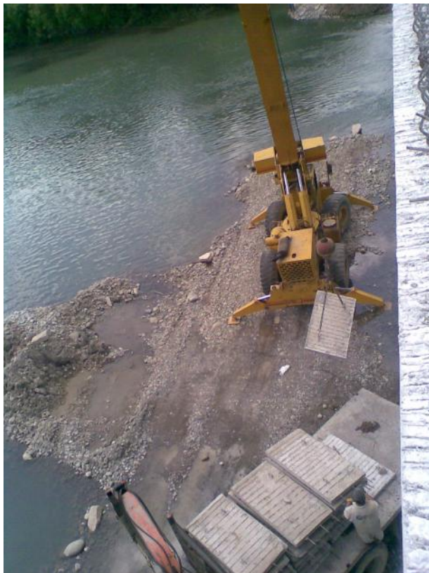
Foto No. 109 y 110 Aquí se observa cómo se colocan prelosas con grúa telescópica, y se observa que se dejan prelosas abiertas para poder colocar los diafragmas intermedios y extremos.
