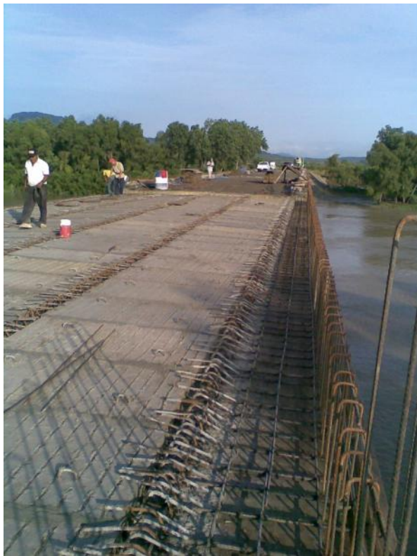
Foto No. 135 y 136 El armado de guarniciones y banquetas, así como el volado de losa
