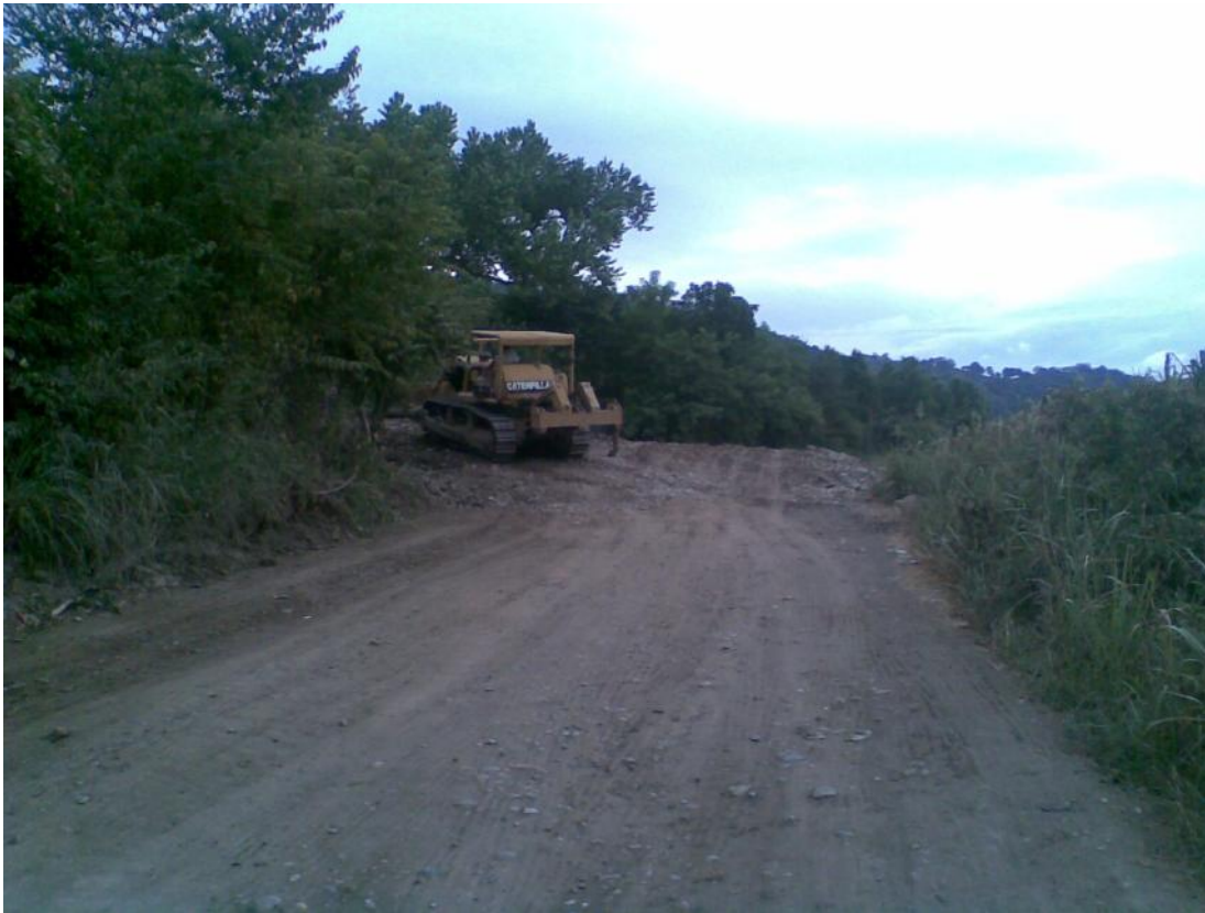
Foto No. 170 Bandeando el tractor el material de terraplén.
