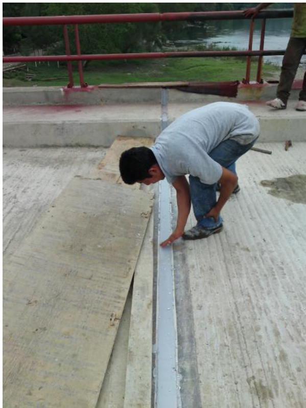
Foto No. 134 Colocando junta de Sikaflex 1-A, como se observa debe de ser hasta la parte de arriba. sobre la banqueta y guarnición
