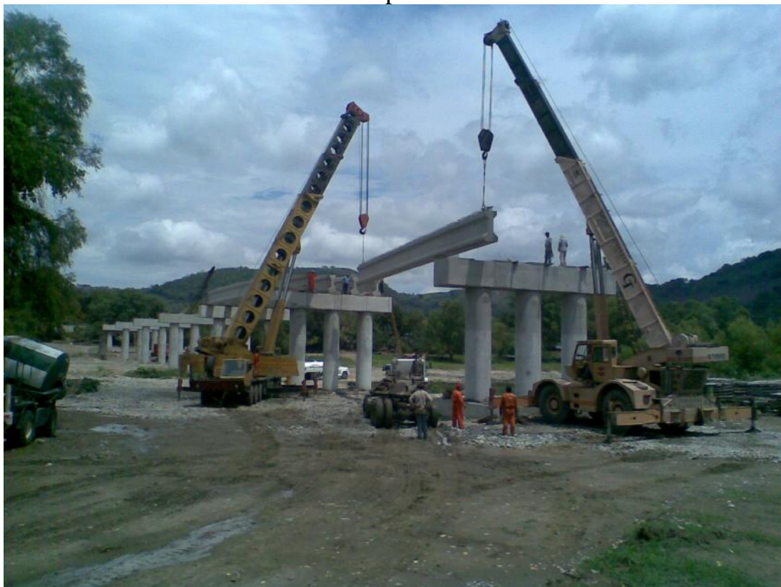
Foto No. 88 Montaje de trabe, las grúas deben de reforzarse con durmientes en los estabilizadores.
