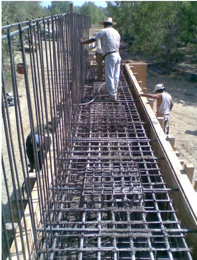
Foto No. 59 y 60 Se observa el armado de un cabezal de un caballete.
