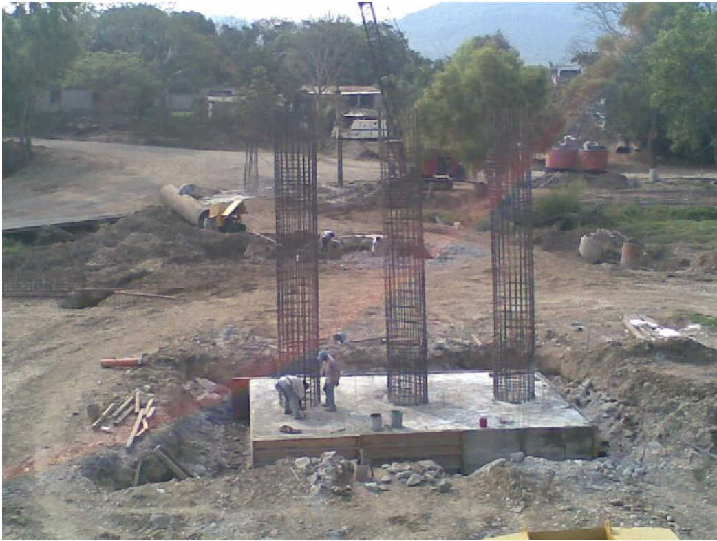
Foto No. 44 Se observa que se está descimbrando la zapata.
