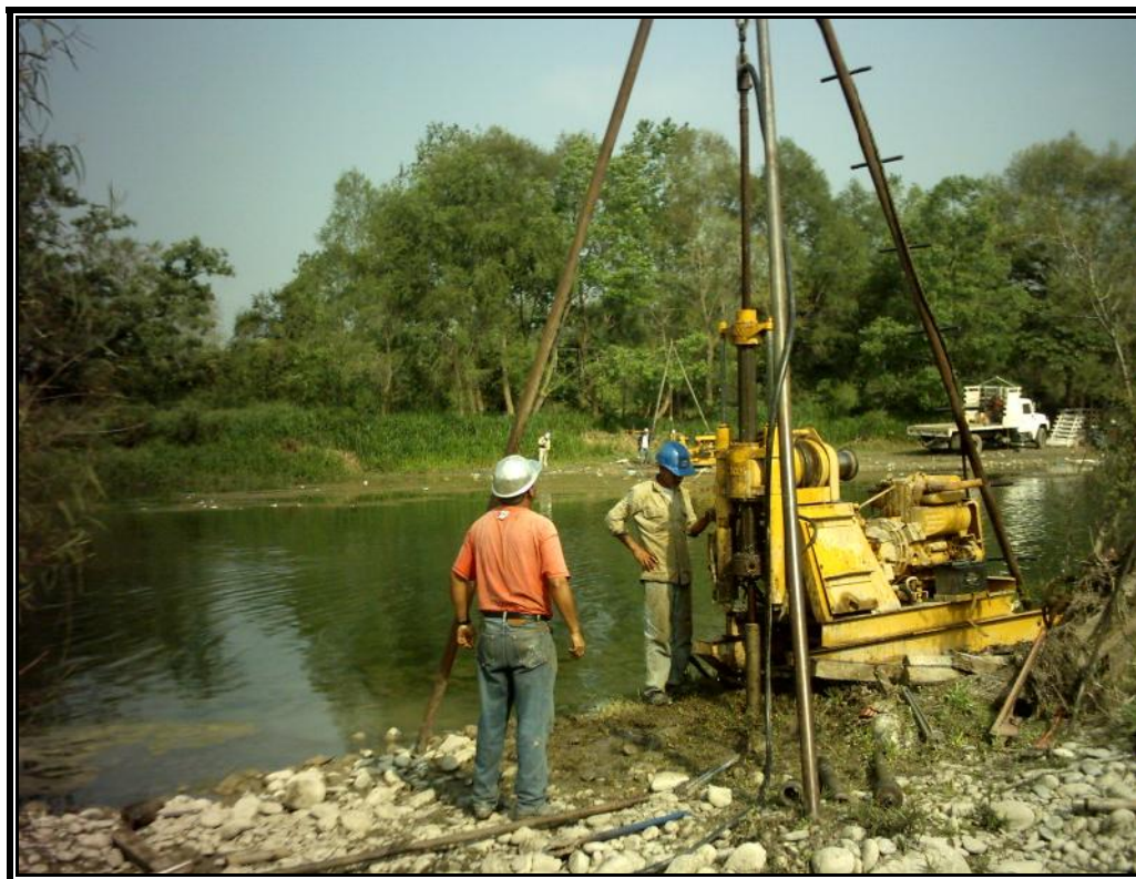
FOTO No. 6 TRABAJOS EN EL SONDEO S-3, EN LA ZONA DEL CAUCE
