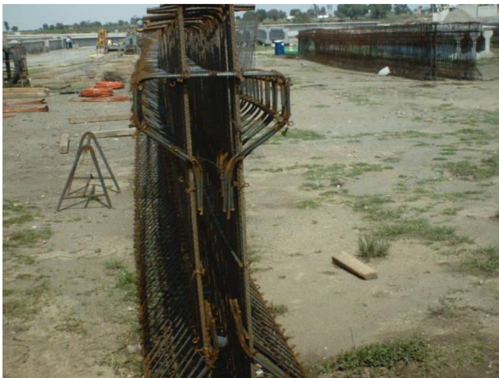
Foto No. 77 Se observa los armados de traves AASHTO IV en planta de fabricación.
