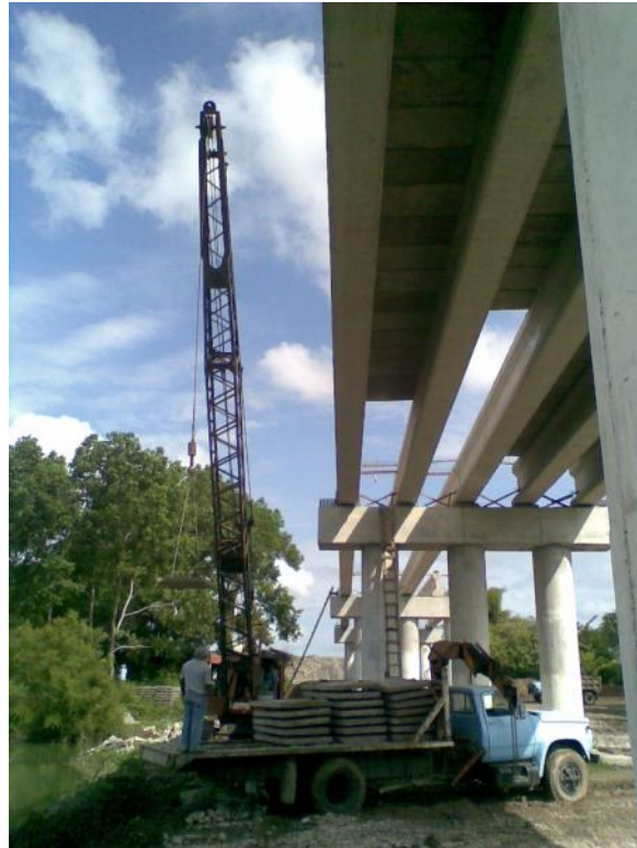
Foto No. 104 y 105 Prelasas Estibadas y con ayuda de draga o grúa se colocan prelasas, acercadas en un camión, para agilizar el montaje de estas.
