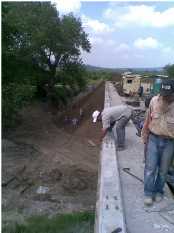
Foto No. 147 y 148 Se observa guarniciones terminadas y se puede observar que cuentan con chaflanes y están bien alineadas.
