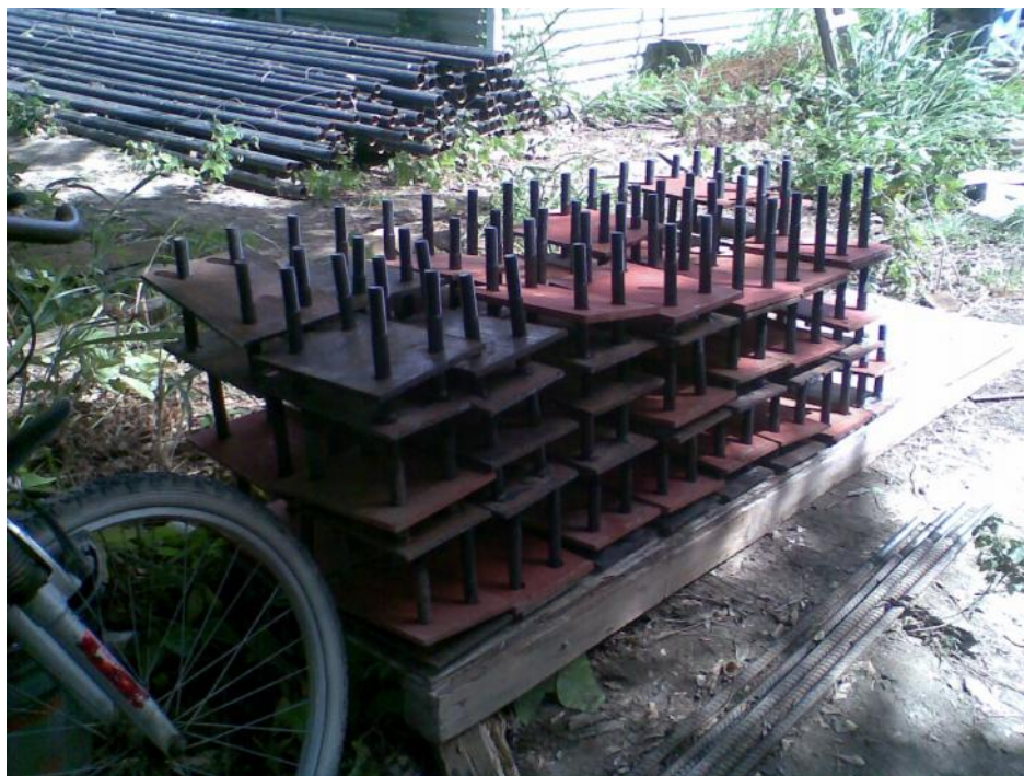
Foto No. 149 Las pilastras con tornillos ya punteados para poder colocarlas en guarnición.
