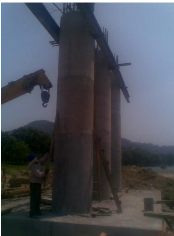
Foto No. 63 y 64 En las siguientes fotos se observa el cimbrado de obra falsa en cuerpos de pilas para los cabezales, para poder cimbrar el fondo del cabezal.
