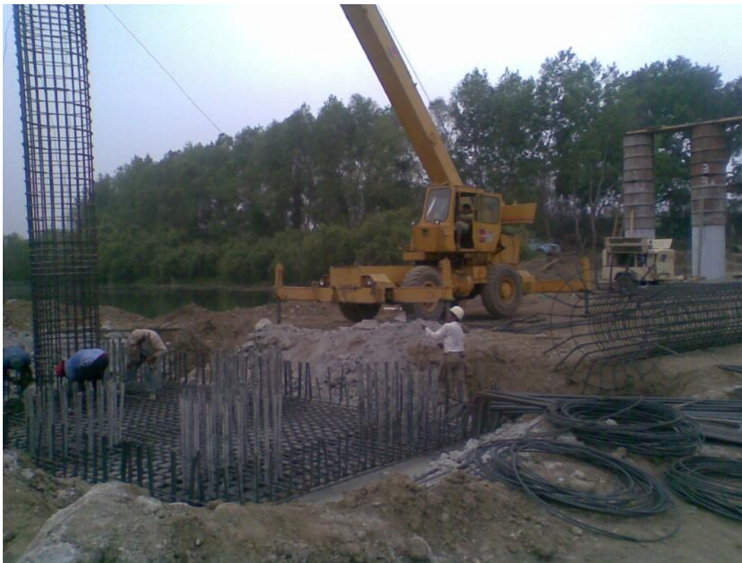
Foto No. 49 Colocación de contravientos para que la columna no se caiga y se mantenga en su posición.
