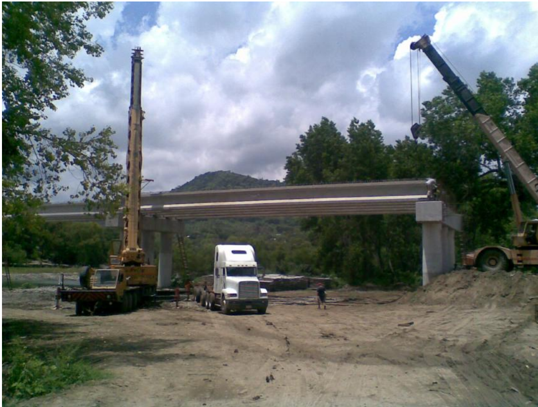
Foto No. 89 Colocando una trabe muy suavemente al centro y eje de apoyos.
