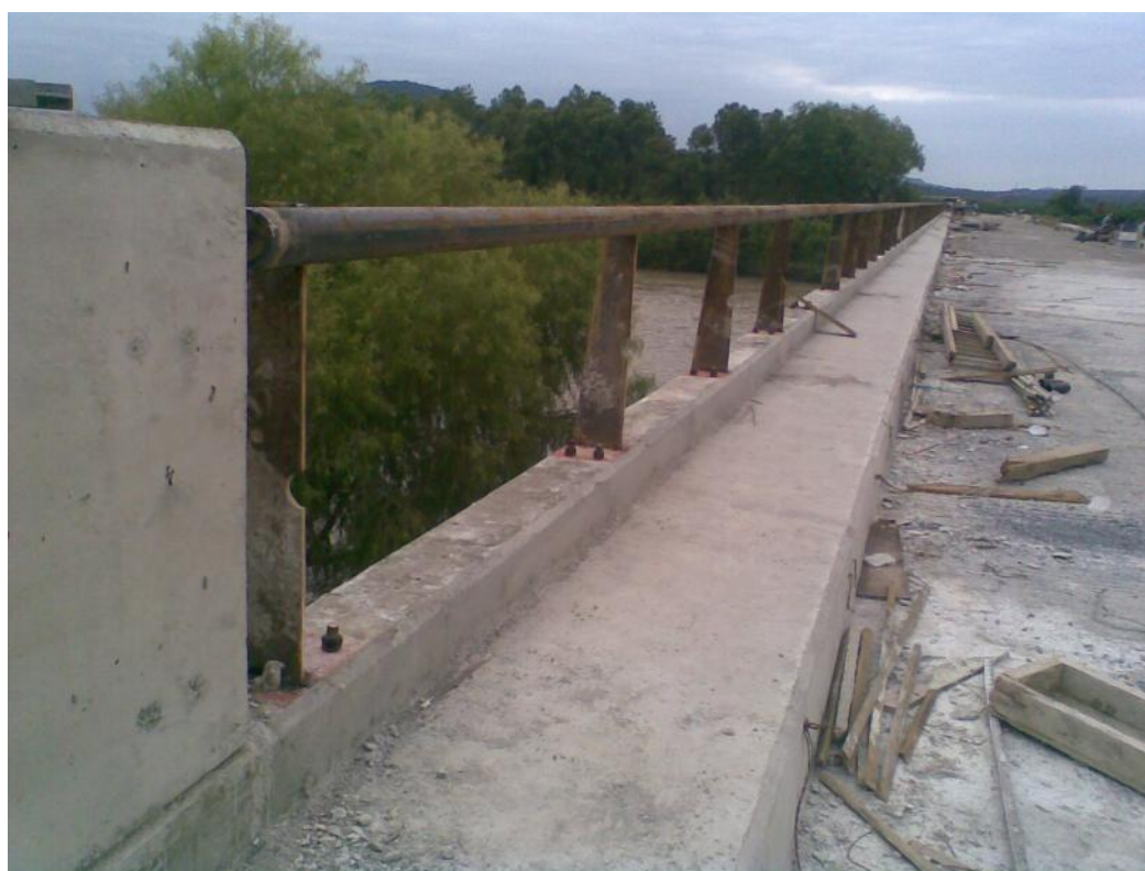
Foto No. 154 Colocación de pilastra de 80 centímetros, primeramente se alinea y se va punteando para rectificar.
