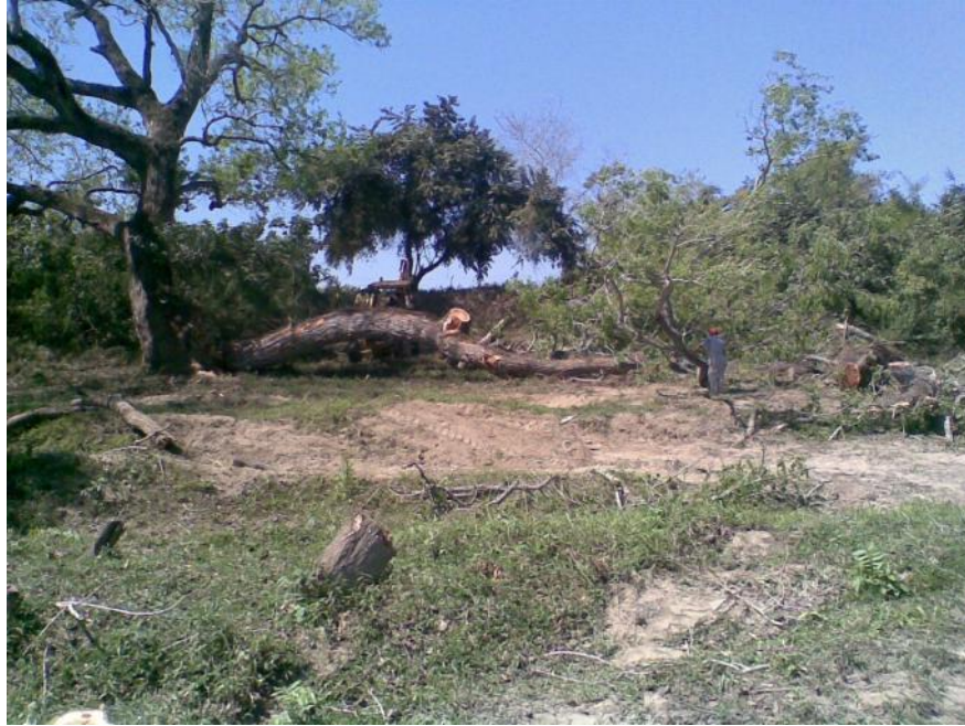
Foto No. 11 Se observa el desmonte en eje del puente a construir
