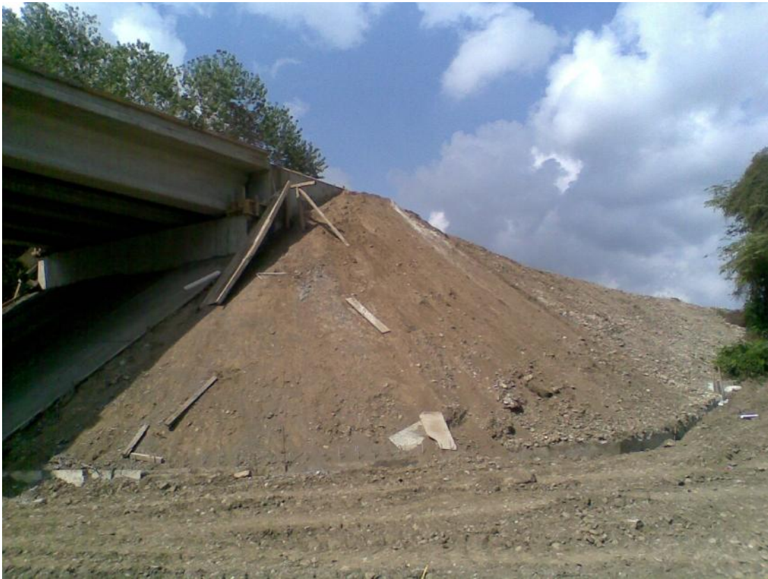
Foto No. 172 El terraplén formado a tras del apoyo 8.
