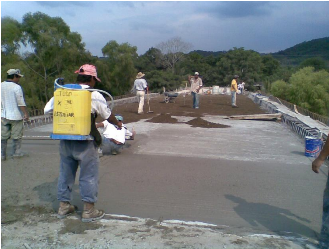
Foto No. 129 Aplicando un poco de agua para que no se reseque o pierda humedad el concreto por el excesivo calor.
