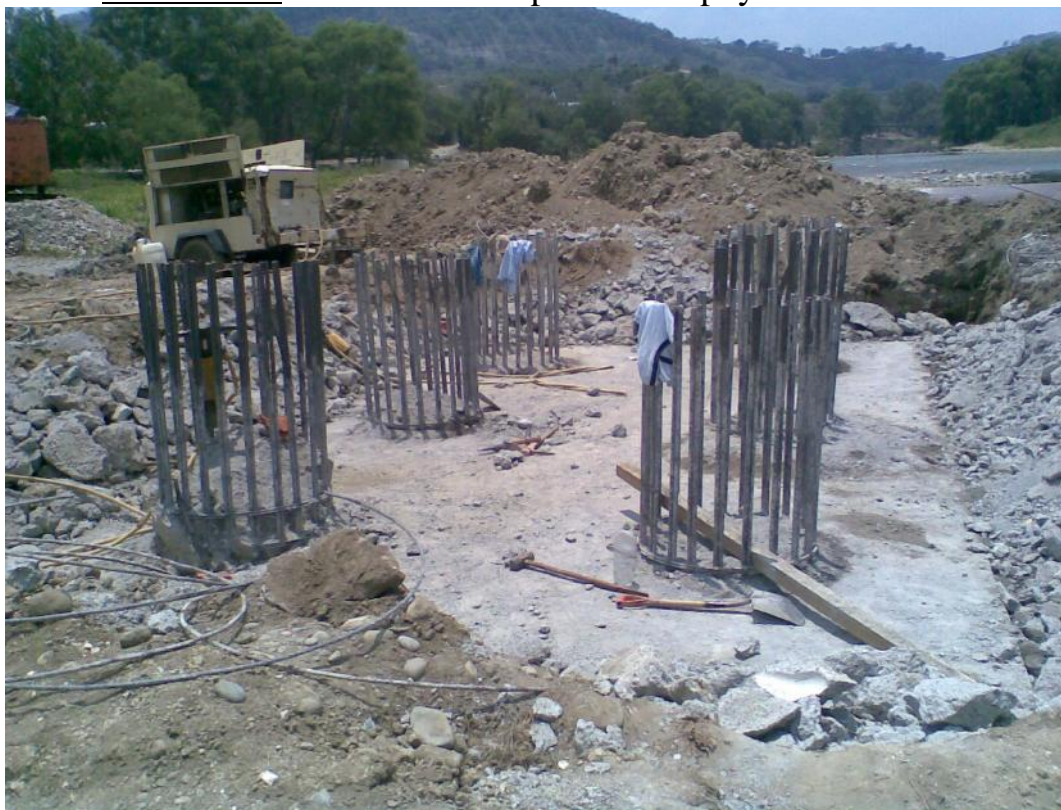
Foto No. 33 Demolición de pilotes de apoyos intermedios
