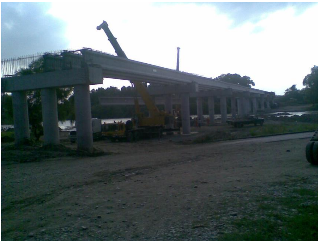
Foto No. 96 Colocando las ultimas traves sin problemas y con el terreno en buenas condiciones para trabajar.
