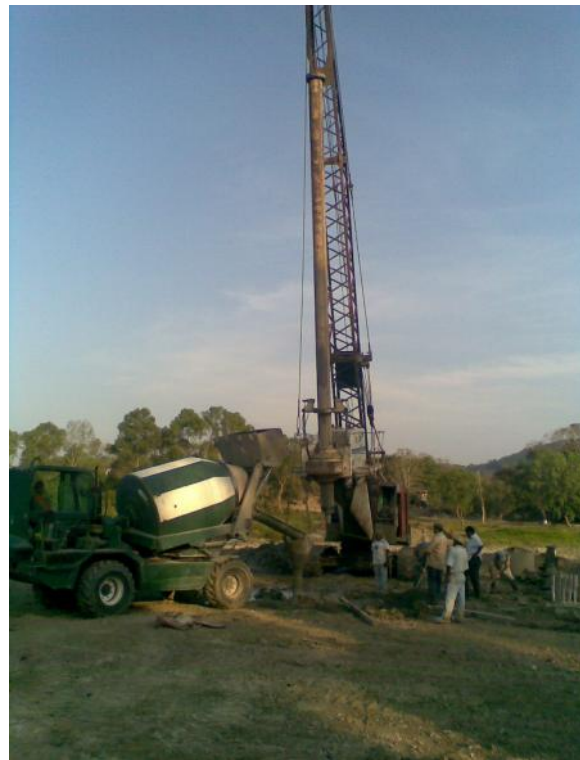
Foto No. 25 Inmediatamente de haber colocado el armado en pilote se coloca el concreto con resistencia de acuerdo a proyecto, esto con la finalidad de que no se presente caídos.
