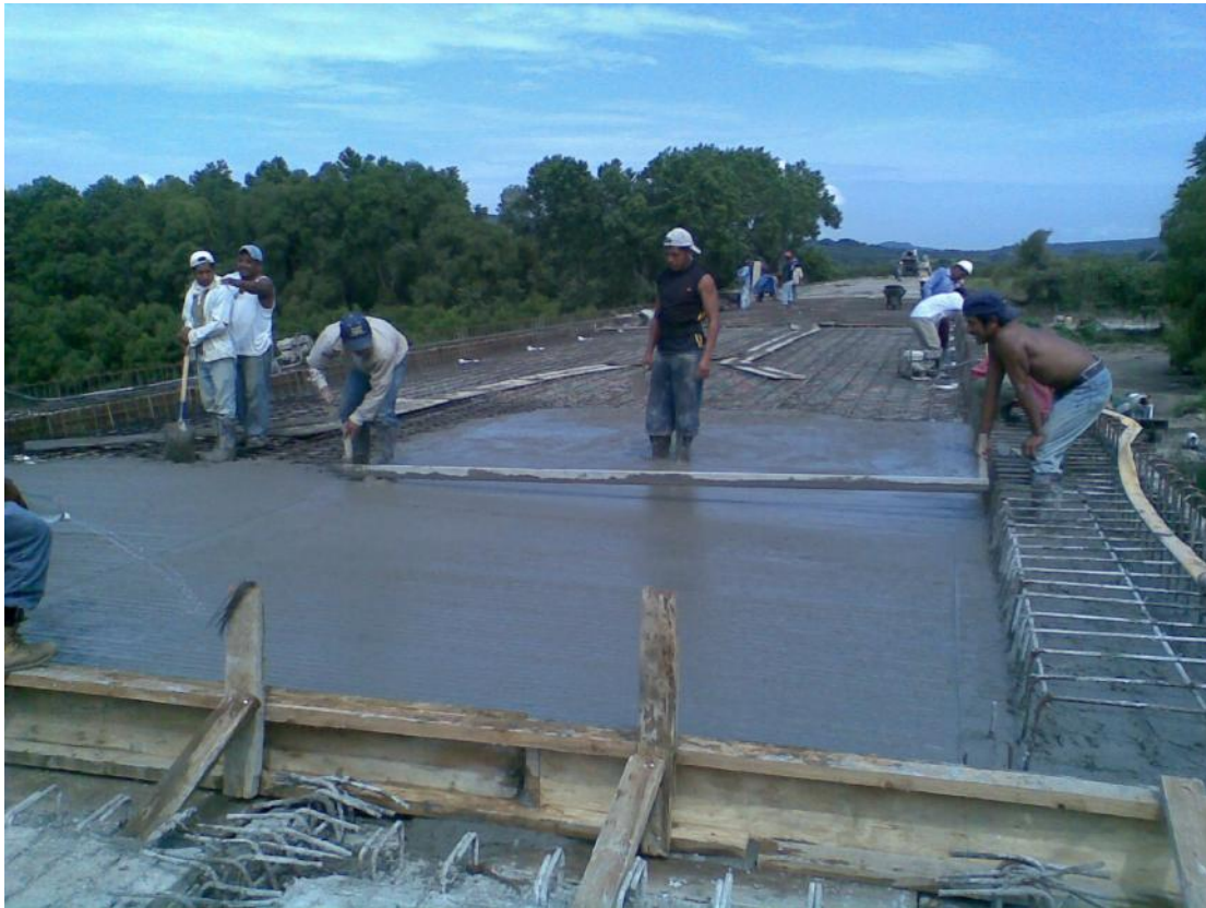
Foto No. 125 Nivelación con regla manual del concreto.
