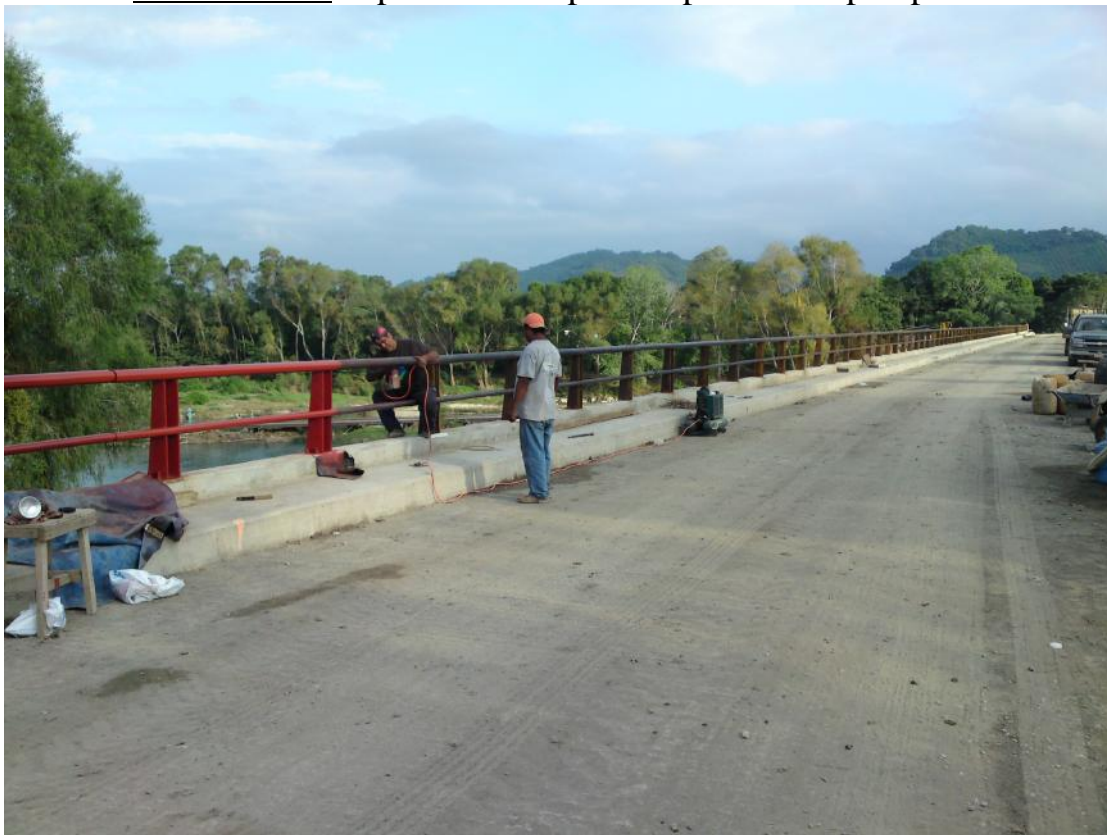
Foto No. 157 Aplicación de pintura primario a parapeto.
