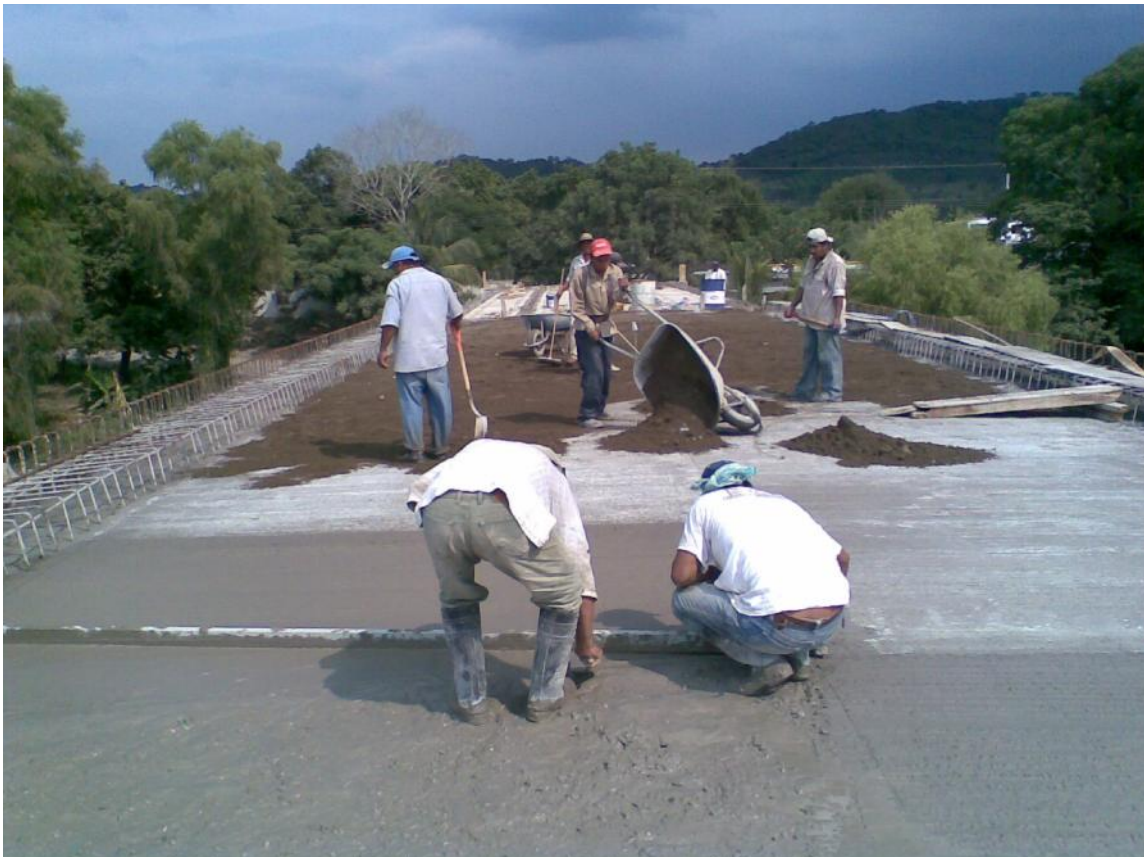
Foto No. 130 Colocando arena humedad para que el concreto no pierda humedad.
