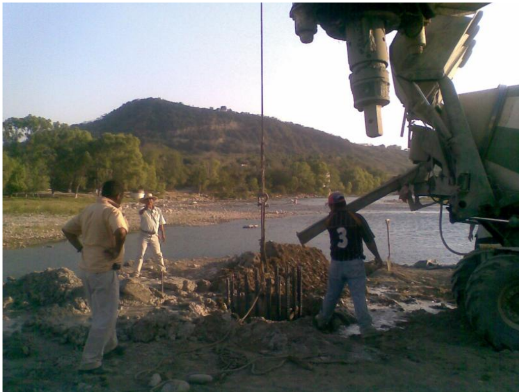
Foto No. 27 Se observa el inicio de un colado de pilote, con la tubería tremie.
