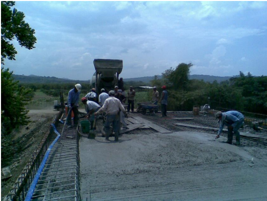
Foto No. 124 Vaciado de concreto en losa y acomodo de este.
