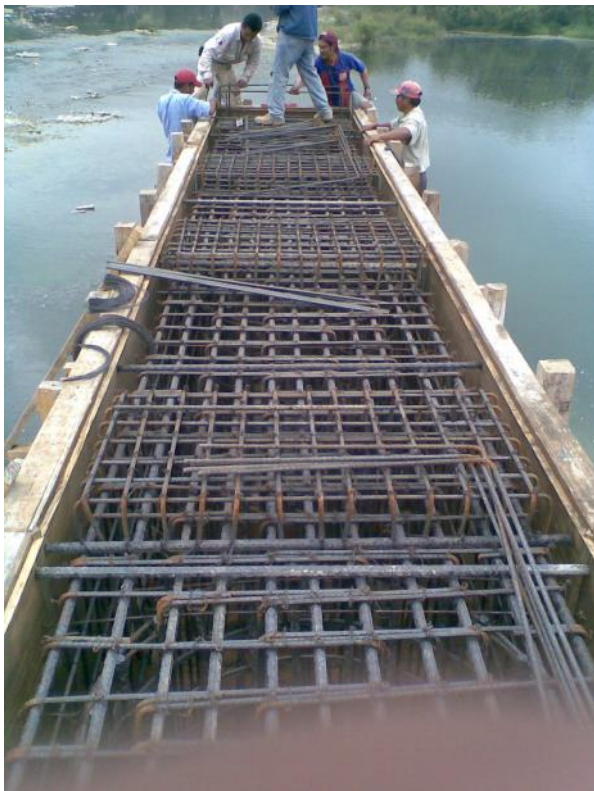
Foto No. 68 y 69 Se observa que los fierros están terminando de armar los bancos de apoyo y topes sísmicos.
