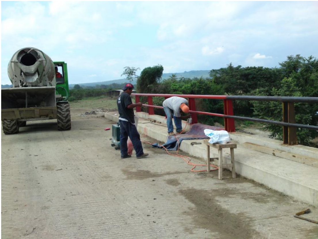
Foto No. 157 Aplicación de pintura primario a parapeto.
