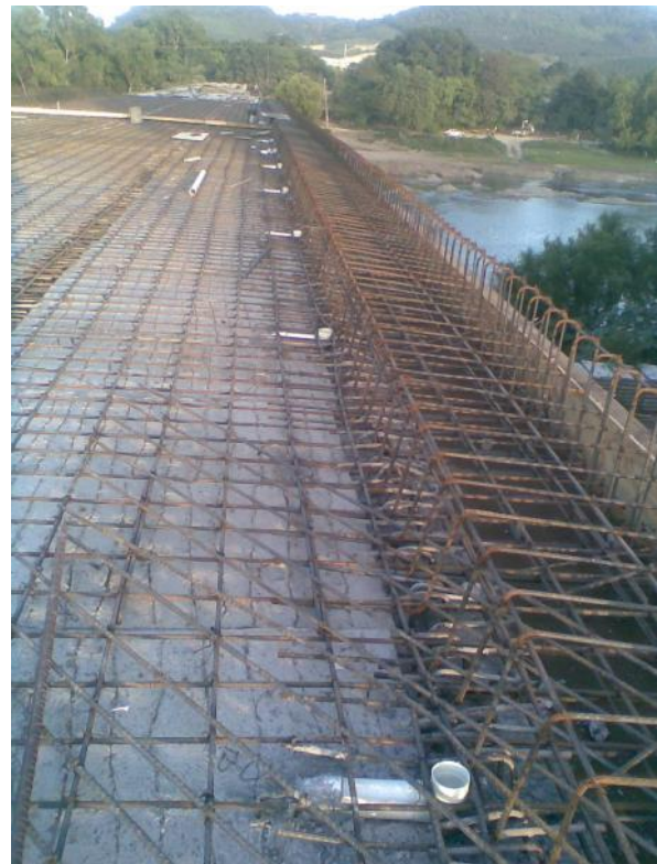
Foto No. 121 Ya se tiene el armado en su totalidad y se están armando las siguientes trabes.
