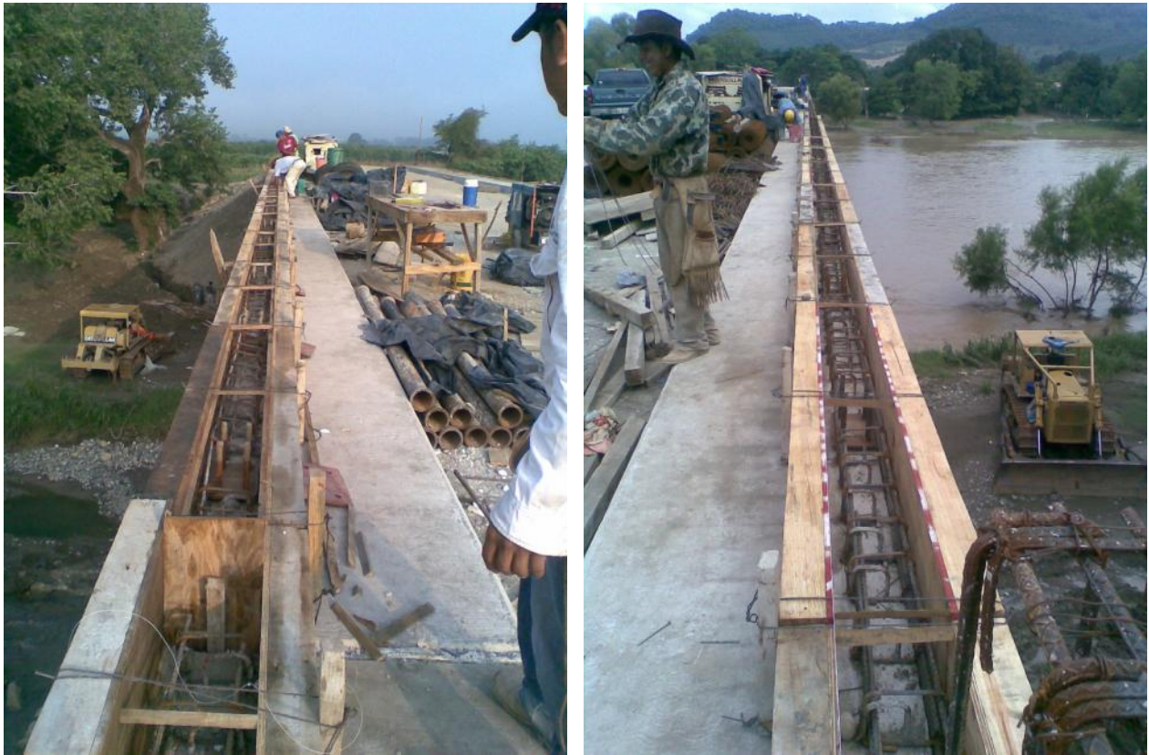
Foto No. 145 Cimbrado de guarnición y que se están alojando las pilastras del parapeto
