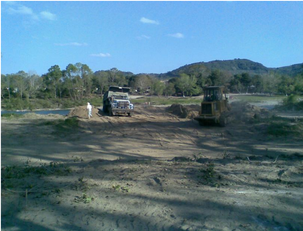
Foto No. 13 Se observa cómo se va conformando la península o plataforma para los trabajos del puente
