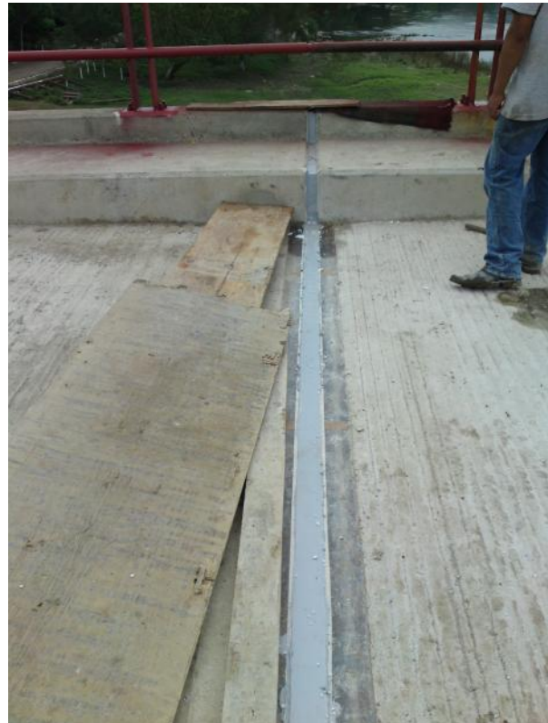
Foto No. 134 Colocando junta de Sikaflex 1-A, como se observa debe de ser hasta la parte de arriba. sobre la banqueta y guarnición
