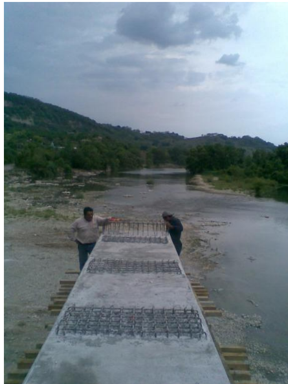
Foto No. 73 y 74 Cimbrado y armado de bancos y topes sísmicos.
