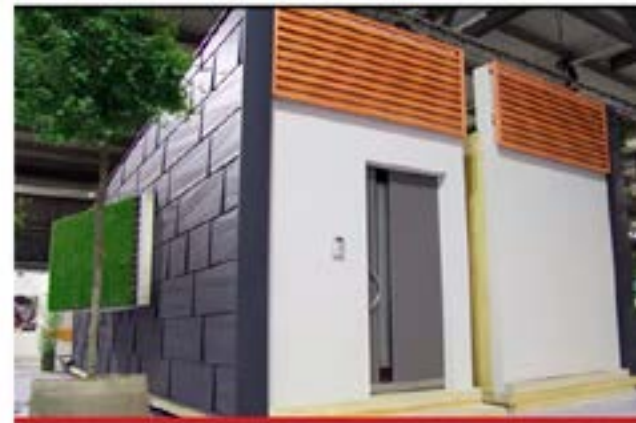
RESULTADO FINAL DEL PRODUCTO PREFABRICADO E INDUSTRIALIZADO.
