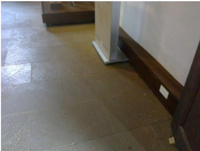
Contacto eléctrico instalado en zoclo de madera.
