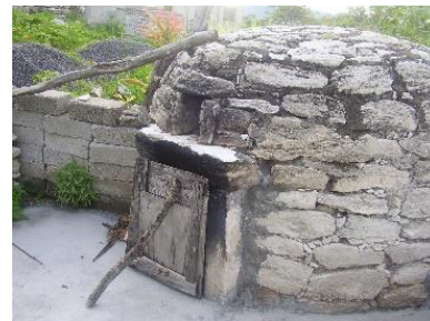
Acceso al interior por medio de semimarco, de piedra caliza canteada a mano.
