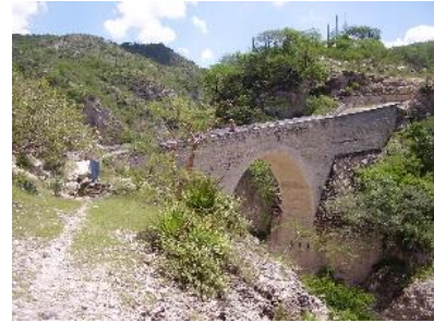
Puente San Antonio, cruce sobre Río Atoyac.
