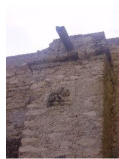
Contrafuerte, con remate de gargola de media caña.
