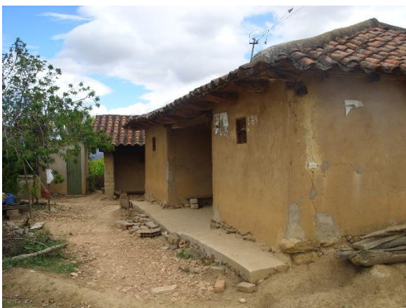
Ilustración 66. Segundo momento de hibridación. Construcción de un volumen para albergar el baño en una vivienda en el Bosque Seco de Gachantivá.
