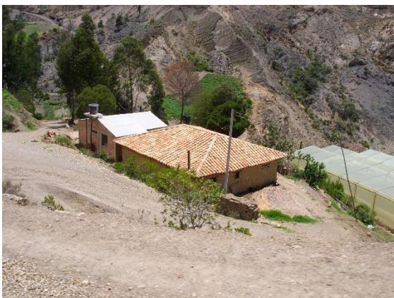
Ilustración 68. Cuarto momento de hibridación. Construcción de volúmenes nuevos para reemplazar los antiguos, con materiales industrializados y áreas reducidas. Vivienda en el Bosque Seco del municipio de Sáchica.
