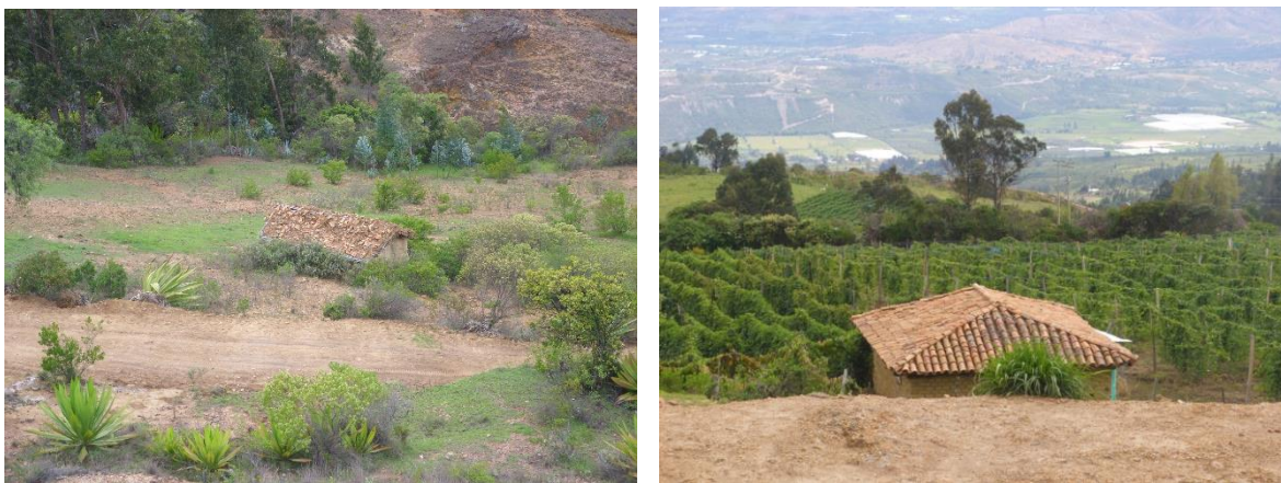
Ilustración 22. El uso de materiales del entorno en la cubierta permite que el inmueble se camufle en el Bosque Seco (izq.), mientras que en otras zonas de vida la edificación tiende a destacarse en el paisaje (der.)
