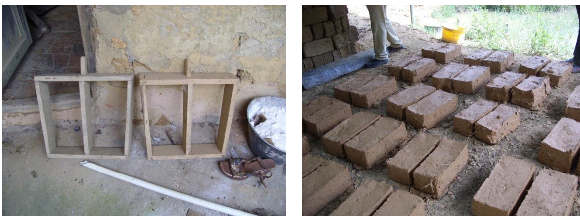
Ilustración 28. Gaveras con forma de punta de diamante (izq) y proceso de secado de adobes (der) en el municipio de Ráquira.
