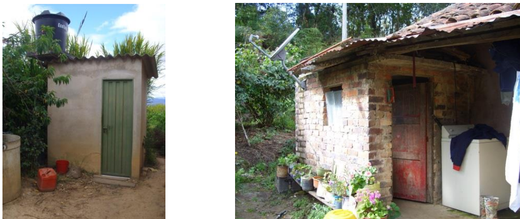
Ilustración 46. Solución estatal (izq) que se caracteriza por ubicarse en un volumen aislado de la vivienda vs. baño construido por autogestión (der) que ha sido incorporado al volumen principal.
