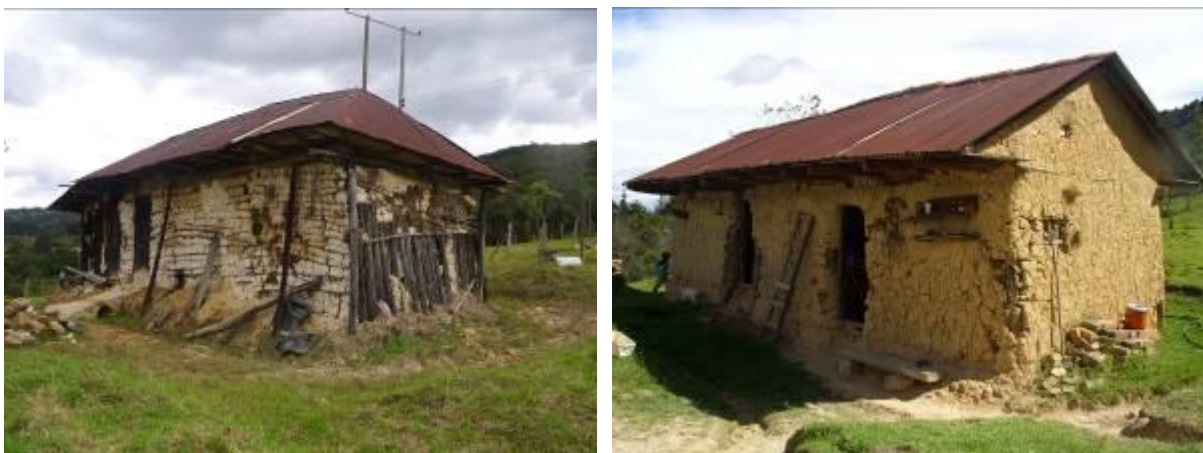
Ilustración 26. Uso del bahareque en Arcabuco (izq) y en Tinjacá (der); las dos edificaciones se encuentran abandonadas. Nótese la tonalidad de la tierra utilizada en cada caso, que varía de un municipio al otro.
