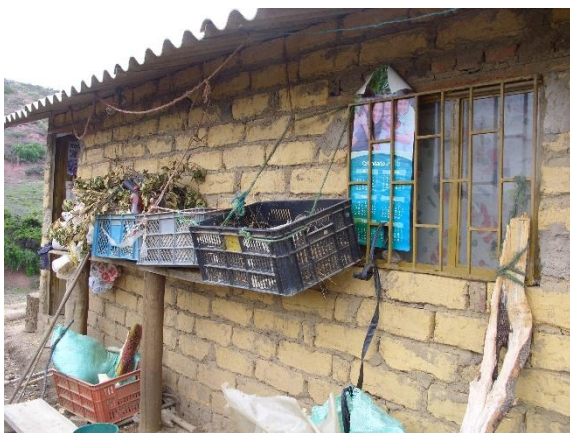
Ilustración 77. Uso de carpinterías metálicas sobre muros de adobe en Sáchica (izq.) y Arcabuco (der.)
