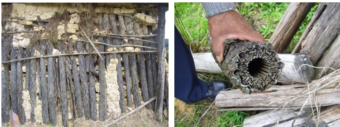
Ilustración 24. Utilización de madera de un helecho arborescente en una vivienda del municipio de Arcabuco. Su uso no fue reportado en otras edificaciones visitadas.
