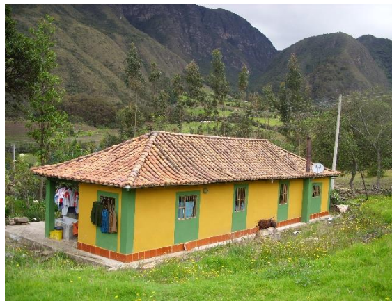
Ilustración 77. Uso de carpinterías metálicas sobre muros de adobe en Sáchica (izq.) y Arcabuco (der.)
