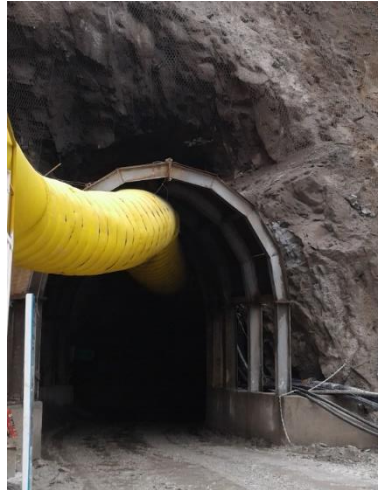
Figura 16.- Bocamina de proyecto San Rafael.
