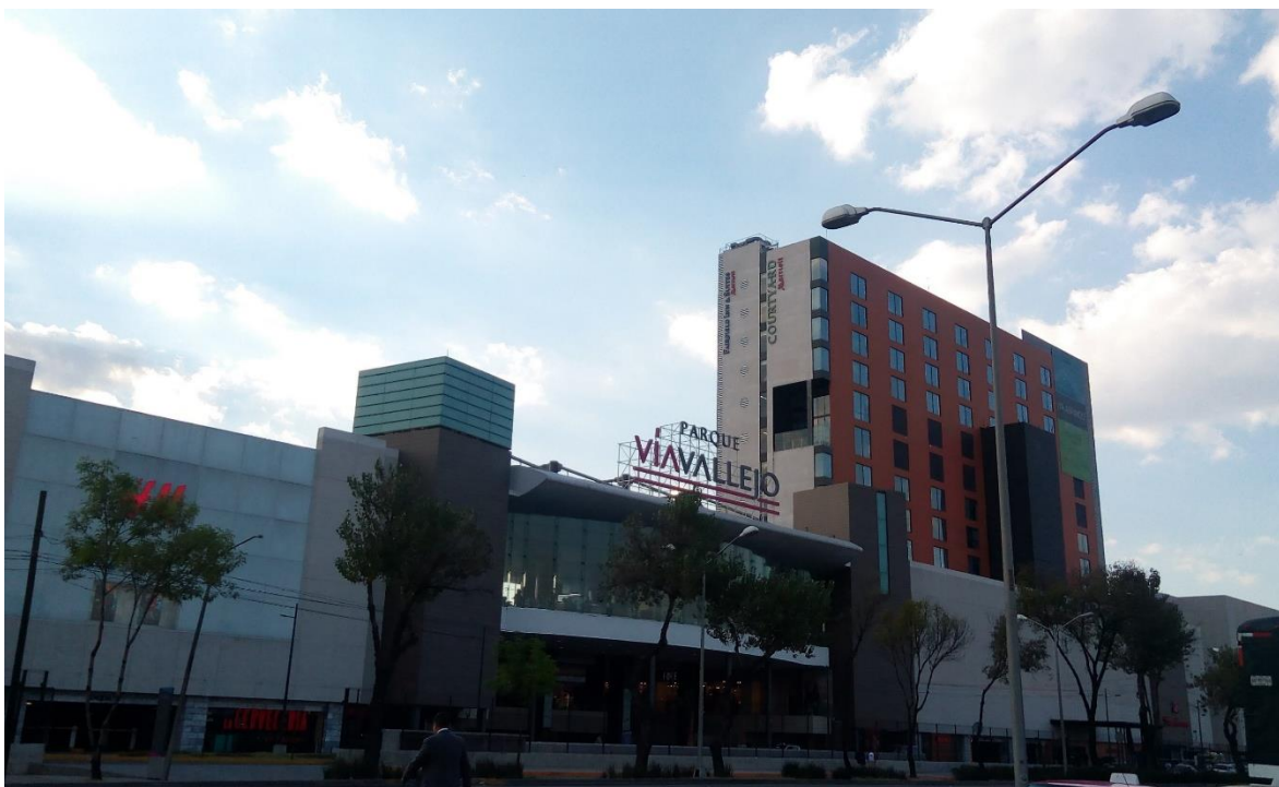
Imagen 3. Centro Comercial Parque Vía Vallejo . Zona Industrial de Vallejo.
