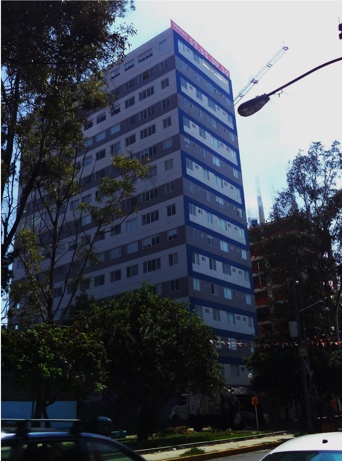
Imagen 9. Construcción del conjunto Enksa Azcapotzalco . Ampliación Del Gas.
