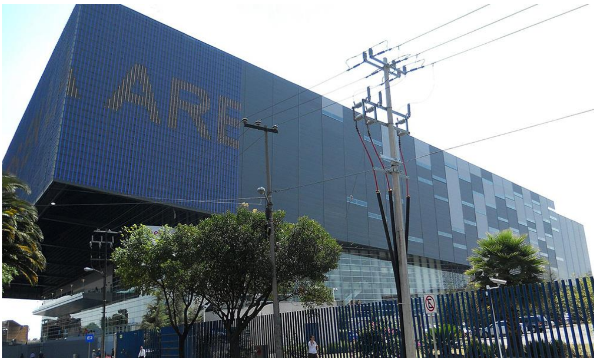
Imagen 2. Arena Ciudad de México, Ferrería.
