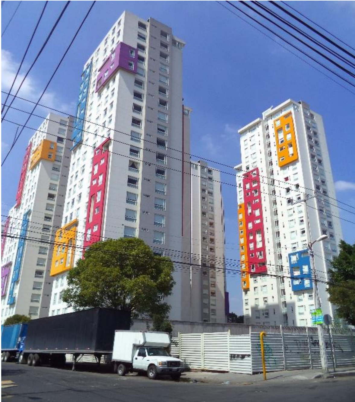
Imagen 4. Torres del conjunto Tres Lagos . Ampliación Del Gas.
