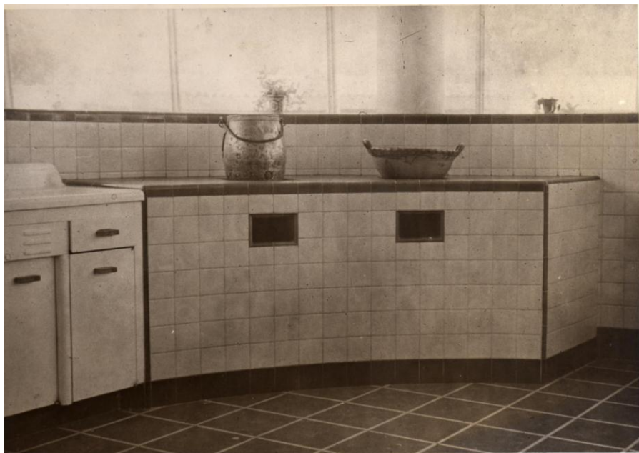
Imagen 29. Vista interior de la cocina de la casa de Don Victoria Arana, casa denominada “El Barco” .
