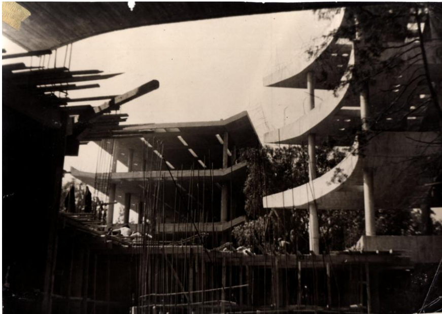
Imagen 31. Vista interior – Construcción de entresijos de la E.S.I.M.E. de la Ciudad Politécnica.
