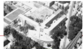
Escuela Superior de Ingeniería, Mecánica y Eléctrica.(ESIME) J.L. Hernández Mendoza 1954.
