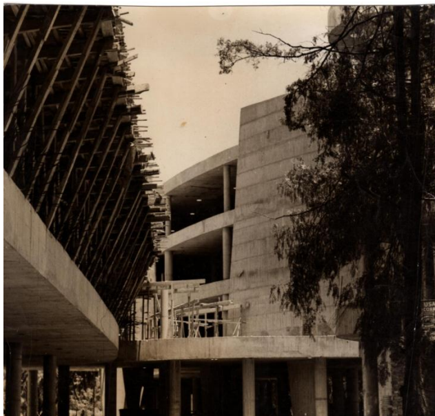
Imagen 35. Vista interior – Construcción de entresijos de la E.S.I.M.E. de la Ciudad Politécnica.
