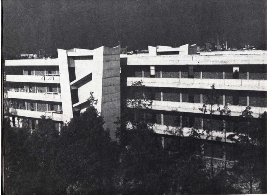
Imagen 39 . Vista panorámica de la Escalera con 4 Niveles de la E.S.I.M.E. en la llamada Ciudad Politécnica, 1954.
