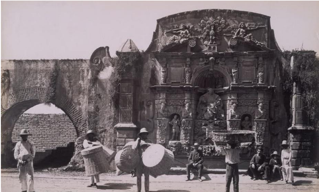
Fuente de la Tlaxpana y el acueducto de Santa Fe. Esta fue de las últimas en ser demolidas, en 1899
