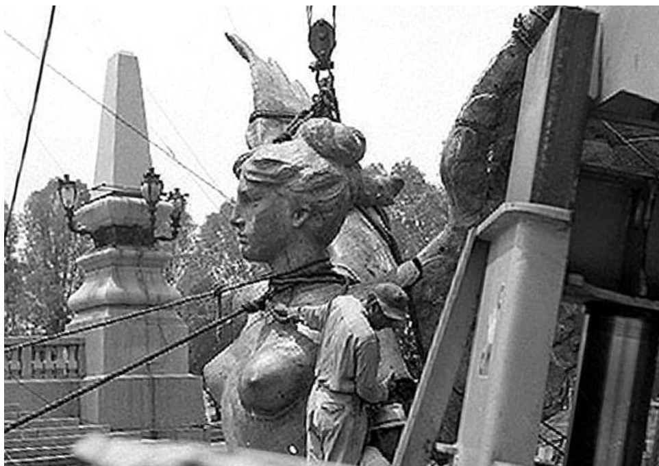
Maniobras para regresar a su sitio la estatua del ángel, restaurada tras el sismo del 57'. Archivo de los hermanos Casasola.
