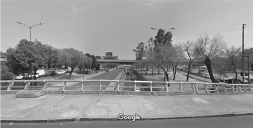
Viaducto en su intersección con Av. Congreso
