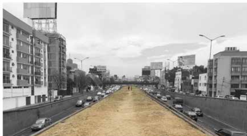
Desnivel de la avenida Viaducto Miguel Alemán y Av. Insurgentes Sur
