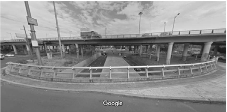
Viaducto en su intersección con Av. Troncoso
