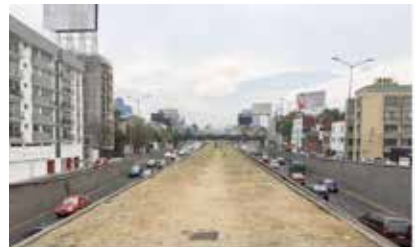
01. Viaducto Río de la Piedad
