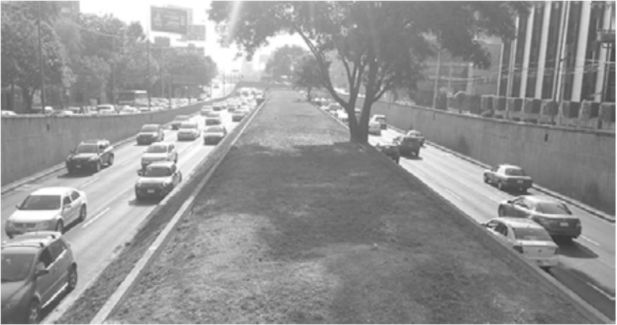
Viaducto, en la parte cercana a Insurgentes
