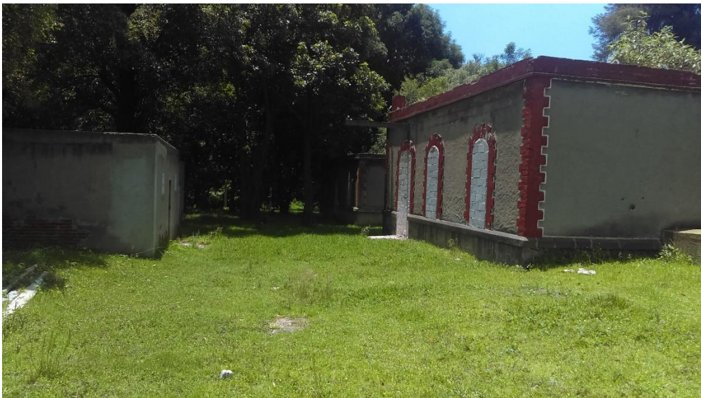
Fotografía 1. Vista actual de la primera planta hidroeléctrica de América Latina instalada a un costado del cauce del Río Atoyac. (Tomada por el autor)
