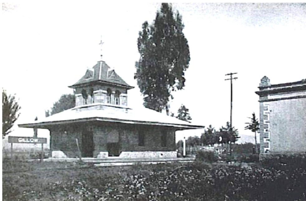
Fotografía 3. Vista de la Estación Gillow a finales del siglo XIX, localizada en los terrenos de la Hacienda de Chautla
