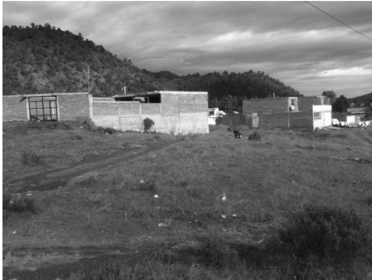
Fotografía 5.8.1. Fuente: Foto tomada en sitio. Viviendas aún en construcción, ubicadas casi llegando al cerro Cumbuán, al norponiente de Paracho. Enero de 2014
