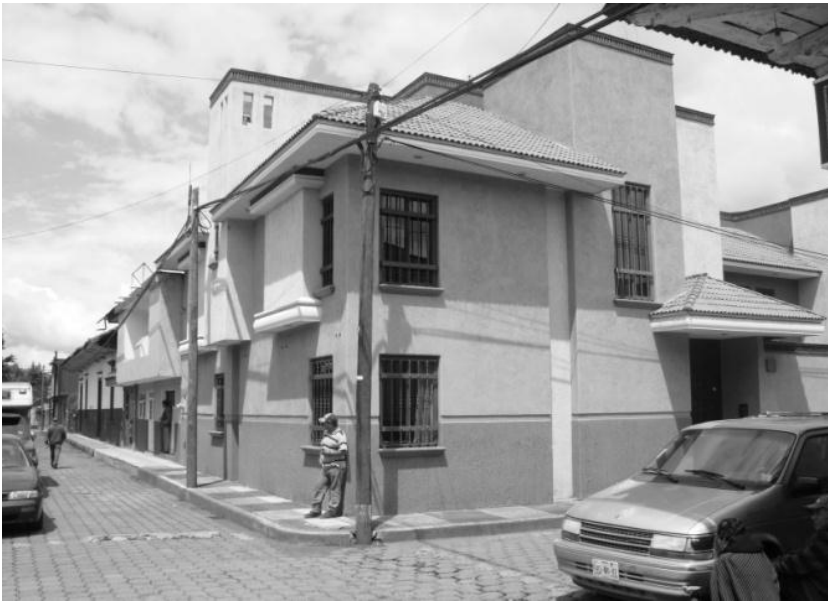
Fotografía 5.8.1.3 Fuente: foto tomada en sitio. Casa con sistema constructivo de concreto, con todos los servicios. Enero de 2014
