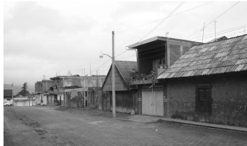
Fotografía 5.8.1.1 Fuente, foto tomada en sitio. Se nota el deterioro de la casa en su exterior y algunas, por tener cubierta de lámina deteriorada, corren el riesgo de colapsar. Diciembre de 2013
