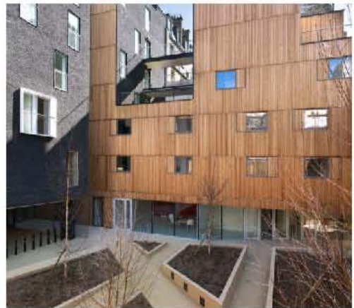
Fachadas interiores, vista desde el patio interior **1 B.4
