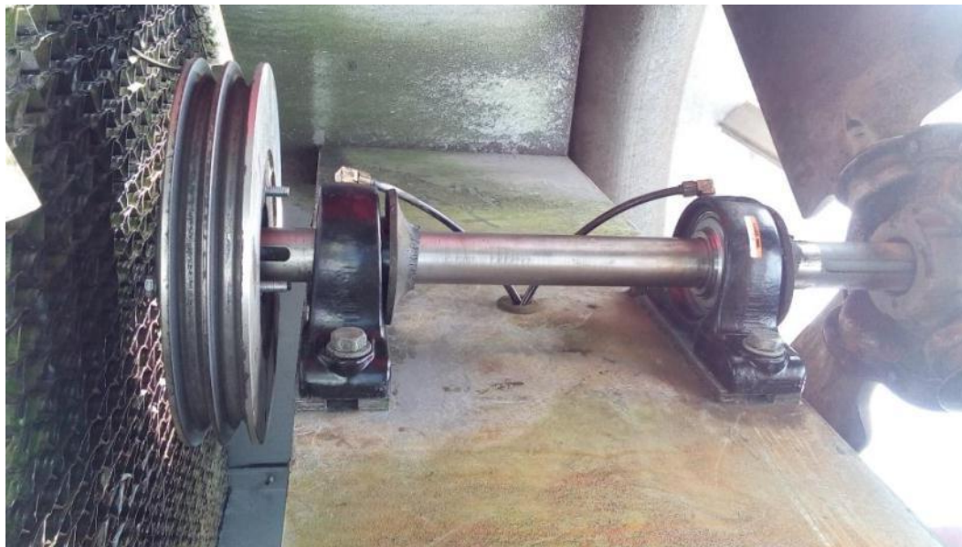
Figura 3.27 Cambio de chumaceras y bandas de ventilador de torres de enfriamiento
