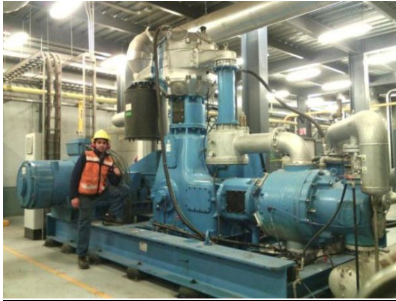
Figura 3.10 Compresor de alta presión de 3 etapas de 40 bar Atelier Francois
