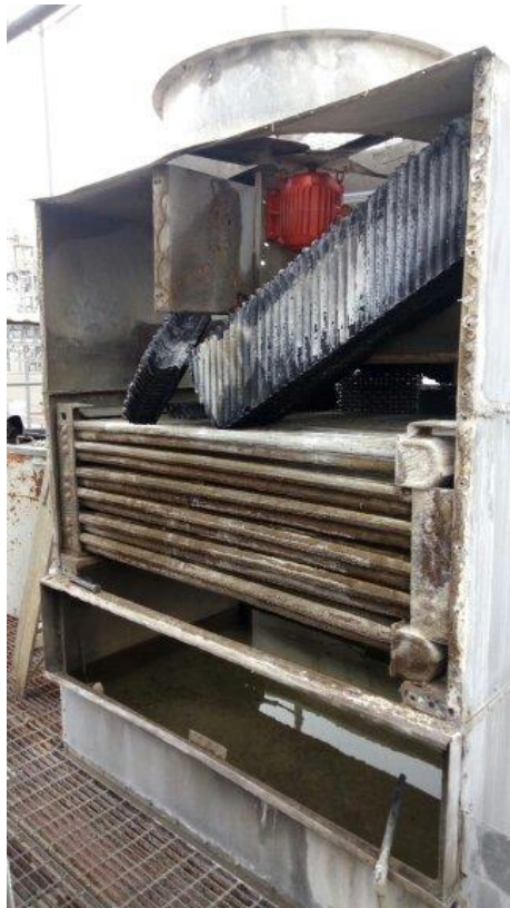
Figura 3.29 Limpieza y desincrustacion de tubos fluxes en torres de enfriamiento
