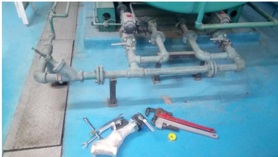
Figura 3.7 Reemplazo de válvulas en Calderas
