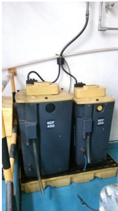
Figura 3.18 Mantenimiento anual a separadoras de aceite
