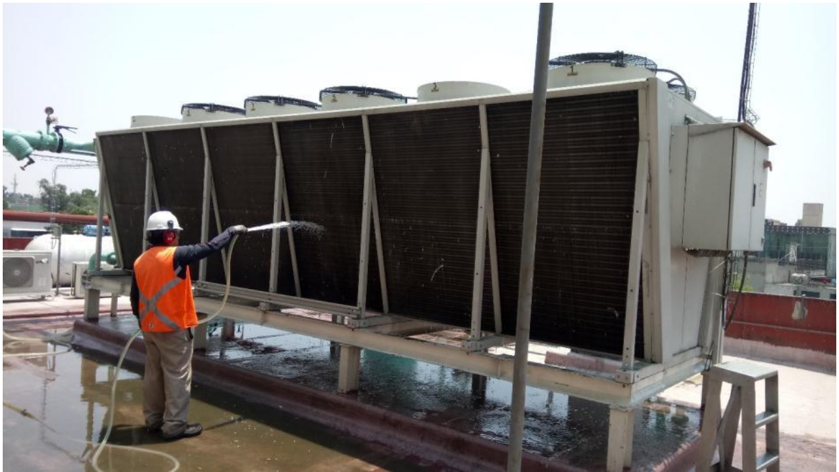
Figura 3.28 Limpieza de paneles de aerofriador
