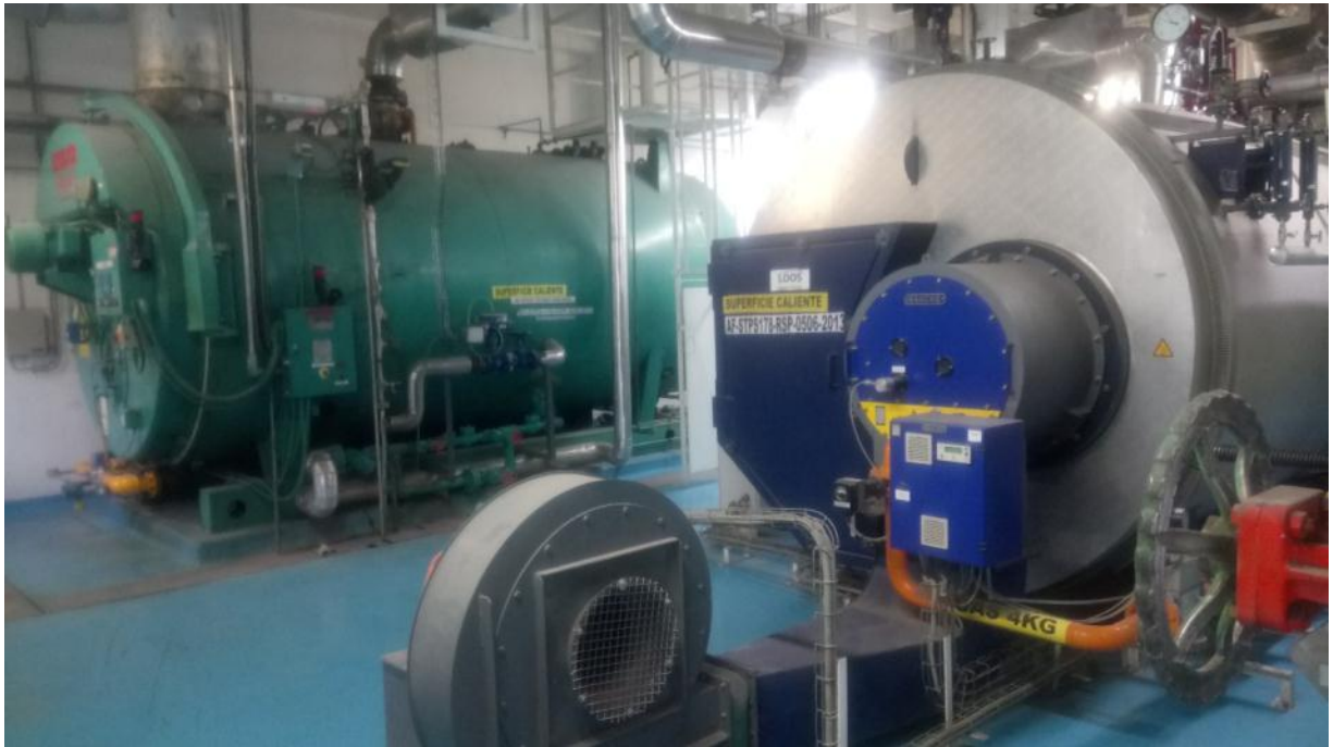
Figura 3.1 A izquierda, caldera Cleaver Brooks 500 C.C y a la derecha, caldera Bosch 600 C.C
