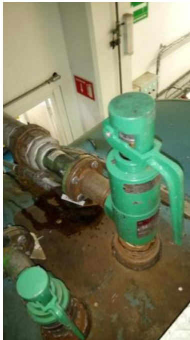
Figura 3.5 Reemplazo de válvulas de seguridad de las calderas
