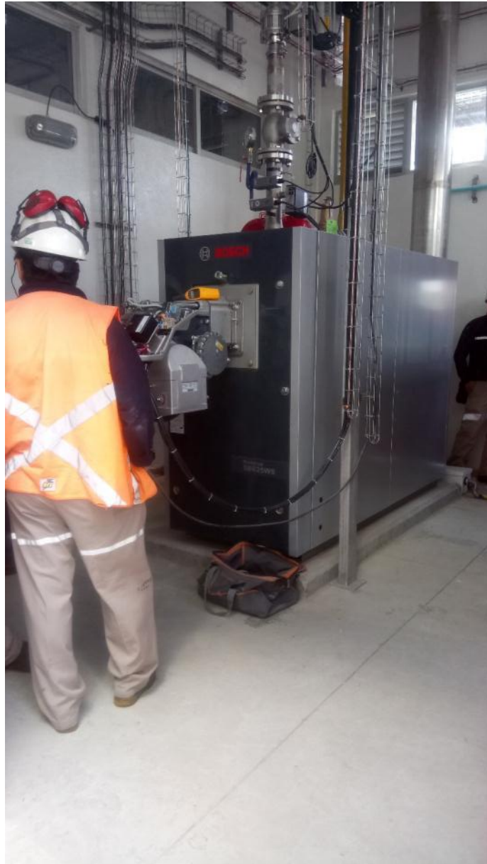
Figura 3.30 Puesta en marcha de calentadores Bosch
