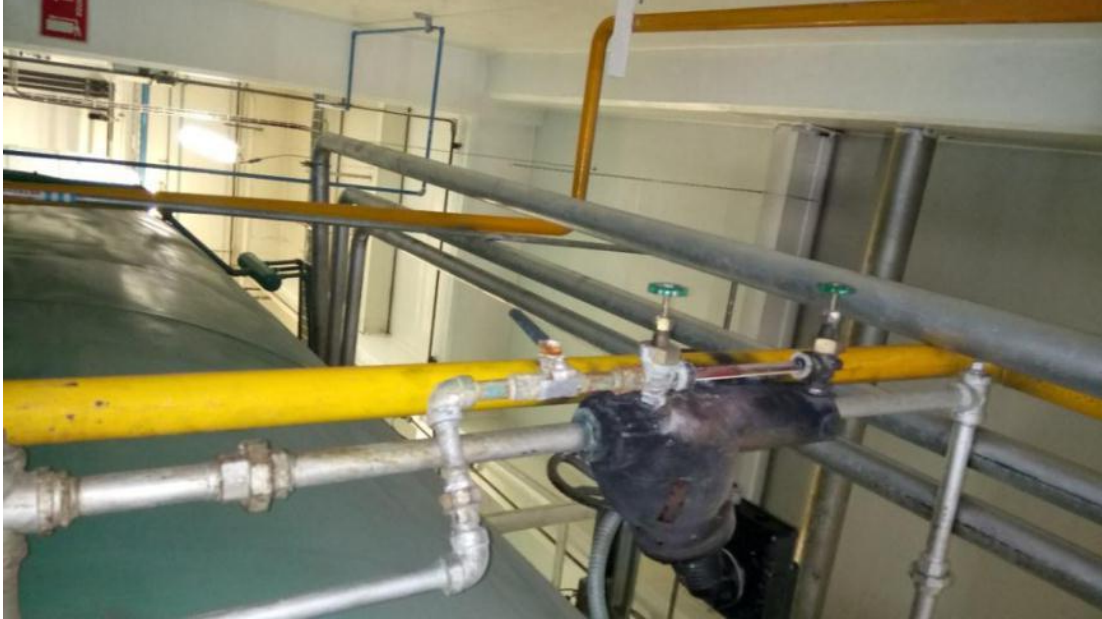
Figura 3.8 Limpieza del cristal de nivel de agua de la caldera
