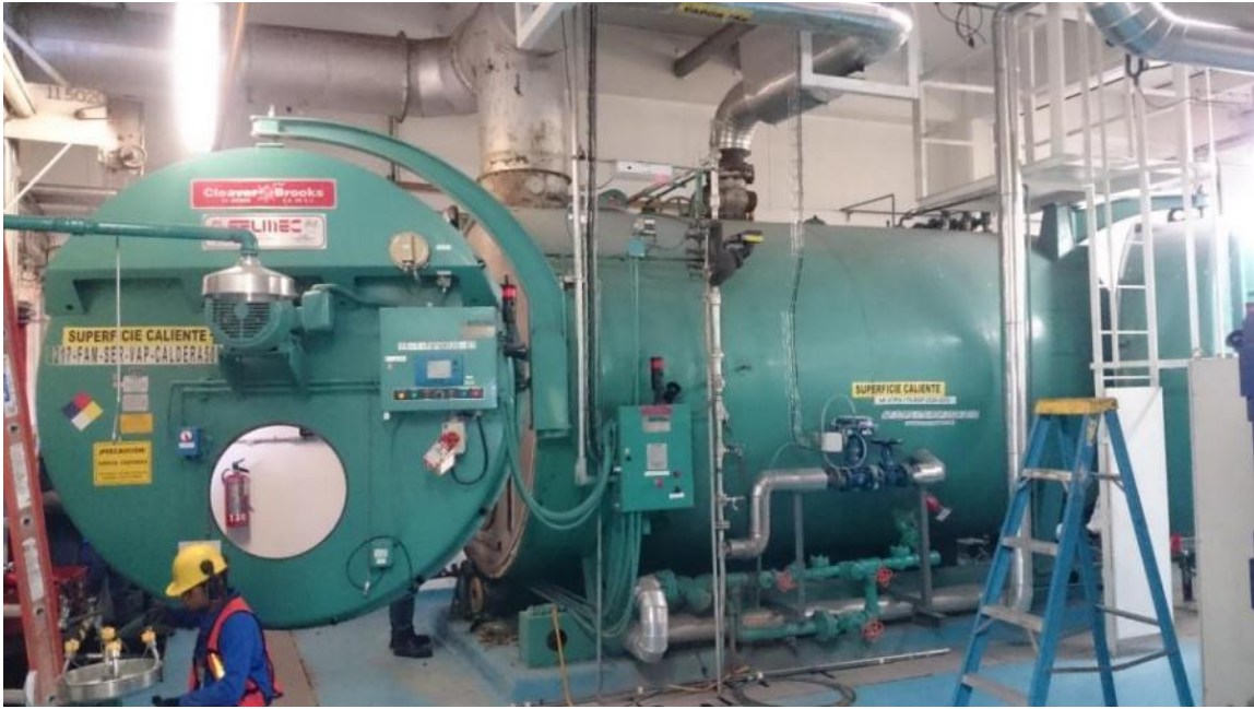
Figura 3.4 Mantenimiento Anual a Caldera Cleaver Brooks 500 C.C
