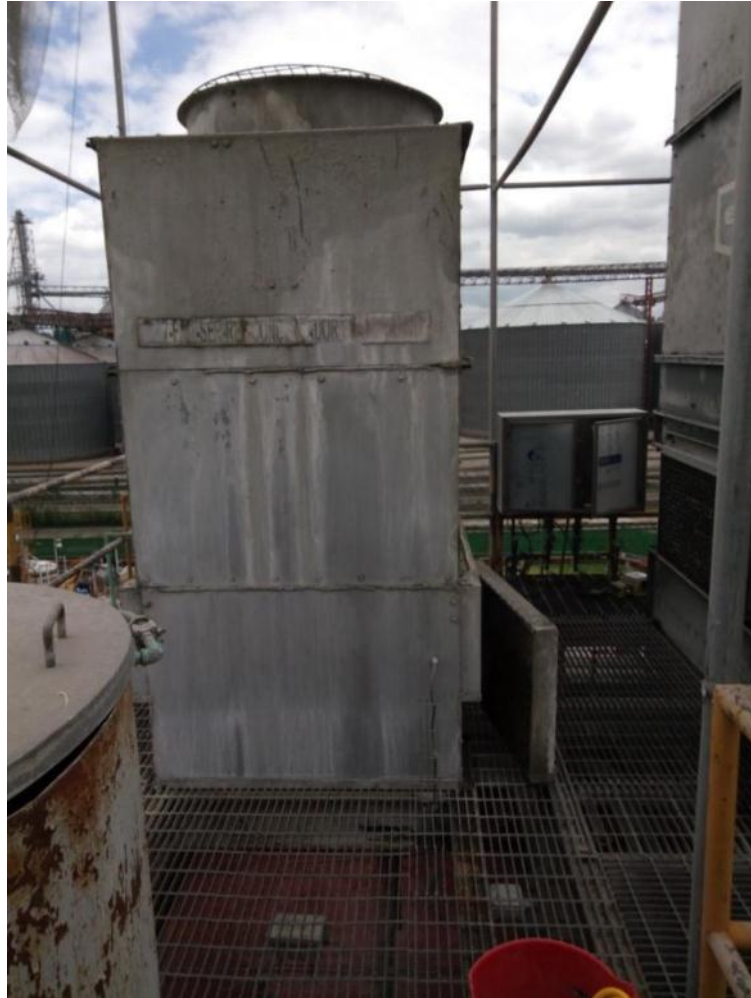
Figura 3.22 Condensador evaporativo Evapco
