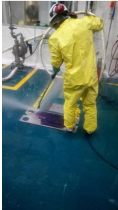
Figura 3.26 Mantenimiento y limpieza de intercambiador de placas
