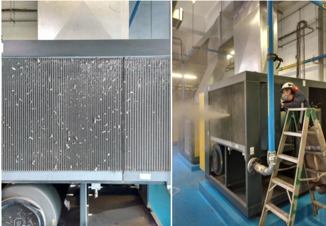
Figura 3.16 Limpieza y sopleteado de panel de enfriamiento.
