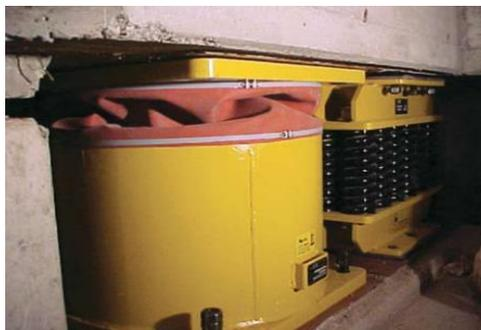
**Figura 1.24. Resorte tipo GERB y amortiguador viscoso (Tornello y Sarrazin,2004)**
