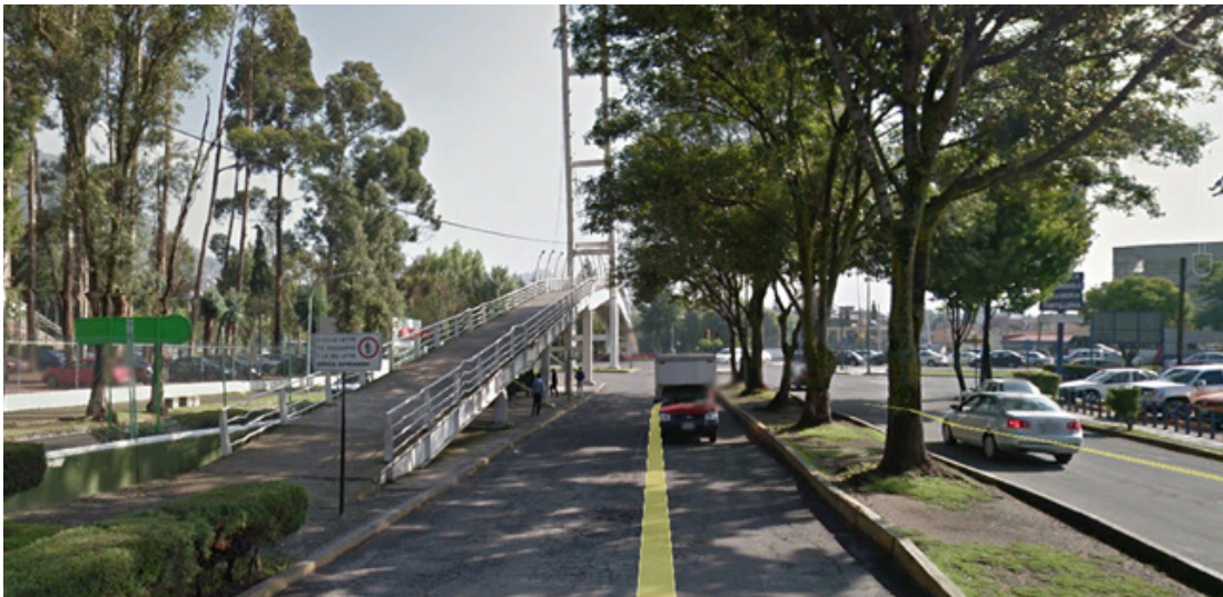
fig13: Vista de acceso al puente. fuente google maps
