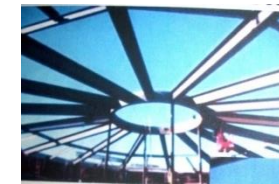
IMAGEN# 45 : sistema constructivo a base de vigas de acero.
