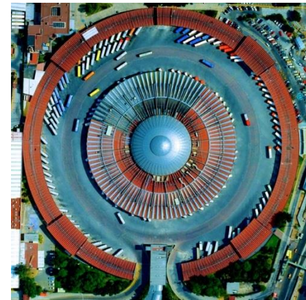
IMAGEN# 43 : vista desde arriba del edificio principal terminal TAPO, Cd de Mexico
