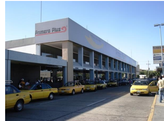
IMAGEN# 33 nueva terminal de autobuses Guadalajara
