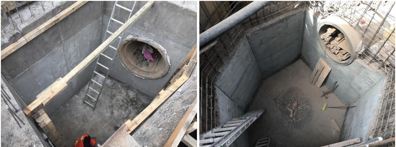
Figura 54 Descimbrado de muros perimetrales en cajas de deflexión CD-01 y CD-02.
