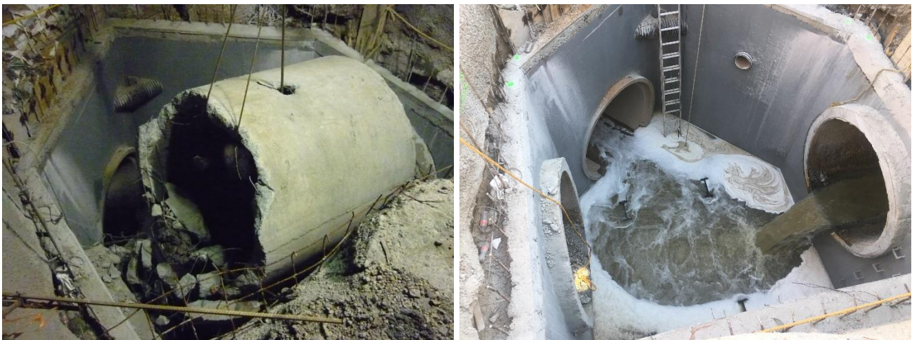
Figura 84 Retiro del colector que se encontraba en servicio
