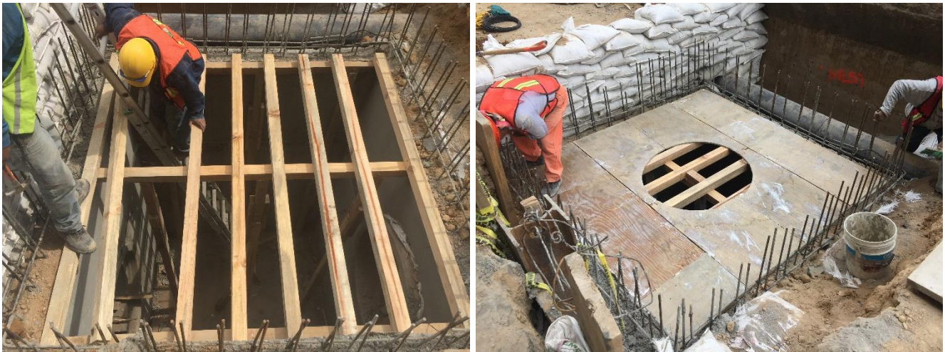
Figura 55 Colocación de cimbra para losa tapa de un pozo caja
