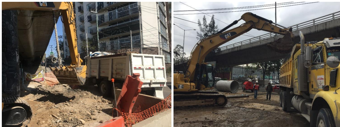
Figura 35 Carga de material producto de excavación y demolición
