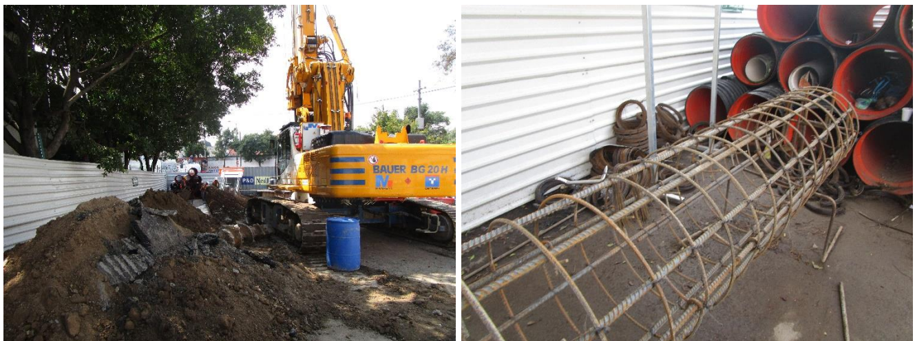
Figura 36 Armado de las pilas de concreto en el perímetro de caja de conexión CC-02
