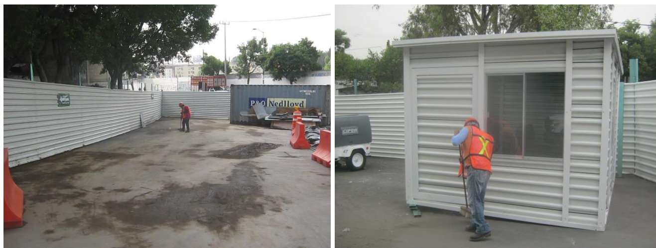
Figura 21 Almacén y oficinas en obra
