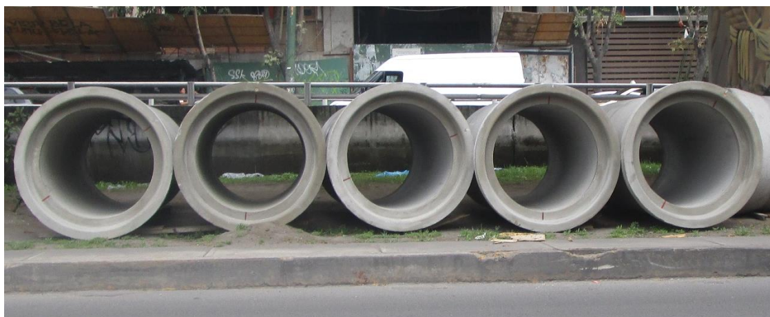
Figura 63 Tubos de concreto reforzado estibados en obra
