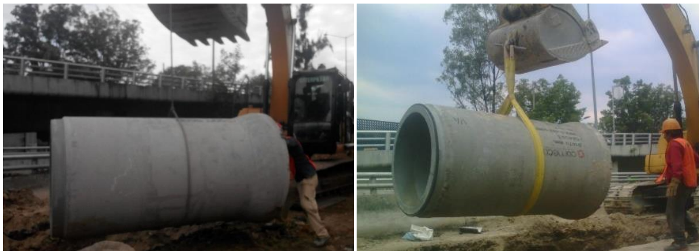
Figura 66 Herramientas empleadas para izar tubos de concreto reforzado
