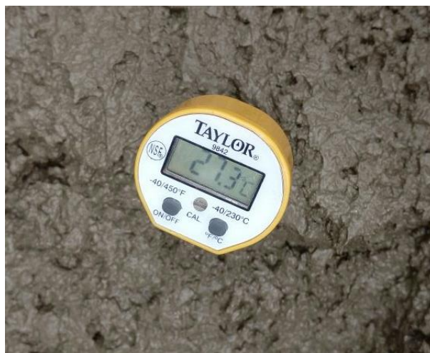
Figura 13 Termómetro colocado en concreto en estado fresco
