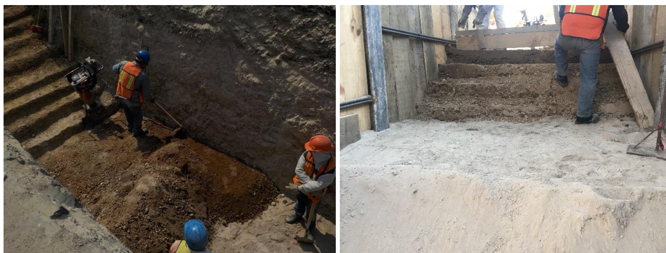
Figura 72 Capas de relleno de zanja de tubería
