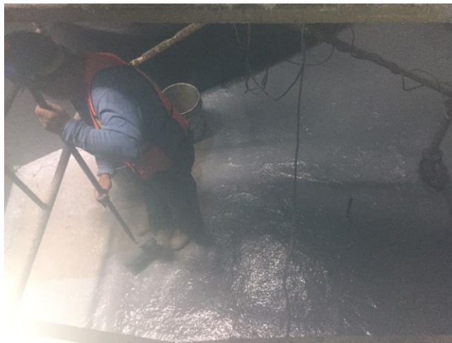
Figura 62 Aplicación de impermeabilizante en losa de fondo en un pozo caja
