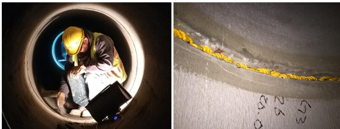
Figura 81 Trabajos de calafateo al interior de la tubería de 107 centímetros
