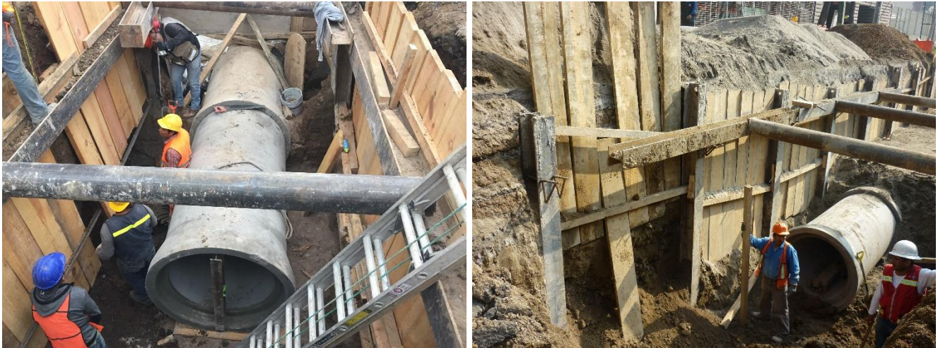
Figura 69 Muro berlín, tubería instalada y acostillado de tubería
