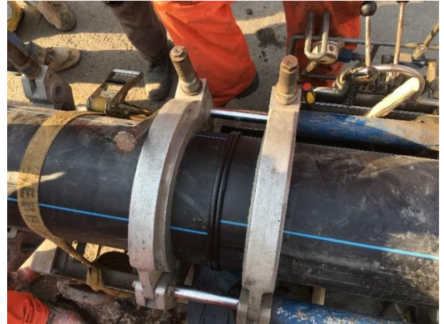
Figura 28 Desvío de tubería de agua potable de PEAD de 12"
