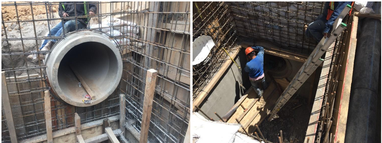
Figura 52 Armado de muros perimetrales de un pozo caja
