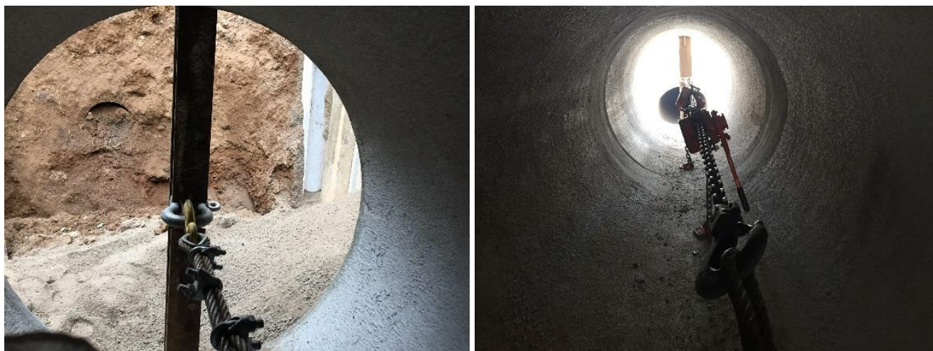
Figura 67 Dispositivo de tracción para instalación de tubería
