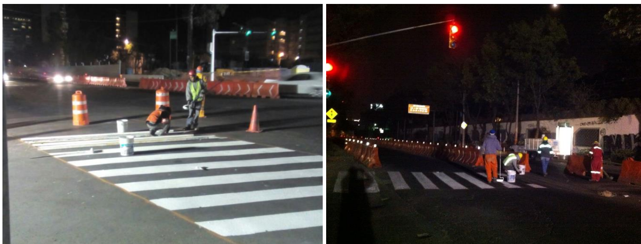
Figura 86 Pintado de balizamiento después de la restitución de la vialidad
