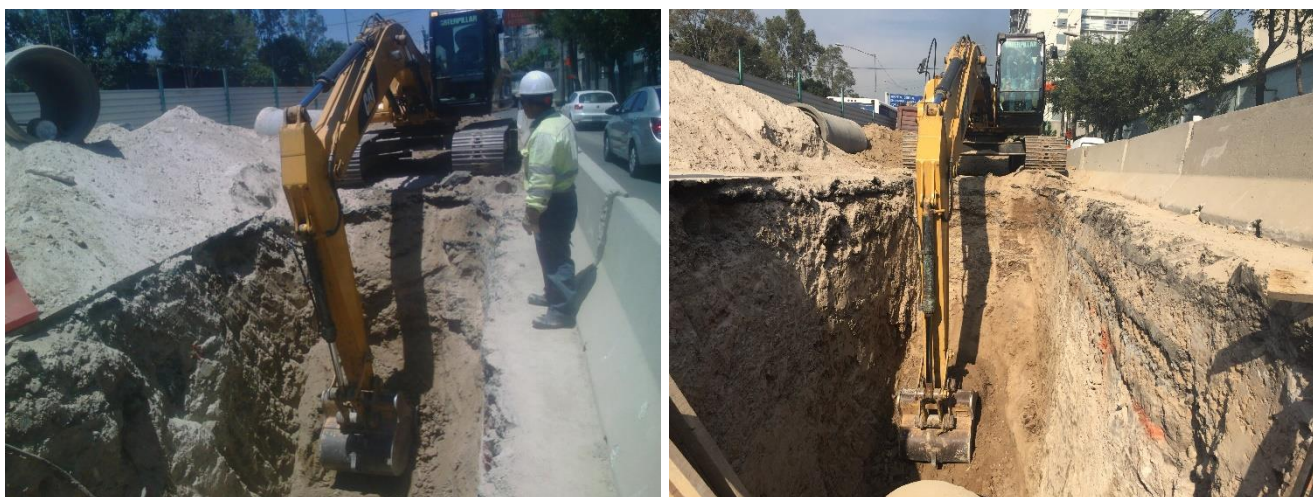
Figura 41 Excavación de zanja con retroexcavadora CAT 320 D.
