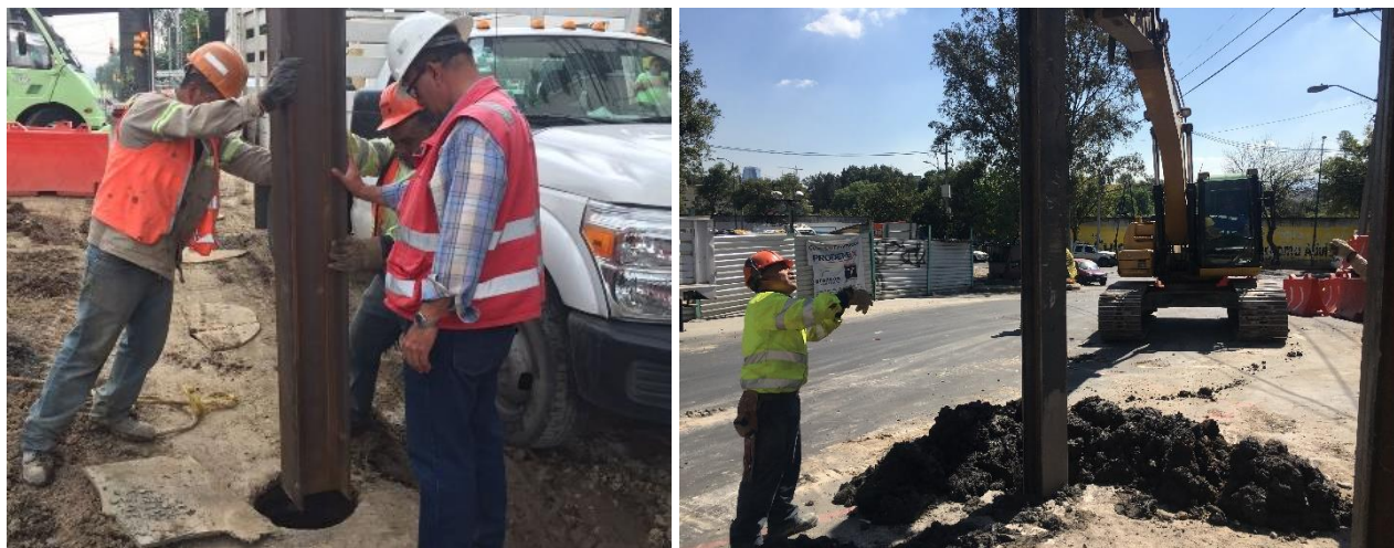
Figura 38 Colocación de viga IR en perforación, trabajos previos a la excavación de zanja para tubería
