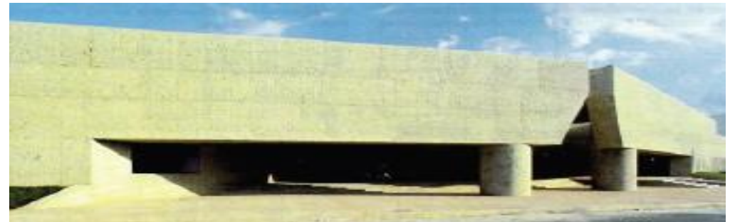
IMG37. Fachada principal.
