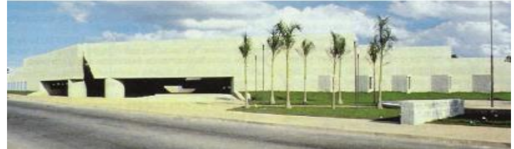
IMG36. Fachada exterior.
