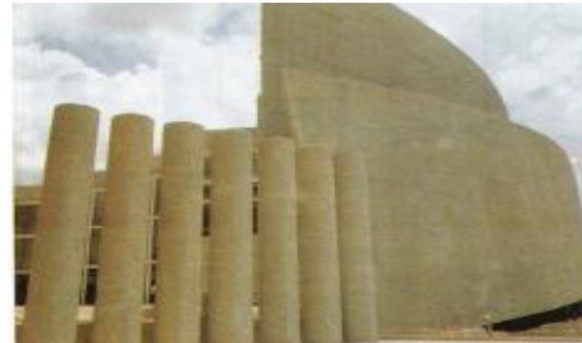
IMG32. Vista de la fachada.
