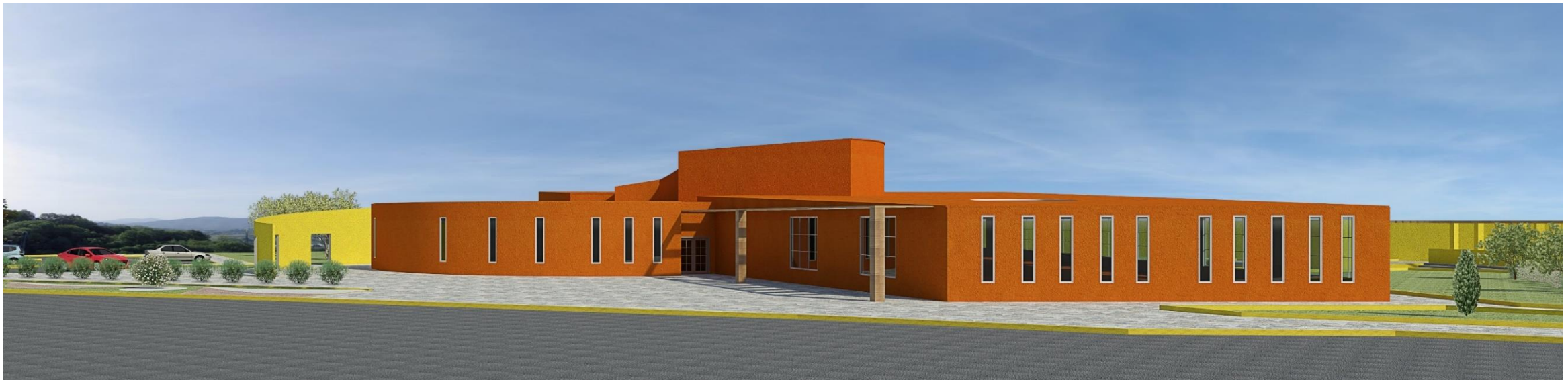
Vista al Acceso Principal
