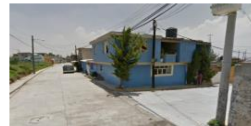
IMG28. Construcción cerca del predio.
