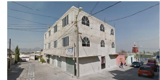
IMG29. Construcción cerca del predio.
