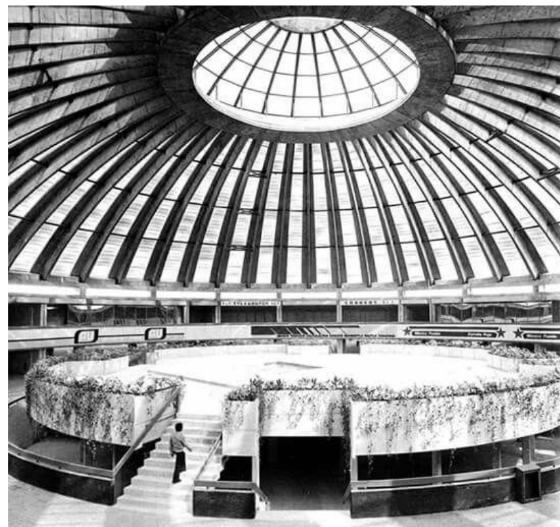
Ilustración 6 Construcción cúpula de la TAPO
