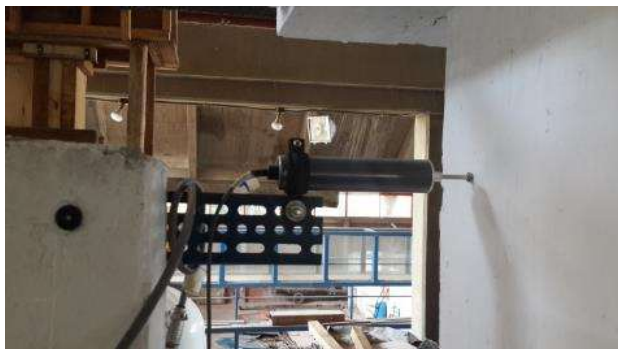
Fig. 2.8 Colocación de transductor 4
