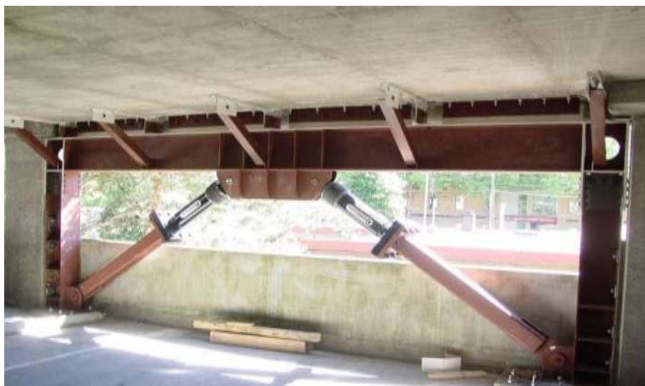
Fig. 1.4 Disipador de fluido viscoso [créditos: CDV Ingeniería antisísmica, 2018]
