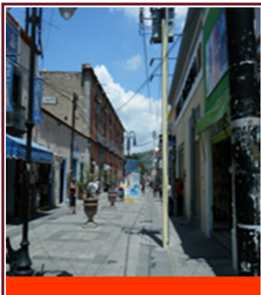
Foto 9: Existe una inminente falta de planeación de equipamiento e infraestructura, sobre todo en el tendido eléctrico. (En toda la zona urbana).
