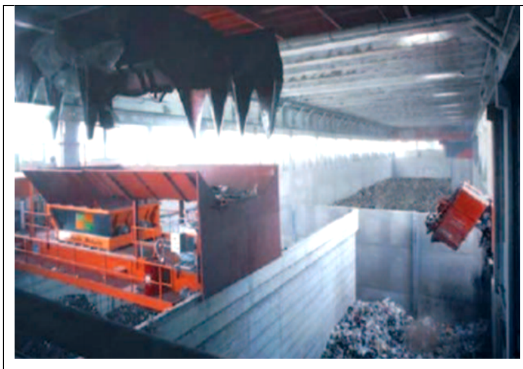
Figura 3.3. Vista interior de la nave industrial de CDR: descarga, trituración y zona de biosecado (Guía de valorización energética de residuos, 2010)
