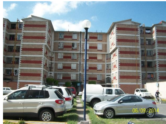
Conjunto Habitacional Ciprés, una de las unidades cercanas a los terrenos, uno de sus edificios presenta filtraciones en el sótano durante tiempo de lluvias.
