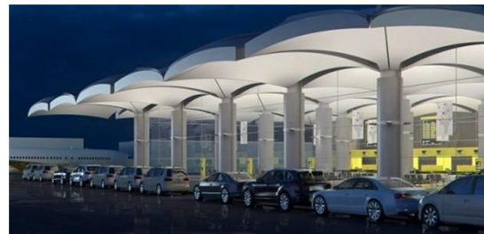
Iluminación y seguridad en las noches. infoconstruccion.es, 2015.
