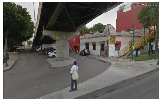
Bajo Puente de la Calle Ciprés, Colonia Atlampa.
