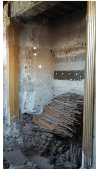
Ilustración 154. Proscenio de lo que fuera el cine "Progreso Mundial", hoy almacén de obra. Fotografía del autor, 2016.
