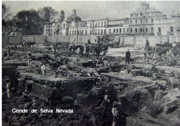
Ilustración 209. Obras de excavación para los trabajos del Teatro Nacional. Fuente: http://www.skyscrapercity.com.showthread.php?t=1055747&page=2 . Acceso, marzo 2015.
