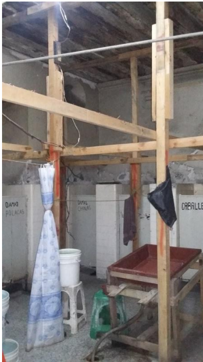
Ilustración 160. Sanitarios de lo que fuera el cine “Progreso Mundial, y donde alguna vez estuviera una capilla interior del Convento de Jesús María. Fotografía del autor, 2016.
