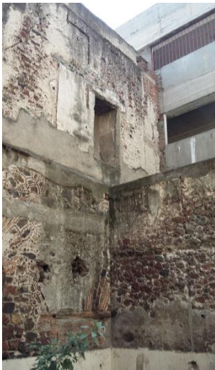
Ilustración 156. Muro que delimitaba el refectorio en Jesús María. Fotografía del autor, 2016.
