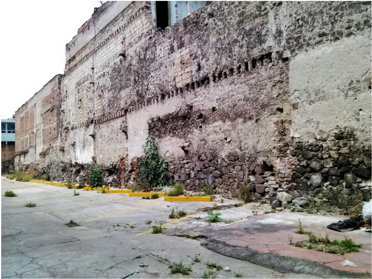
Ilustración 96. Barda norte de lo que fuera el Convento de San Lorenzo. Fotografía del autor, 2015.
