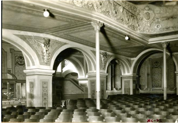
Ilustración 134. Cine "progreso Mundial". Ampliación de la galería del cine con unos apoyos de hierro colado.
