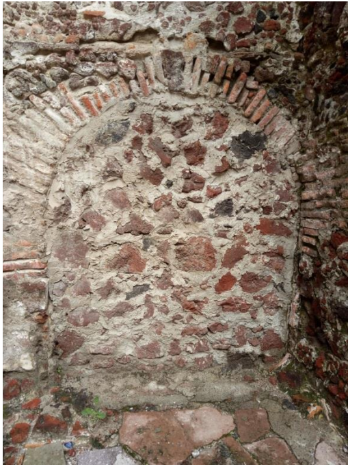
Ilustración 103. Detalle de la traza de un arco inscrito en el muro sur del Templo de San Jerónimo. Foto del autor, agosto 2017.
