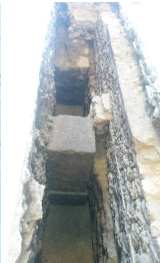
Ilustración 110. Sondeo en S. Ildefonso, 30 donde ha salido una crujía con pilastras cuadradas de sillares de cantera. Fotografía del autor, 2015.
