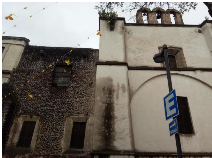
Ilustración 201. Vista del muro testero del Templo de La Concepción. Fotografía del autor, 2016.
