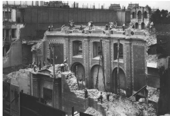
Ilustración 216. Demolición del Templo de Santa Brígida, hacia 1933. Fuente: Tovar, La ciudad de los palacios, Crónica... , p. 147.
