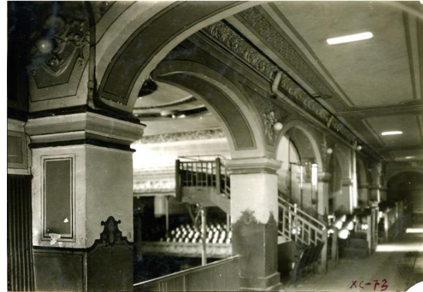
Ilustración 135. Cine "Progreso Mundial". Decoración interior y tubos de instalaciones.
