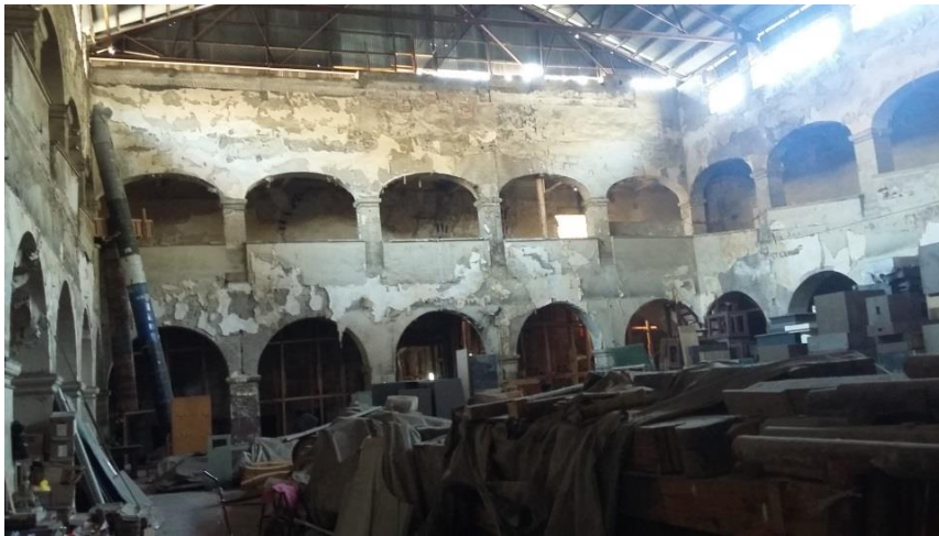
Ilustración 153. Estado actual del claustro del Convento de Jesús María. Fotografía del autor, 2016.
