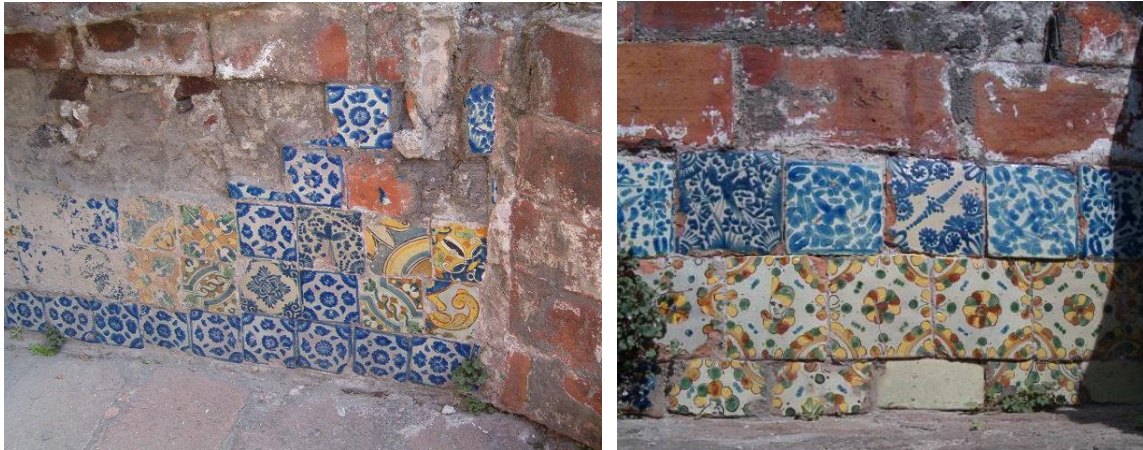
Ilustración 69. Recubrimientos de azulejo en piletas en lo que fuera el Convento de San Jerónimo. Fotografías del autor, 2005.
