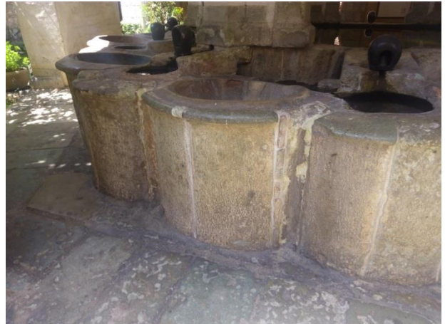
Ilustración 29. Detalle de la pileta y lavaderos del Convento de Santa Catalina de Siena, en Oaxaca. Fotografía del autor, 2016.
