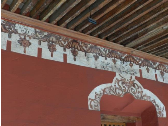
Ilustración 73. Pintura mural en el muro de una dependencia en lo que fuera el Convento de Santa Inés, con la inscripción "SE ACABO EN EL AÑO DE 1745".
