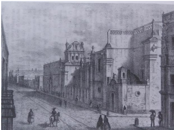
Ilustración 63. Convento de Santa Clara. Campanario a base de espadañas y, en primer plano, remates de muro a base de citarilla. Tovar..., p. 114.
