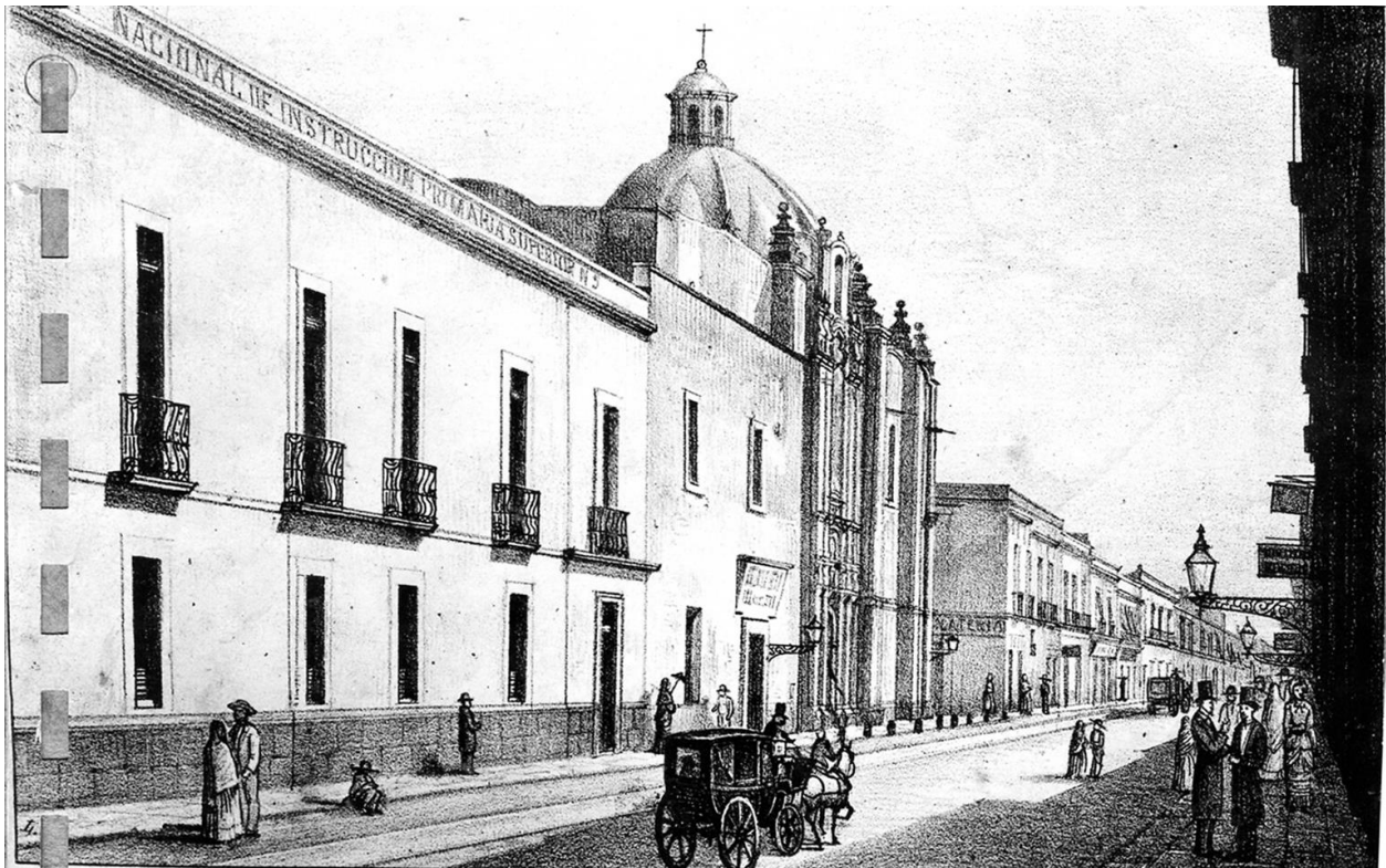
Ilustración 58. Fachada sur del Convento de San Lorenzo recién transformado a escuela. Dibujo. Fuente: Fototeca "Constantino Reyes Valerio", CNMH del INAH (Registro DXC-49).
