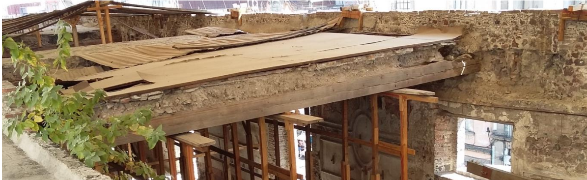
Ilustración 150. Cubierta en la crujía sur del antiguo Convento de Jesús María. Fotografía del autor, 2016.
