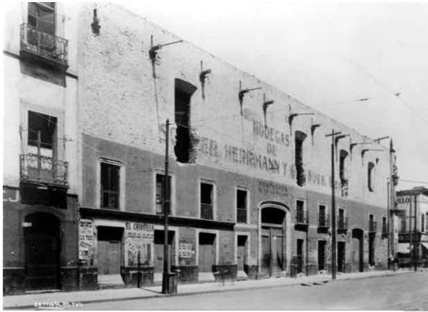
Ilustración 126. Aspecto de la fachada sur del Convento de Jesús María de la década de los años 20 del siglo pasado.
