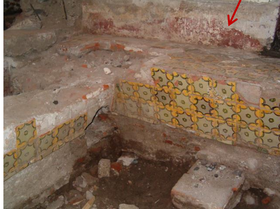
Ilustración 72. Rodapié de muro sobre banqueta, en lo que fuera el Convento de San José. Fotografía del autor, 2015.
