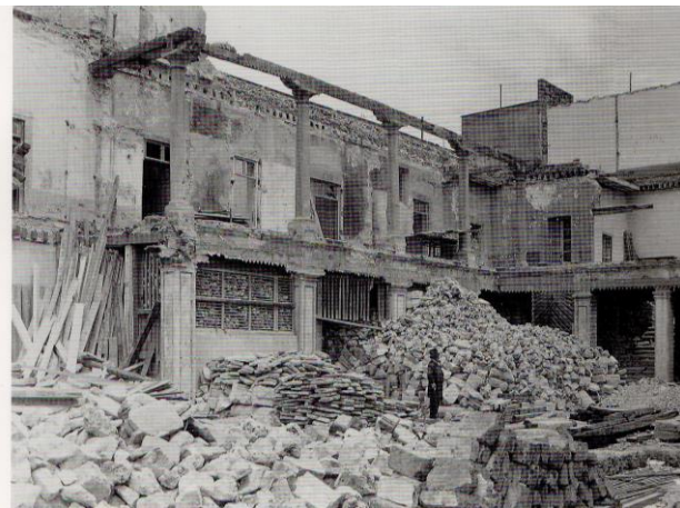
Ilustración 217. Demolición de lo que fuera el claustro del Convento de Balvanera en los años treinta. Fuente: Guillermo Tovar..., p. 100..
