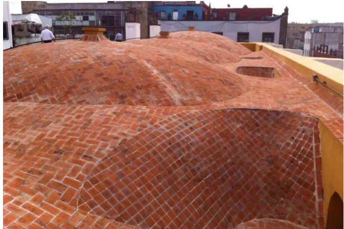
Ilustración 67. Cubierta del Templo de Balvanera, con el ladrillo colocado en 2014. Fotografía del autor, 2016.
