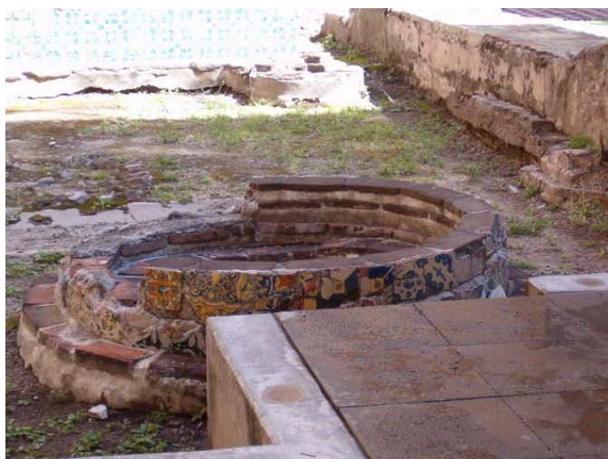
Ilustración 173. Restos de un arriate, con su fábrica de ladrillo y su recubrimiento exterior de azulejos policromos. Fotografía del autor, 2014.
