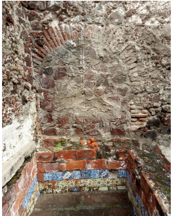
Ilustración 97. Muro sur del Templo de San Jerónimo. Diversidad de unidades estratigráficas. Fotografía del autor, 2017.
