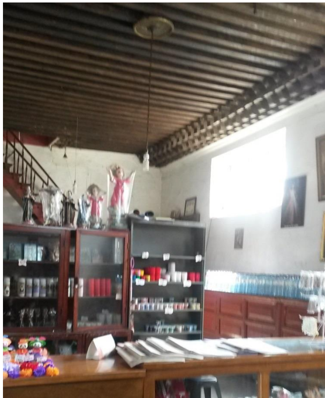
Ilustración 230. Sacristía del Templo de Santa Teresa La Nueva, hoy tienda. Fotografía del autor, 2015.
