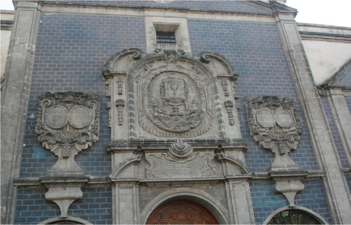
Ilustración 76. Fachada de lo que fuera el Templo del Convento de Corpus Christi, hoy Archivo de Notarías de la Ciudad de México. Fotografía del autor, 2016.
