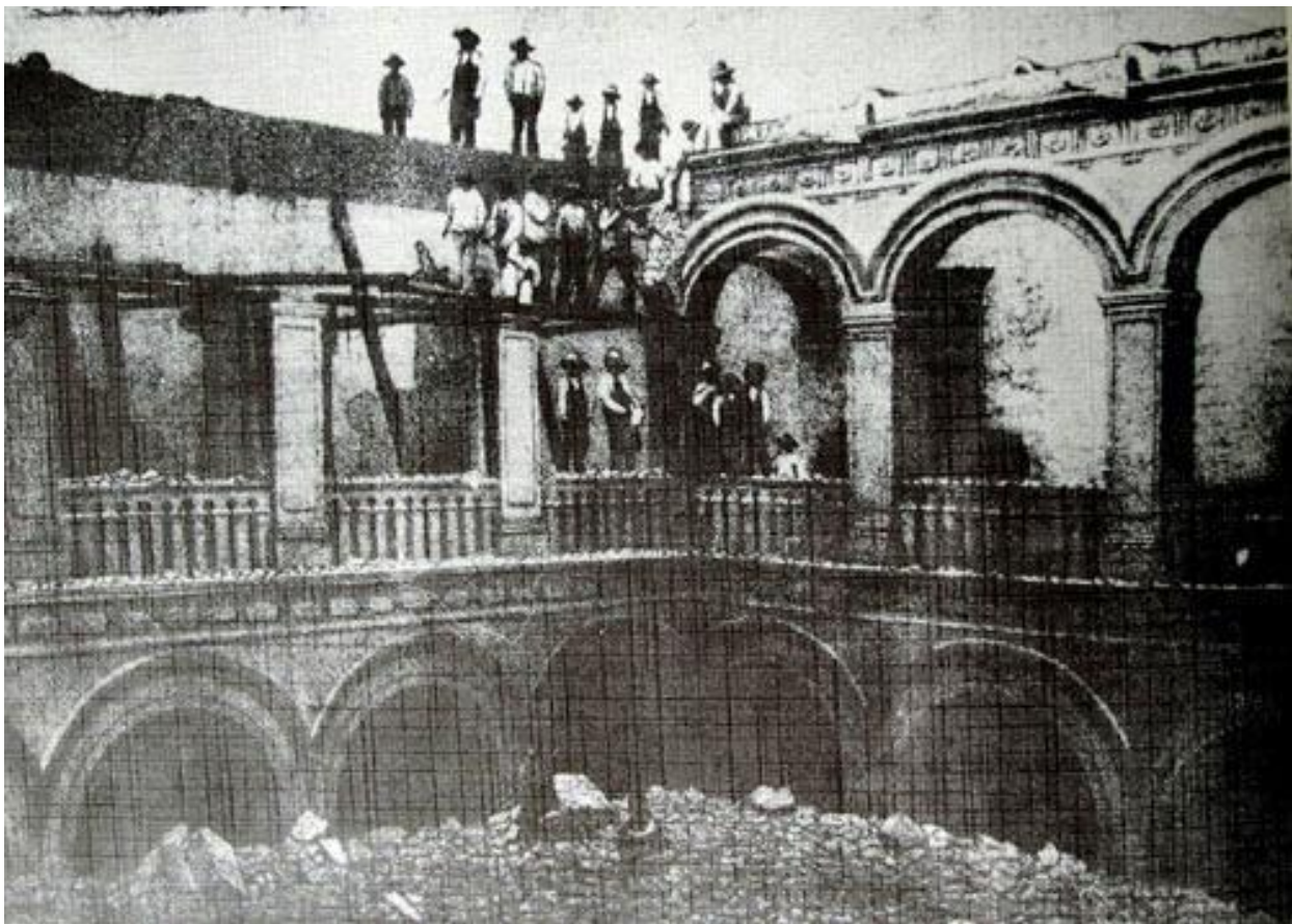
Ilustración 59. Demolición del claustro del Convento de San Lorenzo en 1879. Fuente: Libro de Oro de la ESIME, 1916-1966. Cortesía Ing. Sergio Barrera. Generación 52-55.
