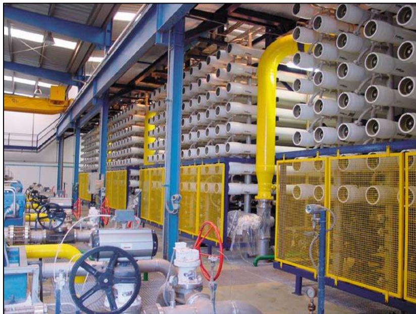
FIGURA 2-9. Interior de una planta desaladora con osmosis inversa.
