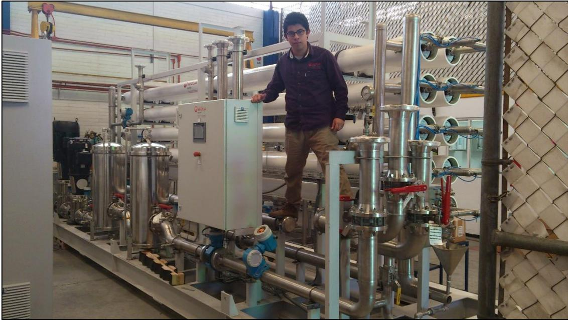
FIGURA 4-13. Ósmosis inversa de acero inoxidable 316 para una aplicación petrolera.
