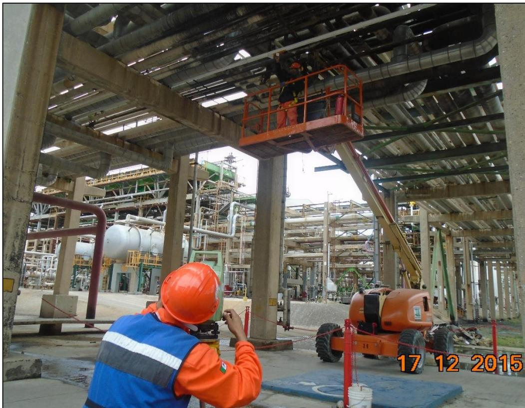
FIGURA 4-10. Ejemplo de toma de coordenadas de racks de tuberías.
