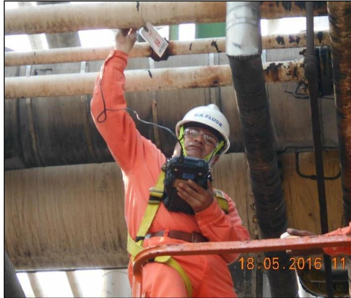
FIGURA 4-11. Toma de espesores de una tubería previamente marcada.
