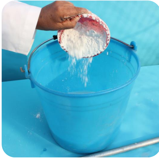
Figura 24. Preparación mezcla de yeso.
