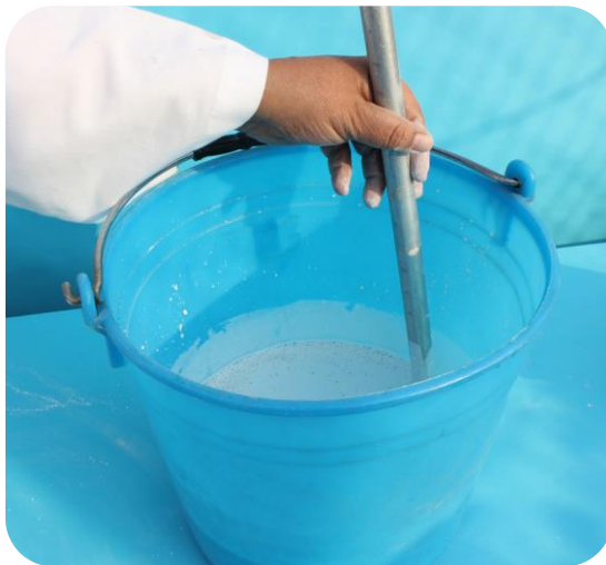
Figura 25. Preparación mezcla de yeso.
