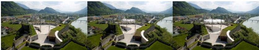
VISTA DE CUBIERTA MÓVIL. APERTURA.
