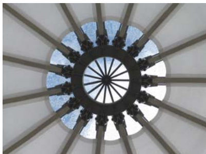
DETALLE. ANILLO DE COMPRESIÓN DE CUBIERTA MÓVIL.
