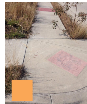
2.-Detalles de rampa en banqueta
