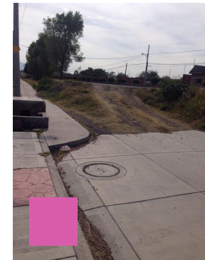
5.-Acceso al terreno de carretera
