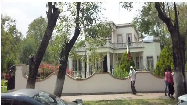
Fachada desde el exterior
