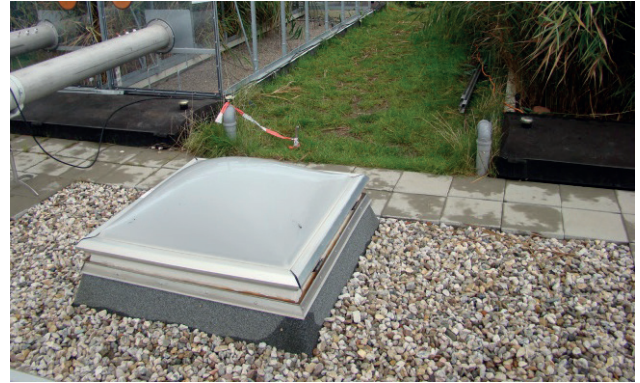
Sistema de domos para capturar luz y filtro para captación de aguas pluviales y futuro almacenamiento para uso de riego.
