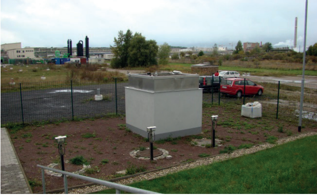
Sistema de almacenamiento.
