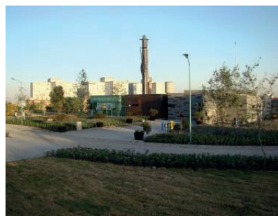
Biblioteca y camino perimetral
