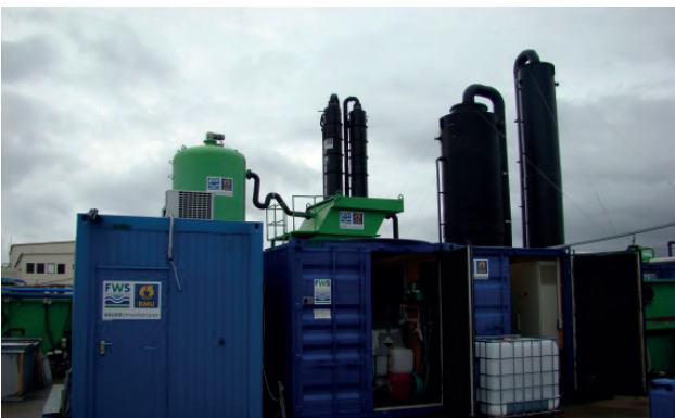
Contenedores y torres correspondientes al Sistema de carbón activado.
