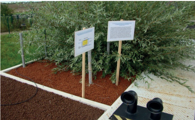
Sistema de ventilación.
