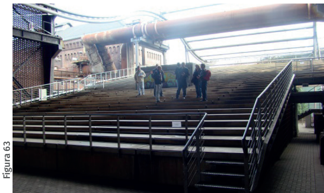
Gradas de auditorio, aprovechan estructura industrial
