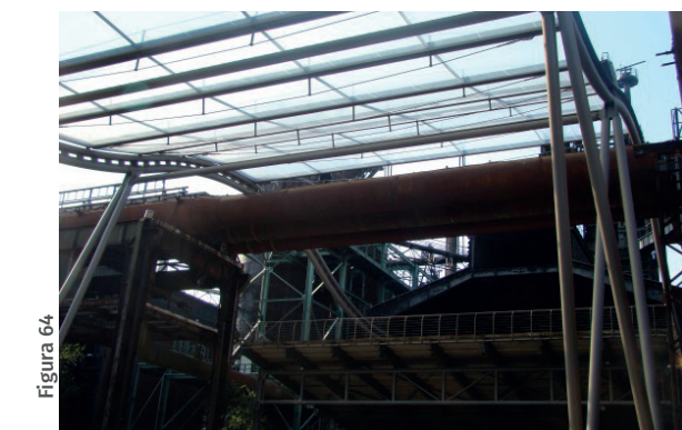
Techo móvil del auditorio, mediante un sistema de automatización para poder desplazarlo, se estructura a manera de un exoesqueleto.
