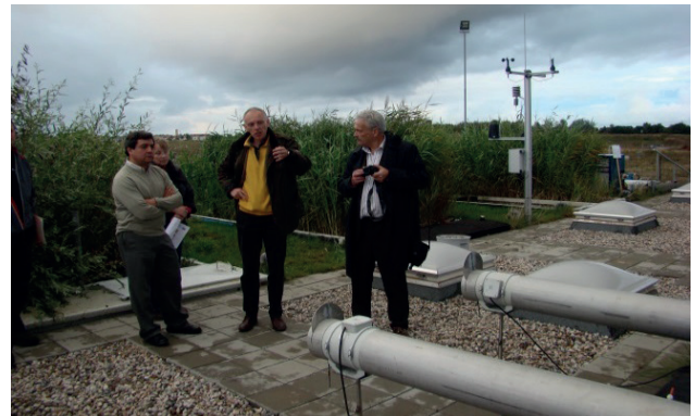
Tubos del sistema de tratamiento de domos para remediación de vapores.
