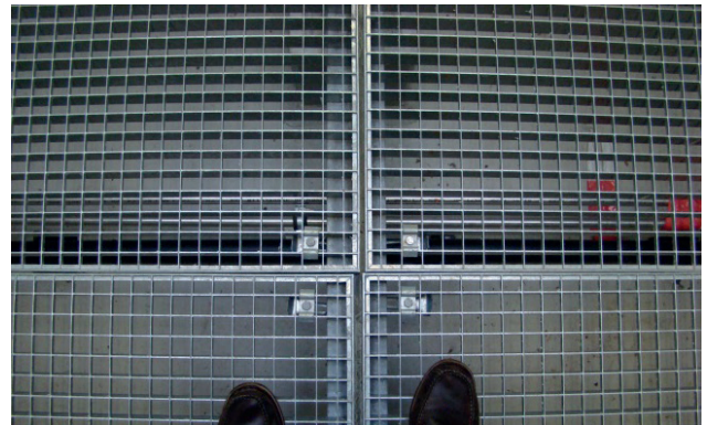
Sistema constructivo elevado mediante rejilla Irving galvanizada, con la finalidad de poder mantener el piso elevado para dejar el paso de infraestructura eléctrica, sanitaria y sistemas para instalaciones de cableado para datos.
