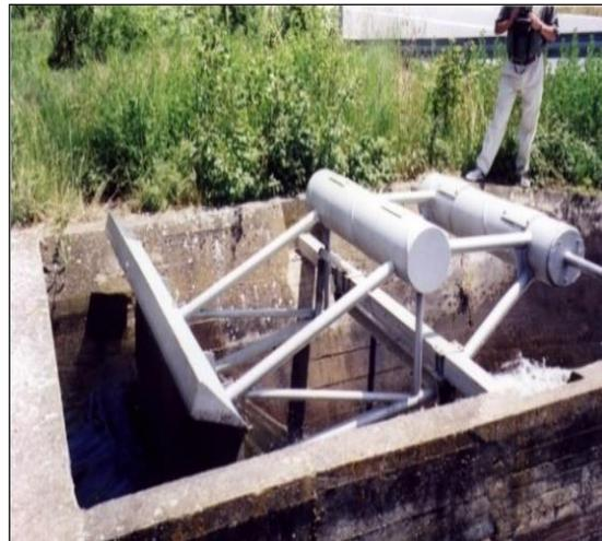
Figura 1. Compuerta autooperante tipo AMIL
