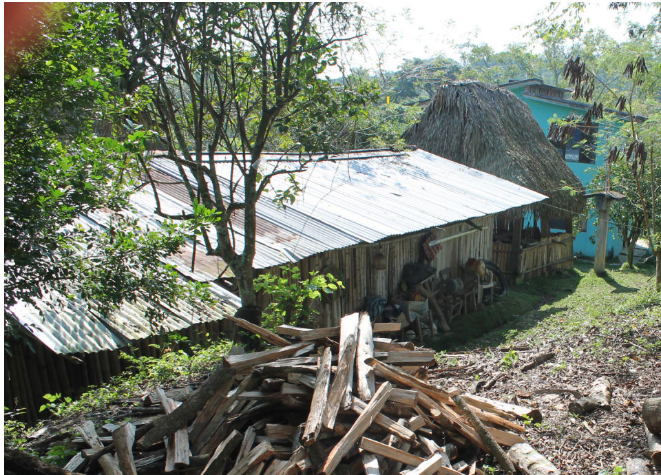
Fotografía 3 Depósito de leña. cuartos con muros de carrizo, techo de lámina a dos aguas. En el fondo construcción de concreto. crédito: Daniel Nahmad Molinari
