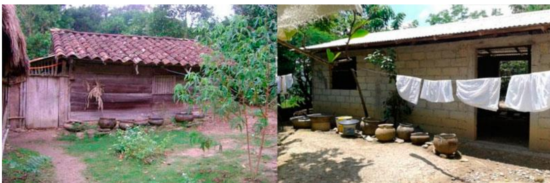
Figura 40: Sistema de ollas para captación de agua de lluvia. Zapotal Santa Cruz y Jorge Serdán. Fotografías: Jesús Trejo y Alejandrino García.
