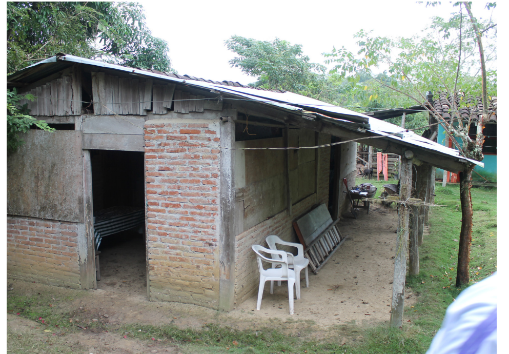
Fotografía 4 Altar. Construcción de ladrillo rojo recocido, techo de lámina con estructura de madera a dos aguas. crédito: Daniel Nahmad Molinari
