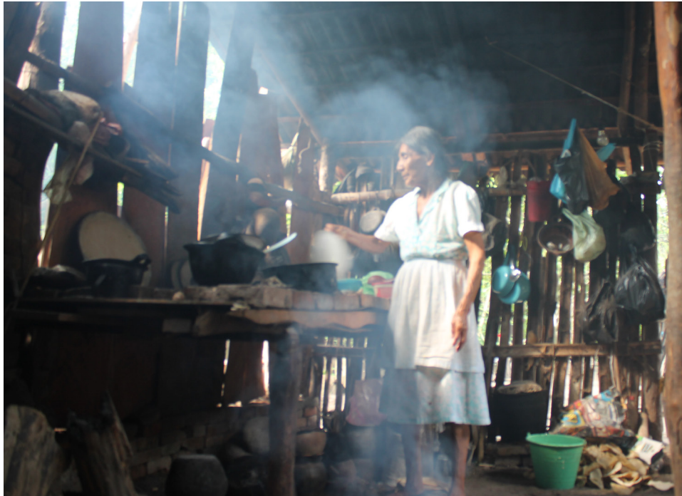
Fotografía 1 Cocina. Muro de carrizo, estructura de madera, techo de lámina a dos aguas.
