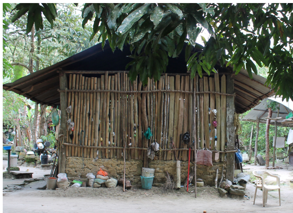
Fotografía 1 Cocina. Muro bajo de bajareque, carrizo y bejuoco, estructura de madera, techo de lámina a dos aguas. crédito: Daniel Nahmad Molinari
