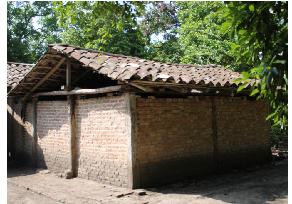
Fotografía 3 Cuarto. Muros de ladrillo rojo recocido, techo de teja a dos aguas.
