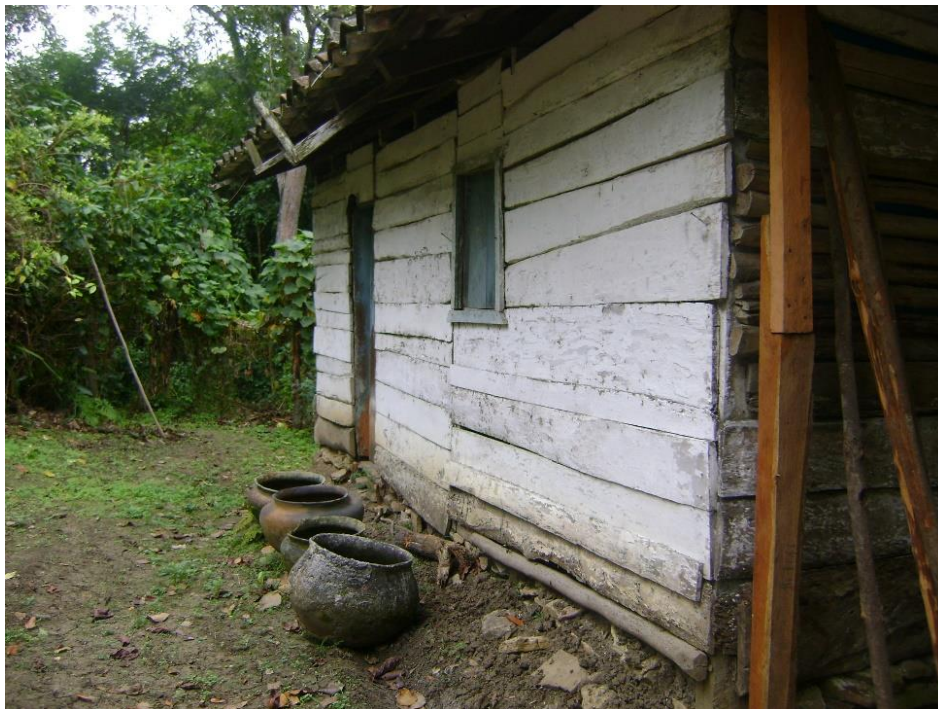
Figura 12: Casa de madera y teja de doña Isabel Villanueva, Zapotal Santa Cruz. Se observa el sistema de recolección de agua por goteo. Fotografía: Jesús Trejo
