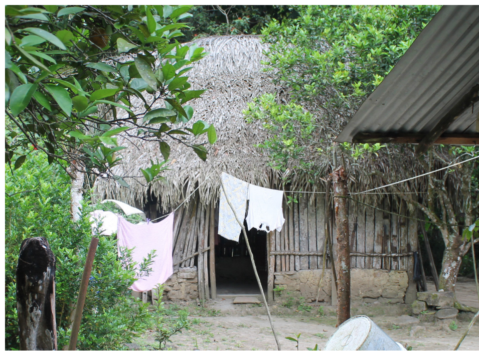
Fotografía 2 Cuarto. Muro bajo de bajareque y carrizo, estructura de madera, techo de palma a cuatro aguas. crédito: Daniel Nahmad Molinari
