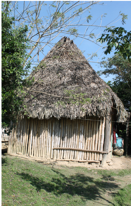
Fotografía 1 y 2 Cocina. Muros de carrizo y bejuco, techo de palma a cuatro aguas, estructura de madera. Doña Teodora en altar.
