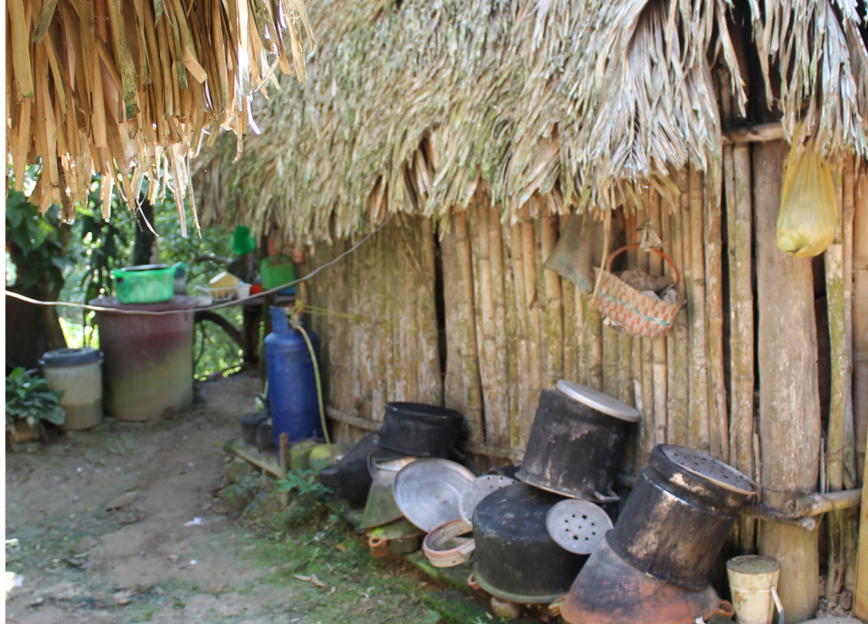
Fotografía 6 Cocina. Muros carrizo, techo de palma a cuatro aguas. crédito: Daniel Nahmad Molinari
