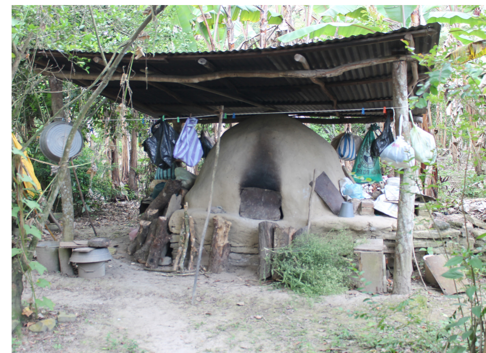
Fotografía 3 Horno. Estructura de madera en cubierta, techo de lámina. crédito: Daniel Nahmad Molinari
