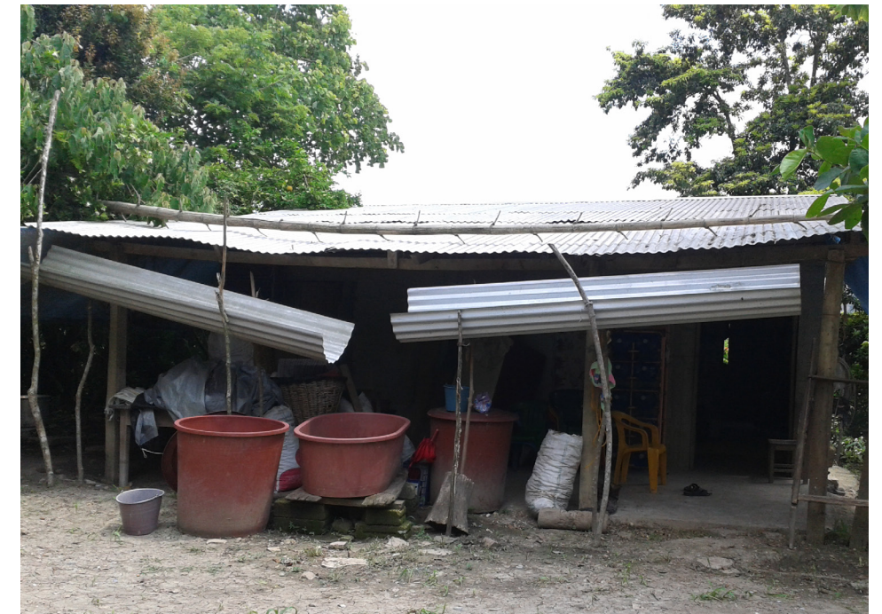
Fotografía 3 Cuartos, lámina para recolección de agua pluvial. crédito: Daniel Nahmad Molinari
