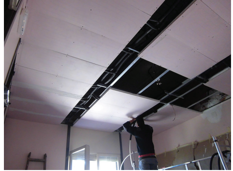
Figura 2.14. Tecnoinstalaciones, s.f., techo radiante
