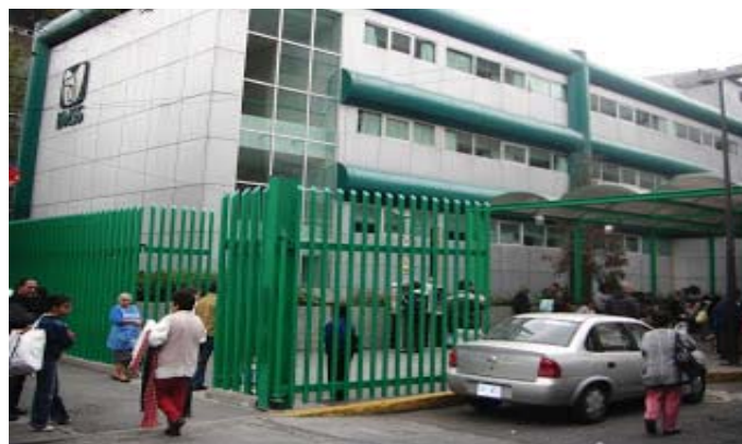
Foto 19. IMSS Hospital General de Zona 27
