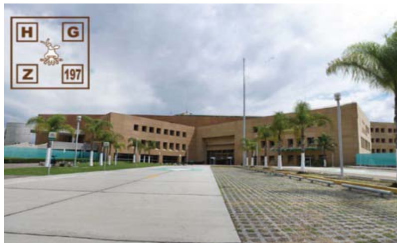
Foto 17. Hospital General de Zona 197
