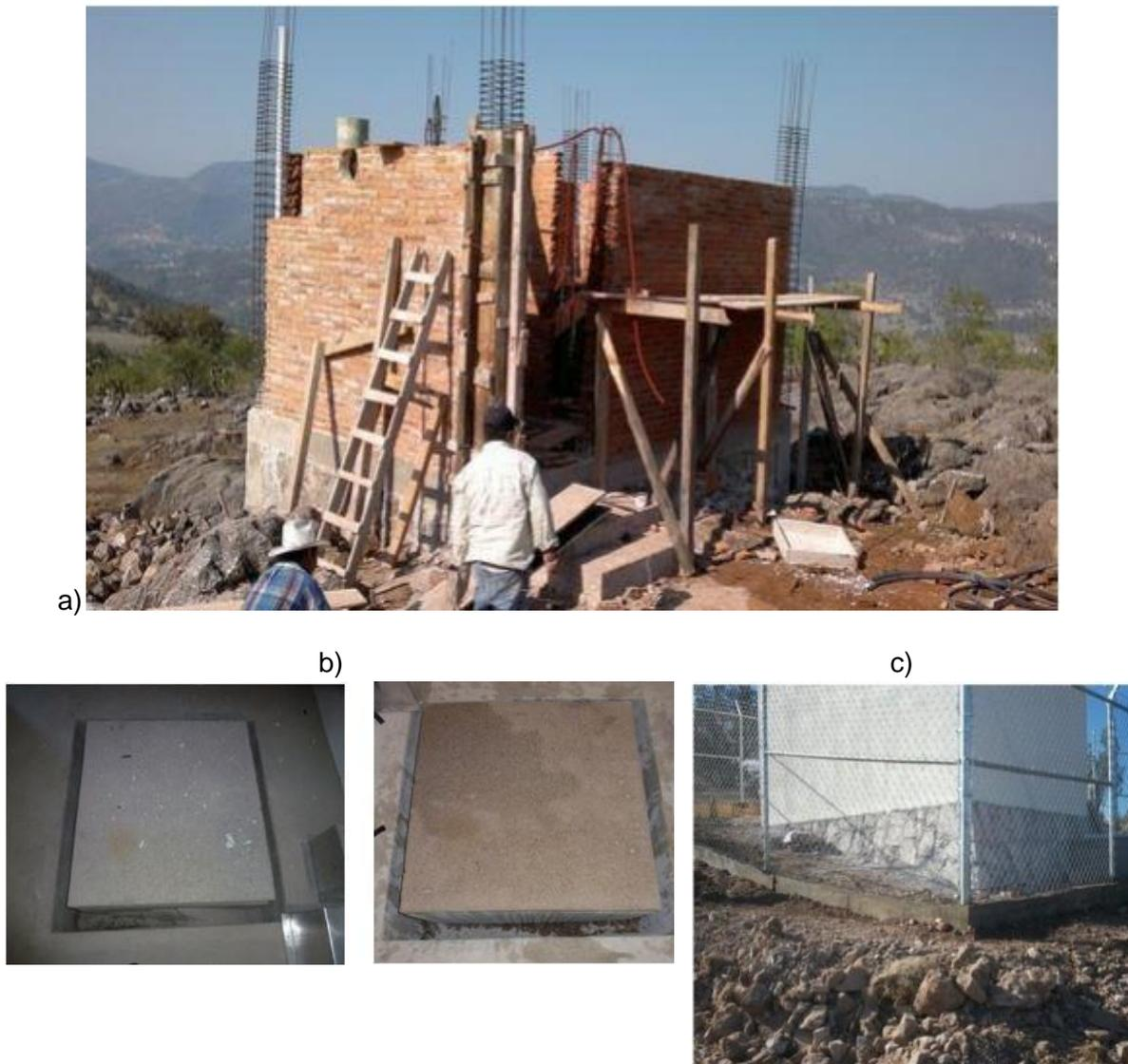
**Fig. 3.4** a) Construcción de los muros de una estación sísmológica.
