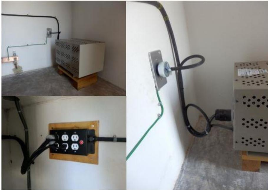
**Fig. 3.6** Conexión del regulador y de la caja de distribución. Proporcionada por F. Navarro.
