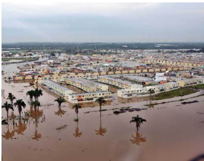
FIGURA 5.- Fraccionamiento Puente Moreno bajo el agua.
