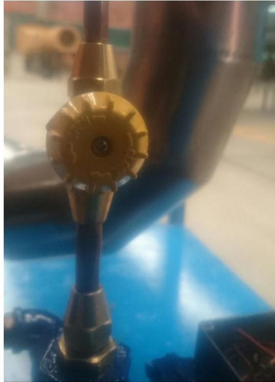
Imagen 9.30 Válvula tipo aguja instalada en la salida de la bomba.
