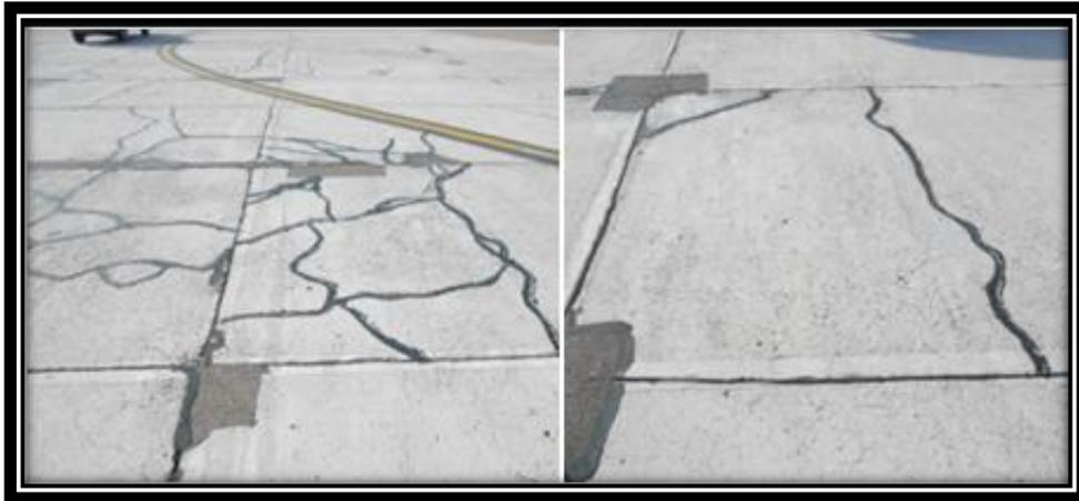
Imagen 14 Grietas de esquina y longitudinales en calles de rodaje
