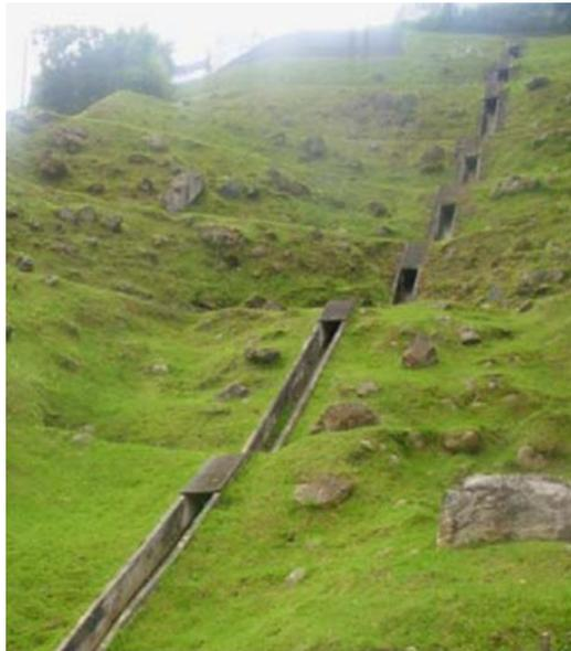
**Fotograf a 2. Canal de r pidas con tapa y columpio CRTC
