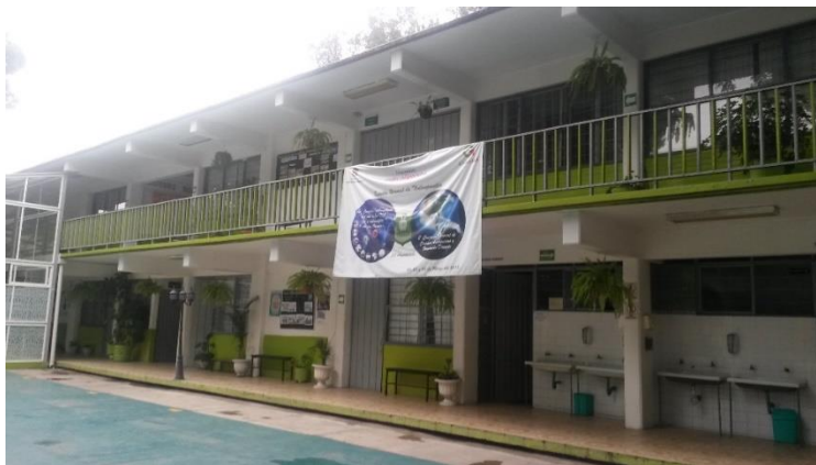
Vista del Edificio “A”. Aulas principales de Licenciatura
