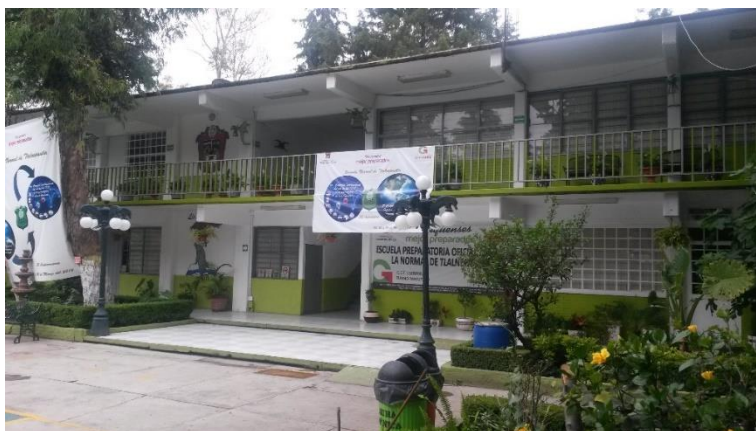
Vista del edificio "C". Auditorio, sala telemática y dirección de Preparatoria
