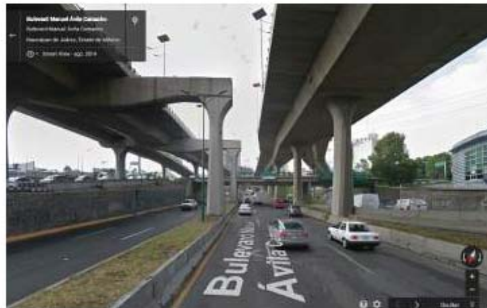
Bulevard Manuel Ávila Camacho (anillo periférico) Toma de Street View, Google maps.
