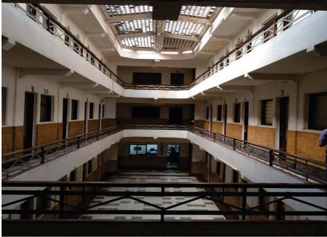
IMAGEN 18. Edificio antes de la intervención que se realizó.
