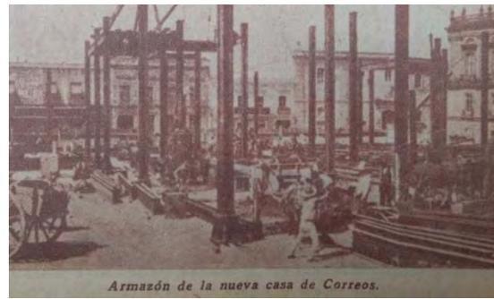
ESTRUCTURA METÁLICA UTILIZADA EN EL CORREO MAYOR, 1900
