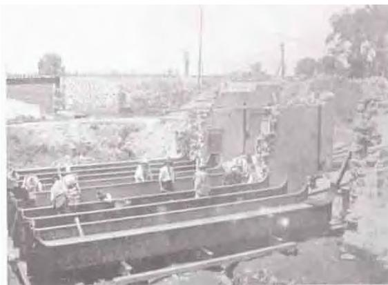
Obras en el Rio de la Piedad. Parte metálica del Sifón.
