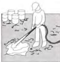
**Colocación final del impermeabilizante a base de emulsión asfáltica en frío, en el suelocimiento. Aplicación mecánica de hidrofugante en los muros perimetrales de la cimentación así como en los dados y la losa de cimentación.**
