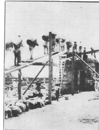
CONDUCCIÓN DE FABRICAS LLENAS DE CEMENTO PARA LA PRUEBA DE RESISTENCIA AL PESO DE 14,000 KILOGRAMOS.
