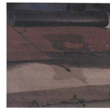
EJEMPLO DE IMPERMEABILIZANTE DE MEMBRANA
