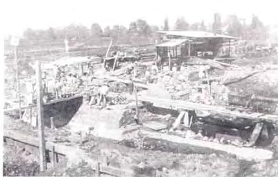
Obras en el Rio de la Piedad. Construcción de la embocadura del Sifón.
