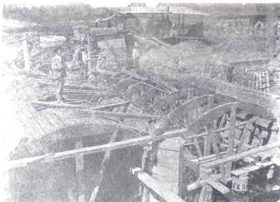
Obras en el Rio de la Piedad. Construcción del puente en la Calzada de Ixtacalco. al estarse armando el Sifón.
