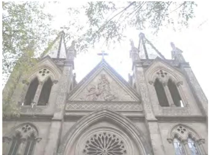
Con la culminación de las torres se incrementó el peso del Templo y se inició su proceso de deterioro, debido al peso de los campanarios, iniciando un proceso de hundimiento. La fecha marcada en las campanas es marzo de 1944.
