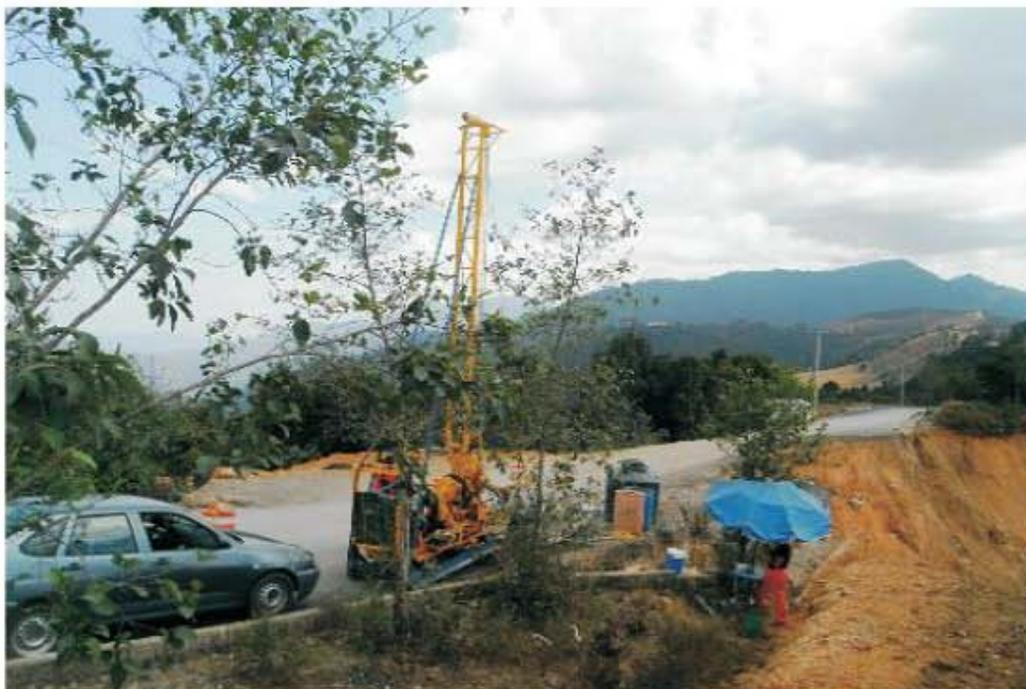
Foto 5. Sondeo de Exploración Geotécnica (SEG-01)
