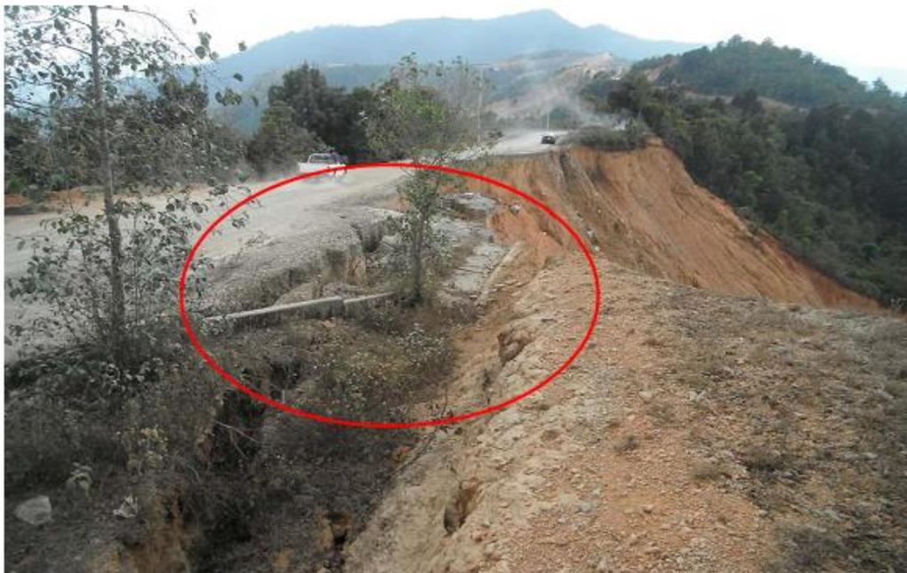
Ilustración 14. Cuneta destruida existente del lado derecho de la vialidad
