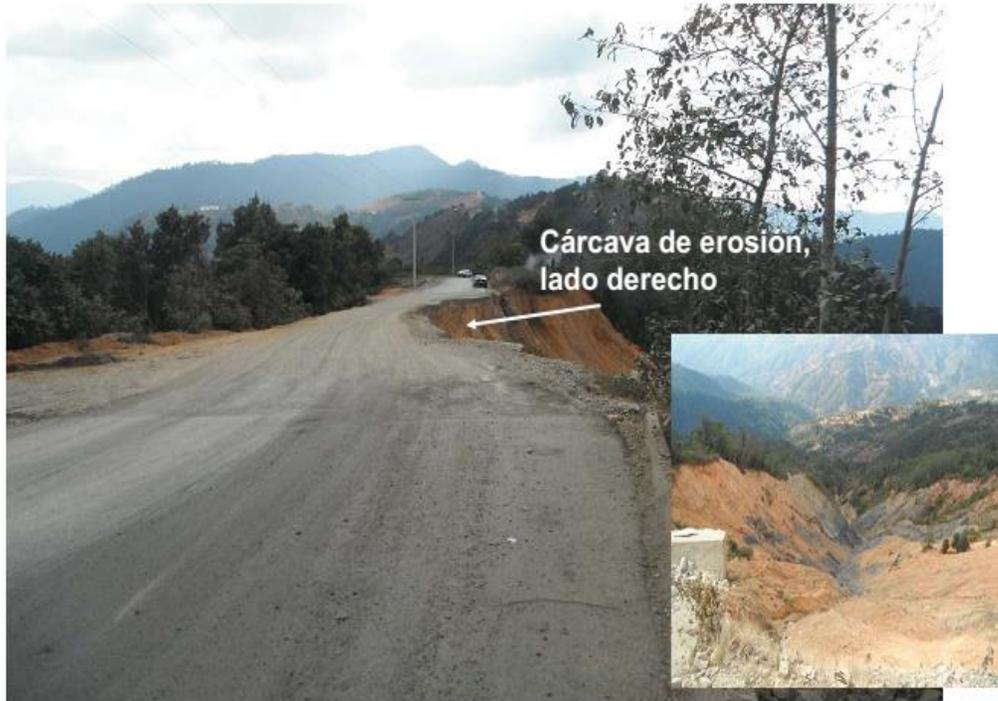
Ilustración 13. Cárcava de erosión del lado derecho de la vialidad
