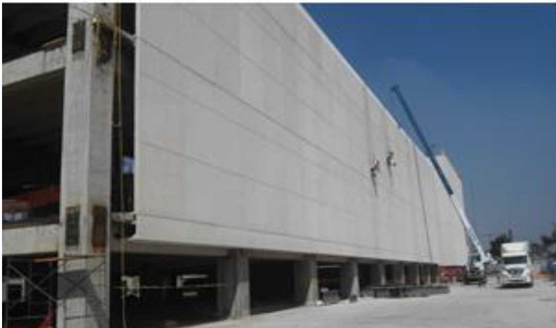
FOTOGRAFIA 86: MONTAJE DE LA FACHADA, CENTRO COMERCIAL VIA VALLEJO.
