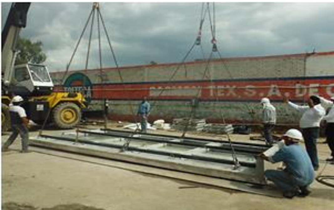
FOTOGRAFIA 67: DESMOLDE DE LA PIEZA, FACHADA ARCHIVO GENERAL DE LA NACION.
