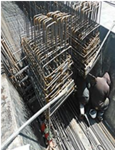
FOTOGRAFIA 56: ARMADO TRANSVERSAL
