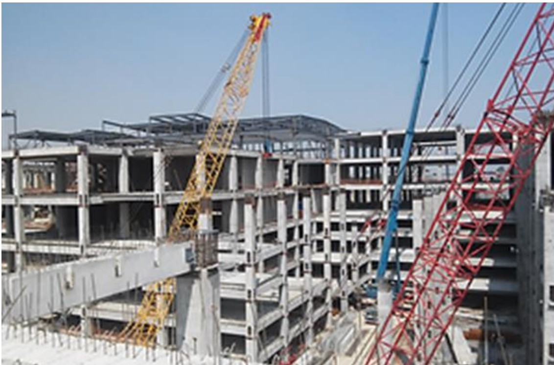
FOTOGRAFIA 1: MONTAJE DE ELEMENTOS PREFABRICADOS.
