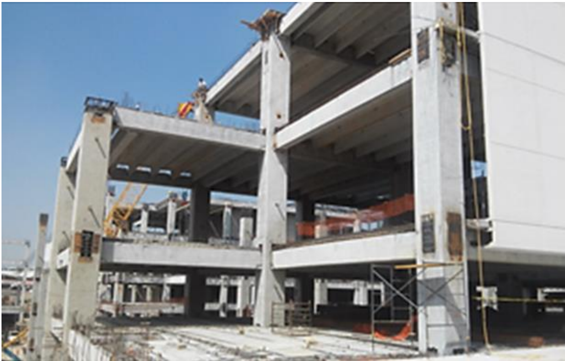
FOTOGRAFIA 1: MONTAJE DE ELEMENTOS PREFABRICADOS.
