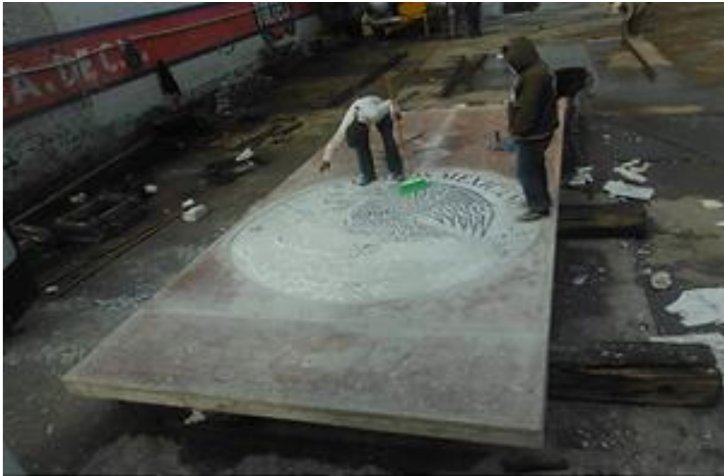
FOTOGRAFIA 72: PULIDO DE LA PIEZA, FACHADA ARCHIVO GENERAL DE LA NACION.
