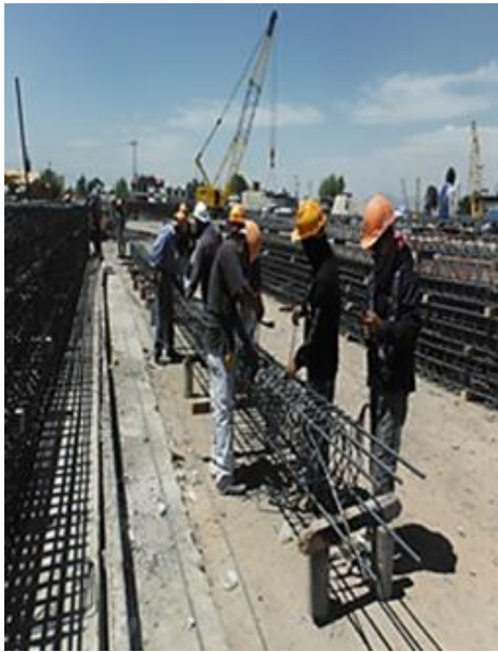
FOTOGRAFIA 38: AVANCE DEL ARMADO DE LOS PILOTES.
