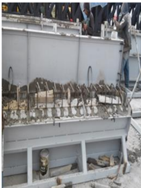
FOTOGRAFIA 30: TERMINACION DE COLADO DE PARAPETOS.
