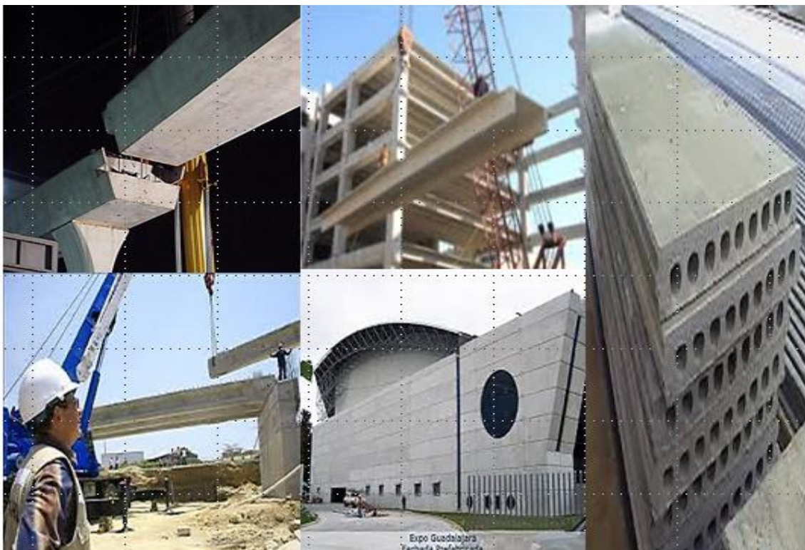
IMAGEN 7: DEMOSTRACION DE LA VELOCIDAD EN OBRA DEL PROCESO DE LA PREFABRICACION.
