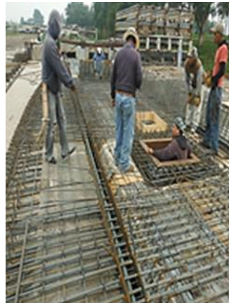
FOTOGRAFIA 57: AVANCE DE ARMADO.
