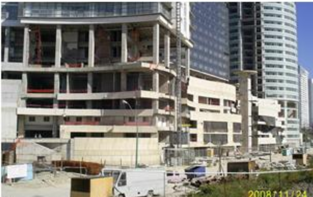
FOTOGRAFIA 79: MONTAJE DE LA FACHADA, COMPLEJO CITY SANTA FE.
