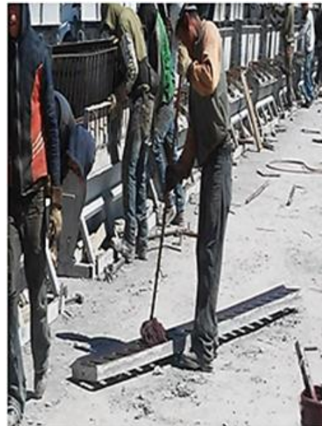
FOTOGRAFIA 19: ENGRASADO DE CIMBRA PARA PARAPETOS.
