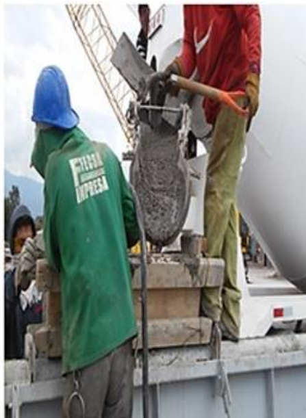
FOTOGRAFIA 28: COLADO DE PARAPETOS.
