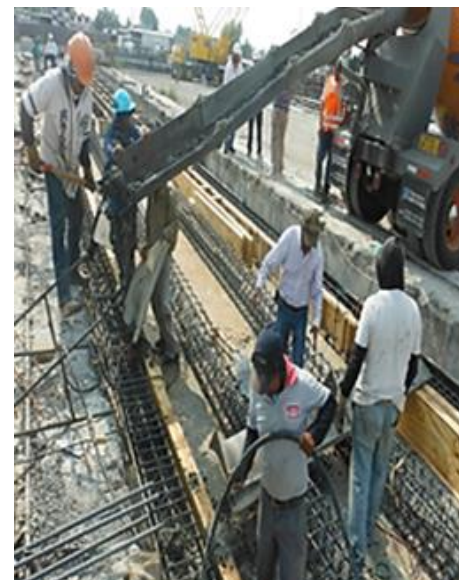
FOTOGRAFIA 49: COLADO Y VIBRADO DE PILOTES.
