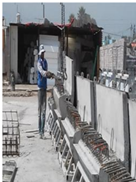
FOTOGRAFIA 31: DECIMBRADO DE PARAPETOS.
