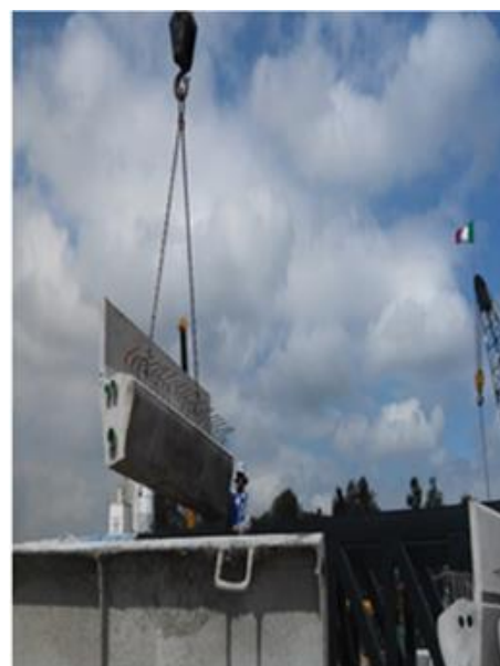
FOTOGRAFIA 33: DECIMBRADO DE PARAPETOS.
