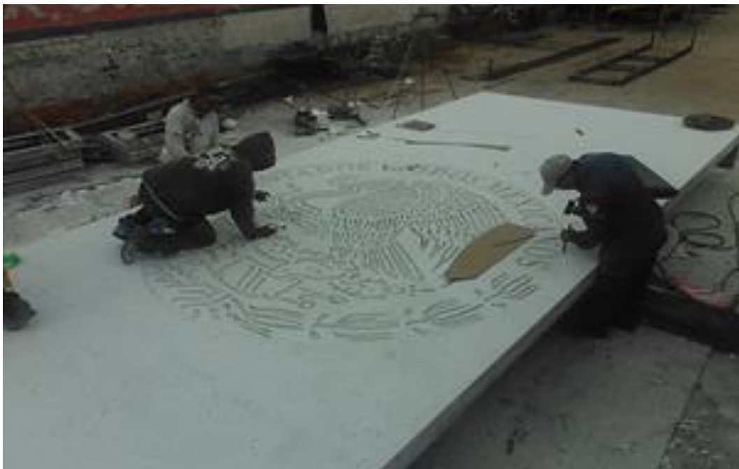
FOTOGRAFIA 73: PULIDO DE LA PIEZA, FACHADA ARCHIVO GENERAL DE LA NACION.
