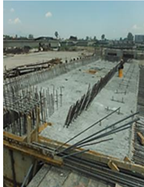
FOTOGRAFIA 63: FRAGUADO DE LA PIEZA DE TRABES DE DISTRIBUCION.
