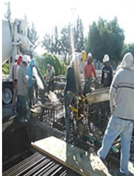
FOTOGRAFIA 61: COLADO DE TRABES DE DISTRIBUCION.
