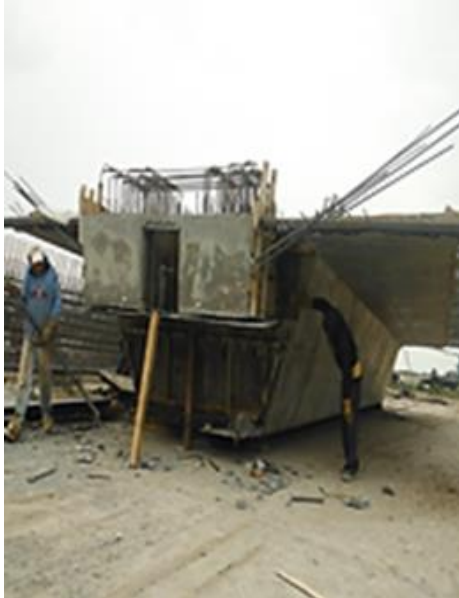
FOTOGRAFIA 62 COLADO DE LAS TRABES DE DISTRIBUCION.
