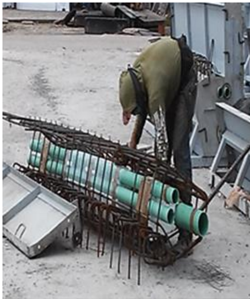
FOTOGRAFIA 22: COLOCACION DE ALIGERANTE EN EL PARAPETO
