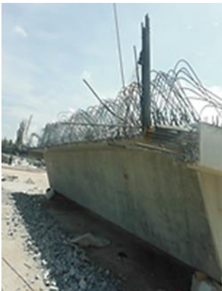
FOTOGRAFIA 64: TRABES DE DISTRIBUCION TERMINADA.
