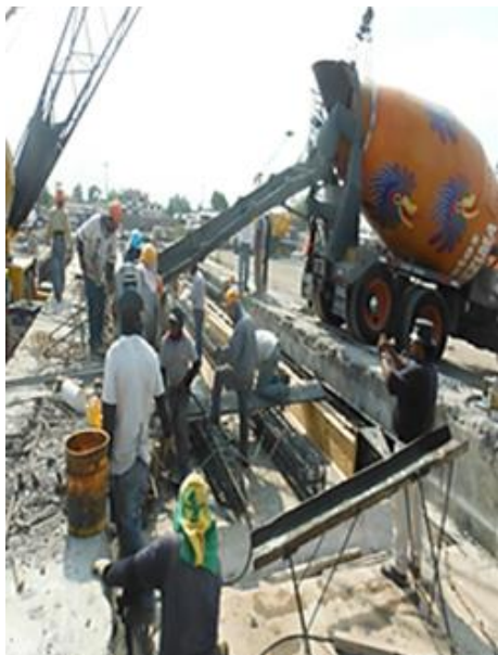
FOTOGRAFIA 48: COLADO DE PILOTES.
