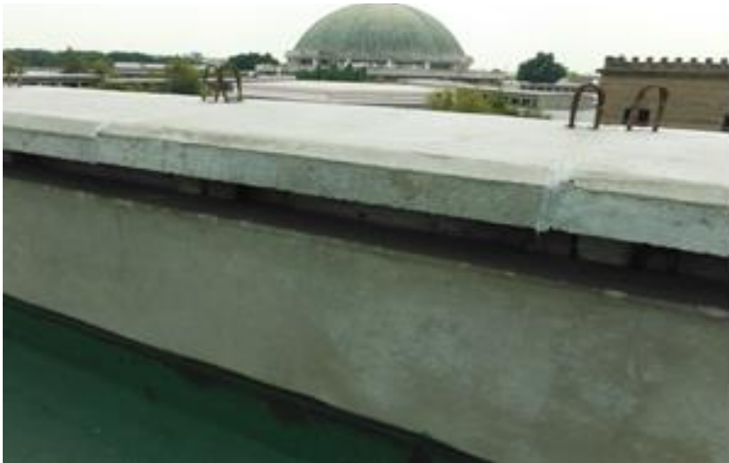
FOTOGRAFIA 75: ACCESORIOS DE LAS PIEZAS, FACHADA ARCHIVO GENERAL DE LA NACION.
