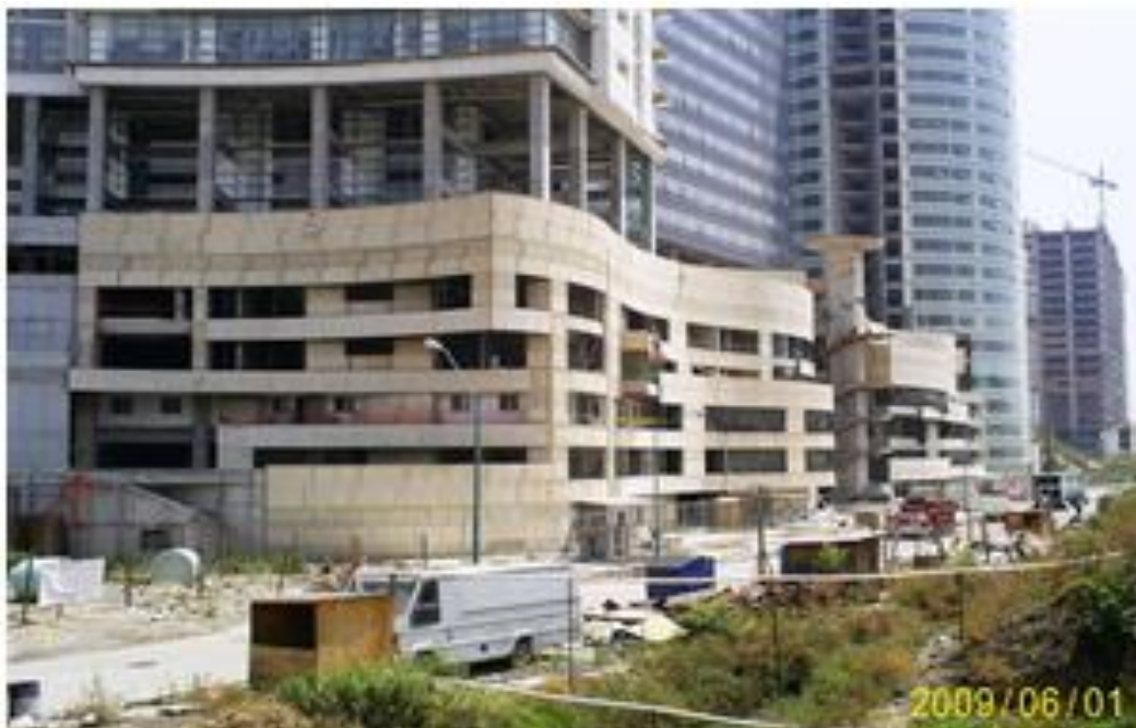
FOTOGRAFIA 80: MONTAJE DE LA FACHADA, COMPLEJO CITY SANTA FE.
