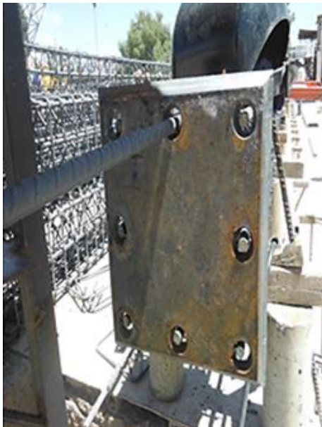
FOTOGRAFIA 40: COLOCACION DE PLACA DE ACCESORIO DE PILOTES.
