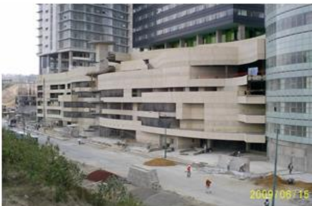
FOTOGRAFIA 81: MONTAJE DE LA FACHADA, COMPLEJO CITY SANTA FE.
