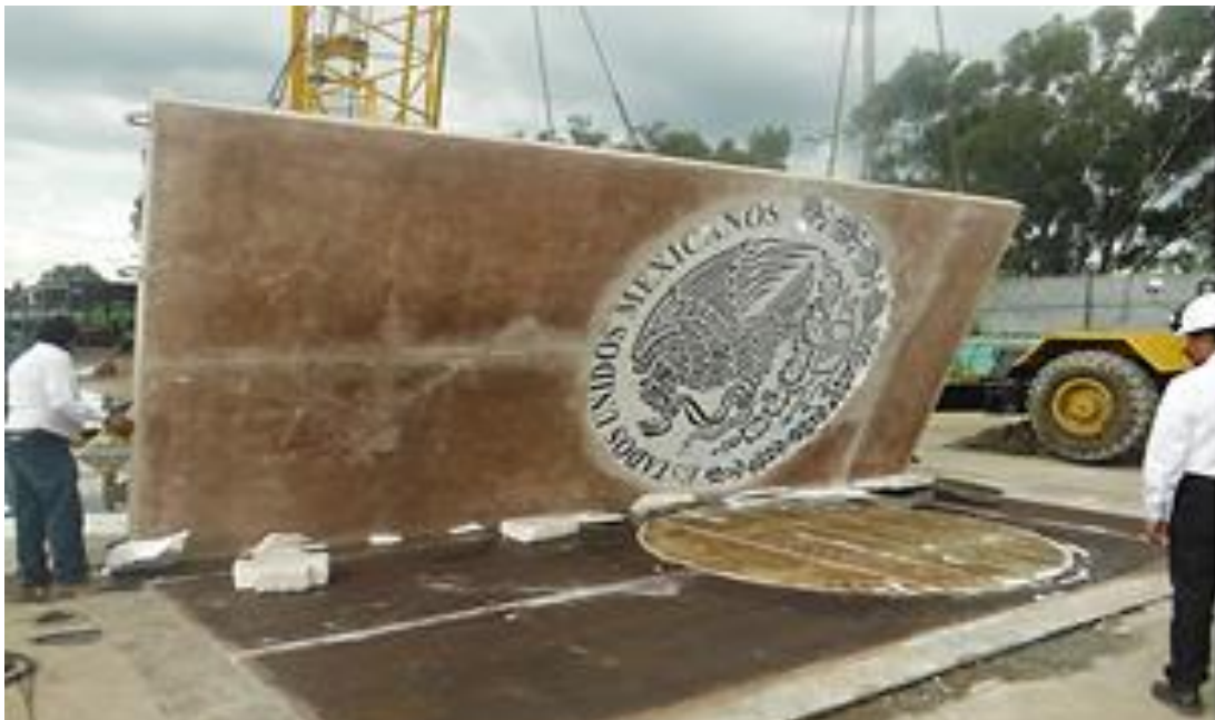
FOTOGRAFIA 69: DESMOLDE DE LA PIEZA, FACHADA ARCHIVO GENERAL DE LA NACION.
