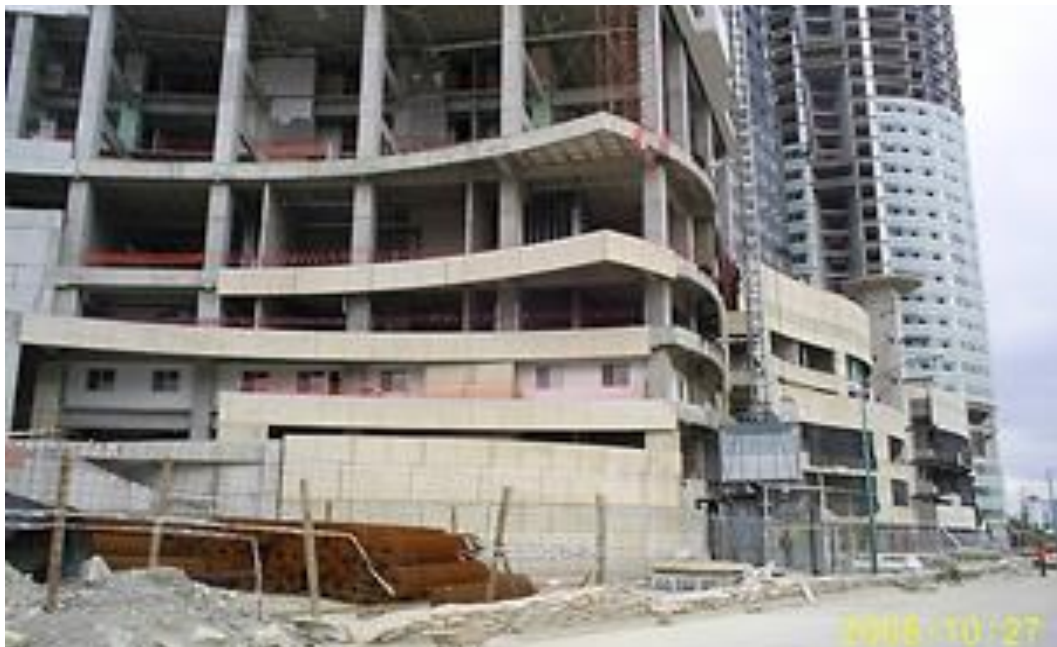
FOTOGRAFIA 77: MONTAJE DE LA FACHADA, COMPLEJO CITY SANTA FE.
