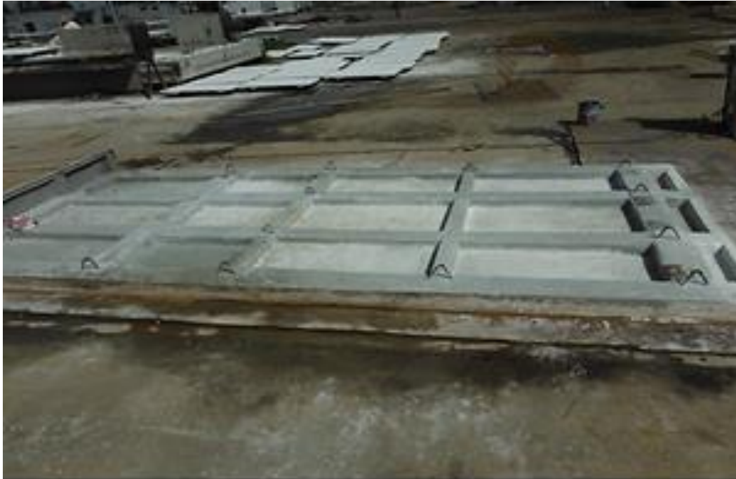
FOTOGRAFIA 70: ACCESORIO DE LA PIEZA, FACHADA ARCHIVO GENERAL DE LA NACION.
