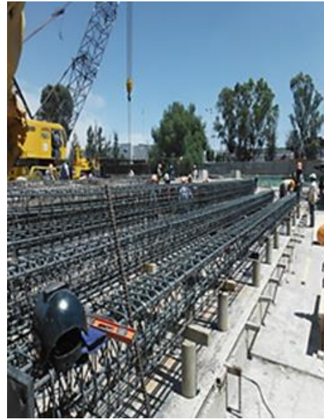
FOTOGRAFIA 39: TERMINADO DE ARMADO DE LOS PILOTES.
