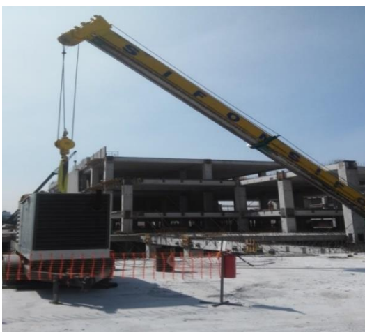
FOTOGRAFIA 84: MANIPULACION DE LOS ELEMENTOS PREFABRICADOS, CENTRO COMERCIAL VIA VALLEJO
