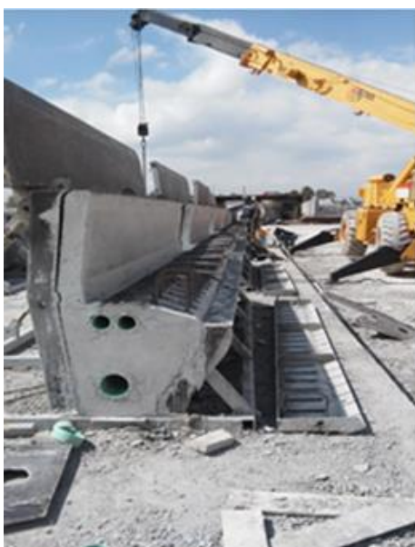
FOTOGRAFIA 32: DECIMBRADO DE PARAPETOS.
