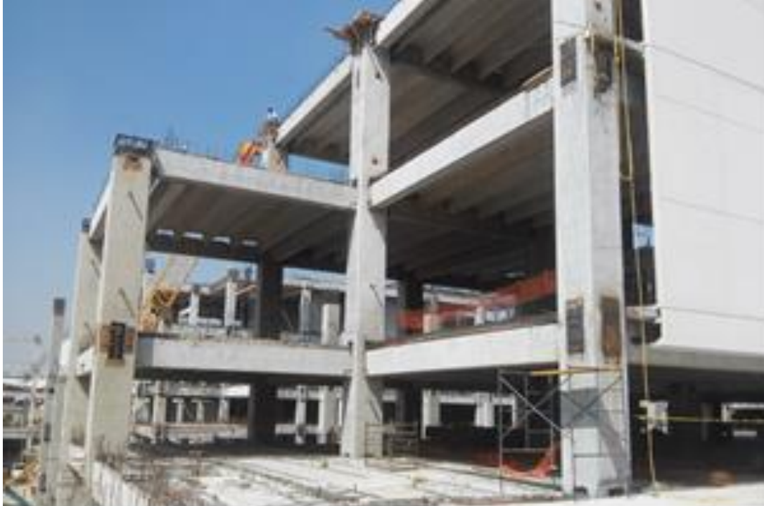
FOTOGRAFIA 85: MONTAJE DE LA FACHADA, CENTRO COMERCIAL VIA VALLEJO.
