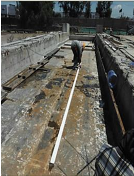
FOTOGRAFIA 34: TRAZO Y NIVELADO DE MOLDE DE LOS
