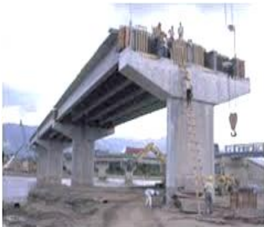
FOTOGRAFIA 17: TRABES TRONCALES MONTAJE
