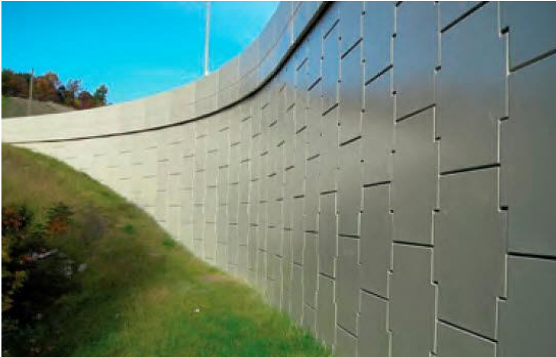
IMAGEN 20: MURO DE CONTENCIÓN DE CONCRETO MODULAR.
