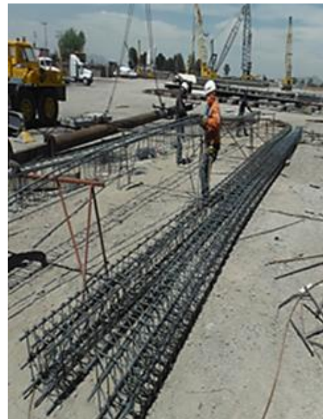
FOTOGRAFIA 37: ELABORACION DE ARMADO DE LOS PILOTE.
