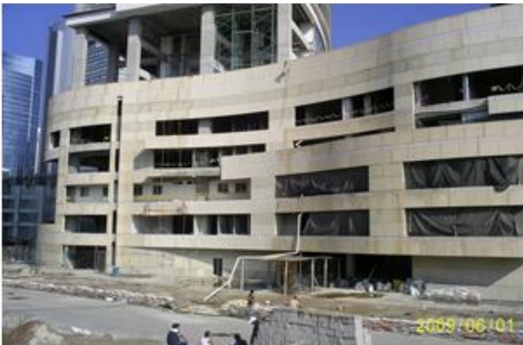
FOTOGRAFIA 83: MONTAJE DE LA FACHADA, COMPLEJO CITY SANTA FE.
