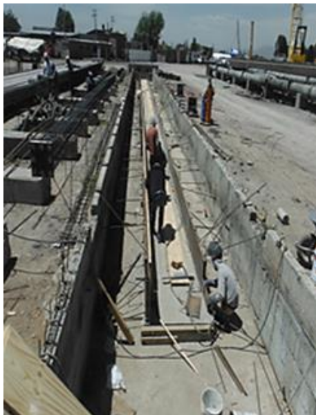
FOTOGRAFIA 36: ELABORACION DE MOLDE DE LOS PILOTE.
