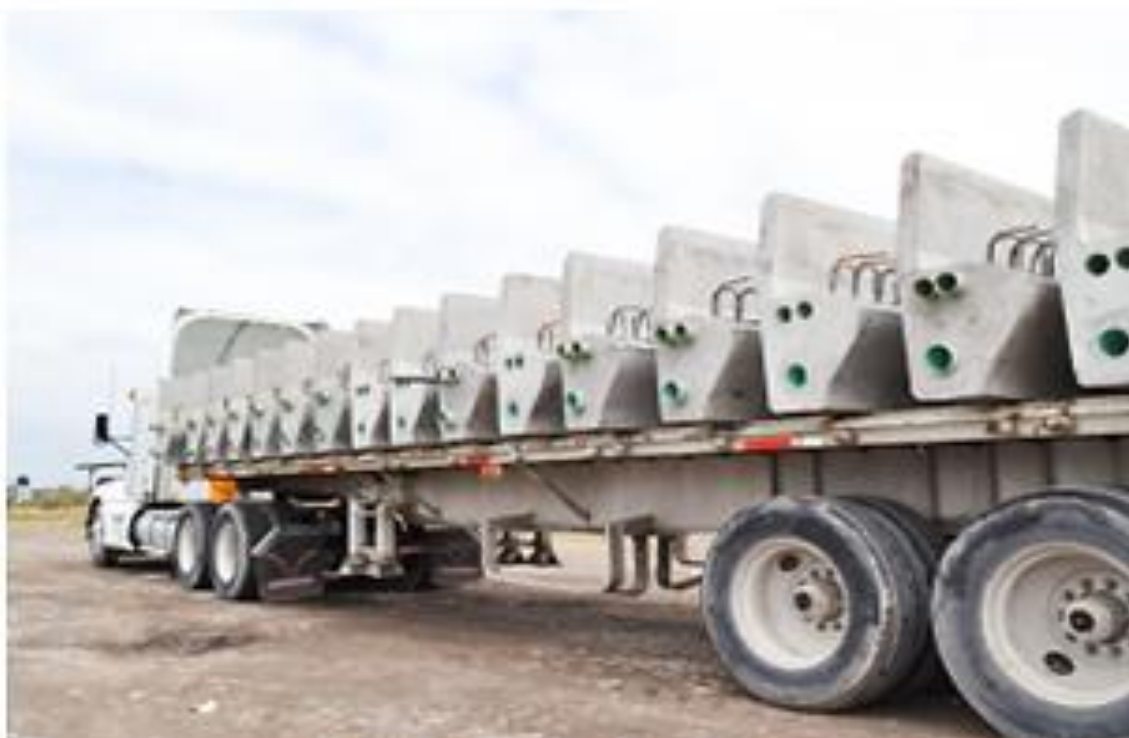
FOTOGRAFIA 11: GRUA DE TRANSPORTE.
