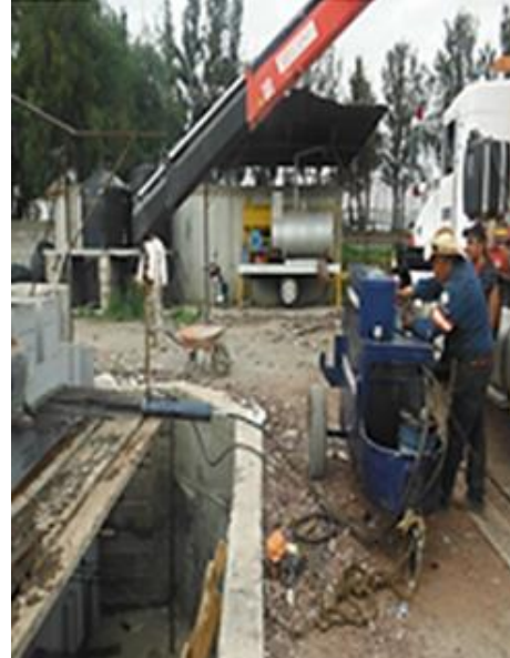
FOTOGRAFIA 59: TENSADO DE TORONES.
