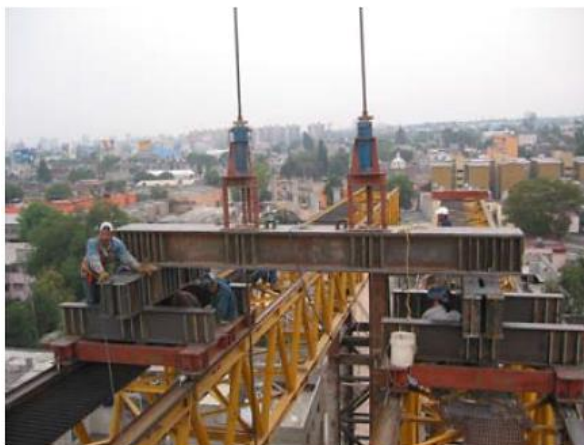
FOTOGRAFIA 15: MONTAJE DE VIGAS.
