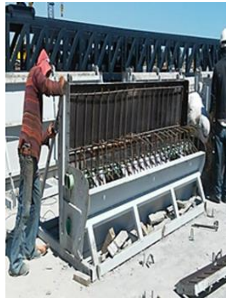
FOTOGRAFIA 23: ACOMODO DE ARMADO EN LA CIMBRA EN EL PARAPETO
