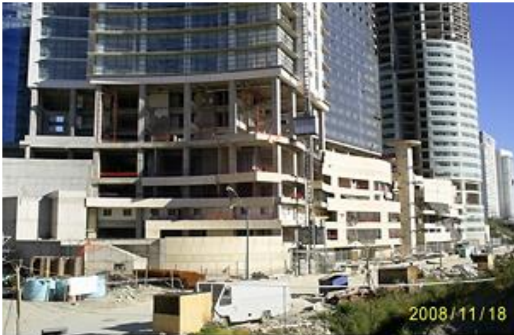
FOTOGRAFIA 76: MONTAJE DE LA FACHADA, COMPLEJO CITY SANTA FE.
