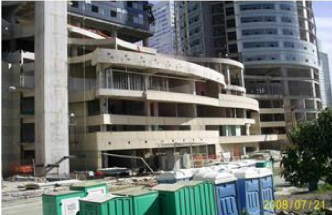
FOTOGRAFIA 78: MONTAJE DE LA FACHADA, COMPLEJO CITY SANTA FE.
