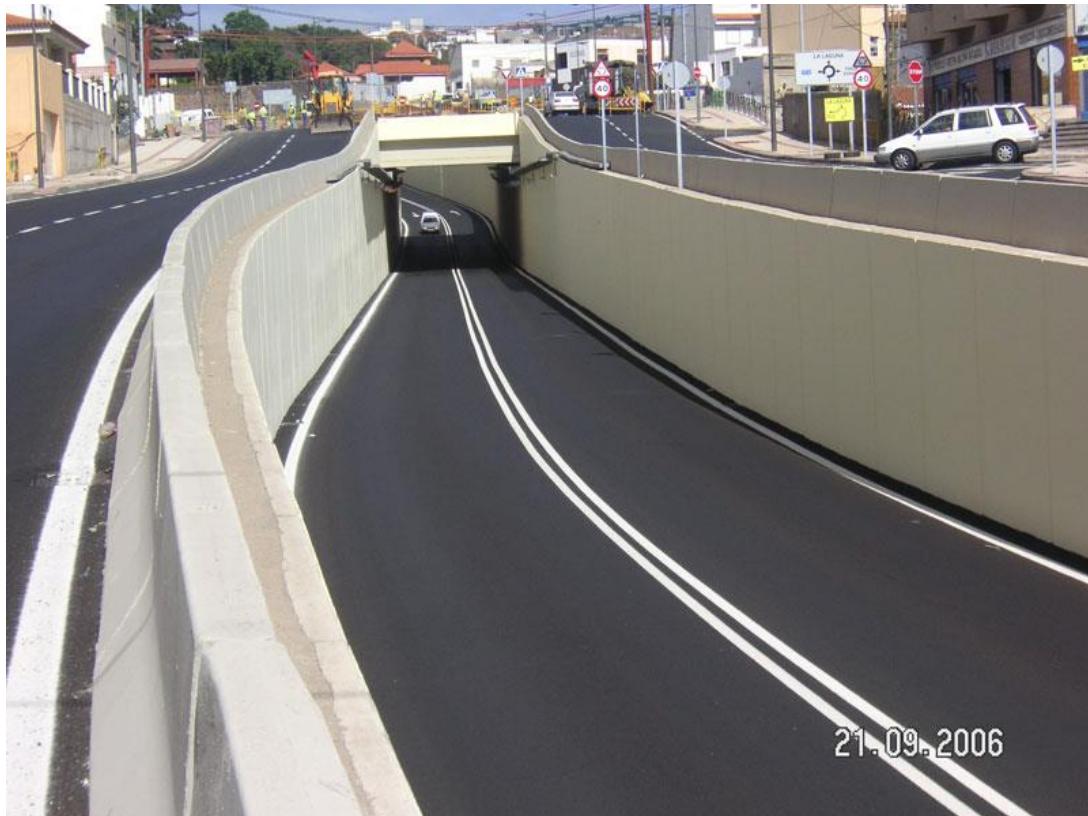
IMAGEN 21: MURO DE CONTENCION REFORZADO.
