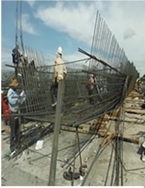
FOTOGRAFIA 54: INICIO DE ARMADO DE TRABES DE DISTRIBUCION.
