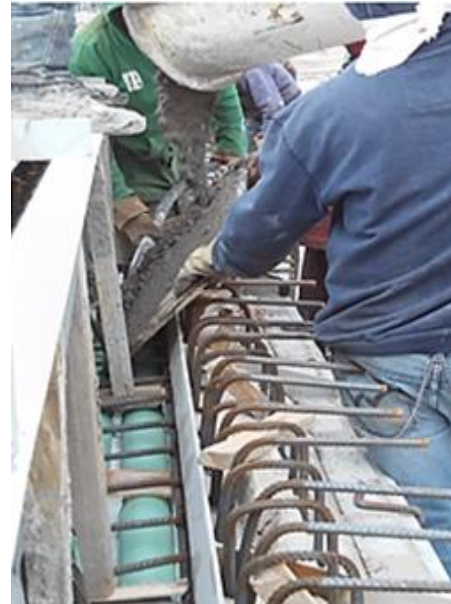
FOTOGRAFIA 29: VIBRACION DE PARAPETOS.
