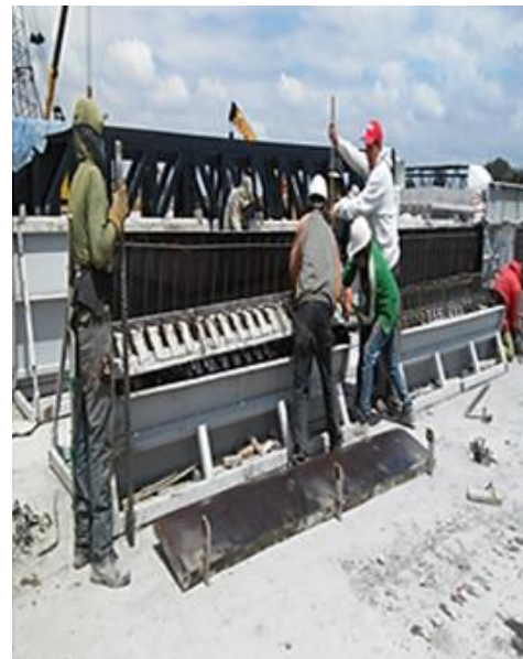
FOTOGRAFIA 25: ACOMODO DE ARMADO EN LA CIMBRA EN EL PARAPETO
