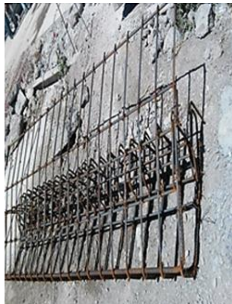
FOTOGRAFIA 21: TERMINADO DE ARMADO DE PARAPETO.
