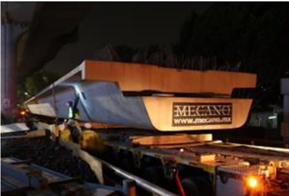
FOTOGRAFIA 13 ELEMENTO PREFABRICADO MONTADO EN: GRUA DE TRANSPORTE.
