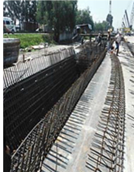
FOTOGRAFIA 55: ARMADO LONGITUDINAL DE TRABES DE DISTRIBUCIÓN.
