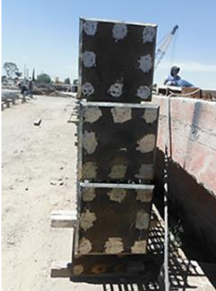
FOTOGRAFIA 42: SOLDADURA DE PLACA DE ACCESORIOS DE PILOTES.
