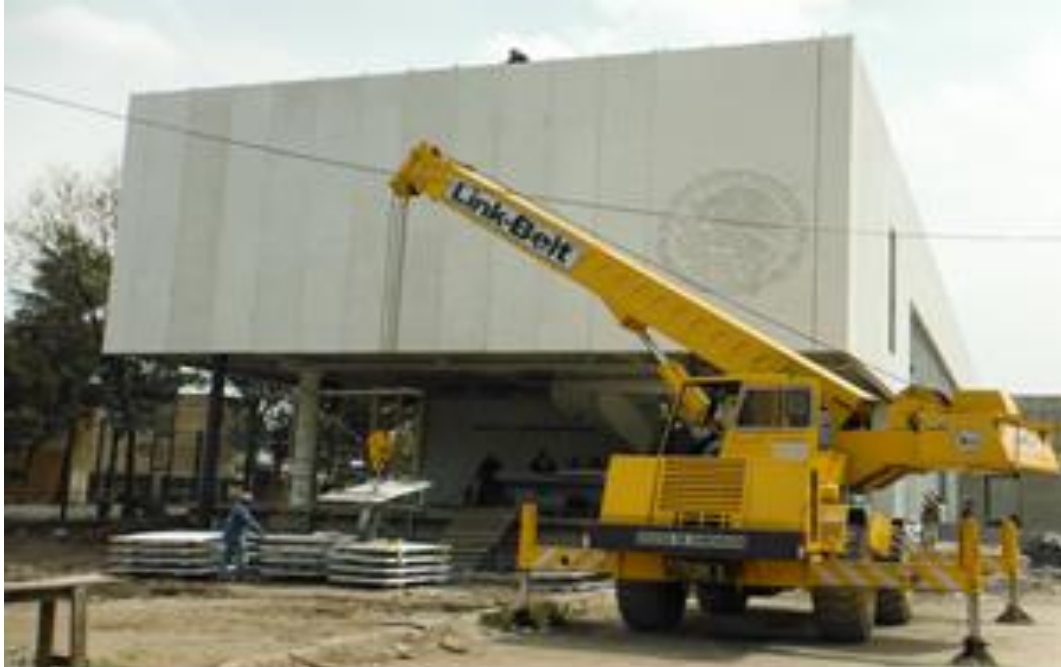
FOTOGRAFIA 76: MONTAJE DE LAS PIEZAS, FACHADA ARCHIVO GENERAL DE LA NACION.
