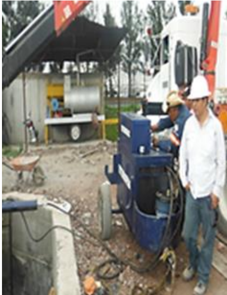
FOTOGRAFIA 58: TENSADO DE TORONES.
