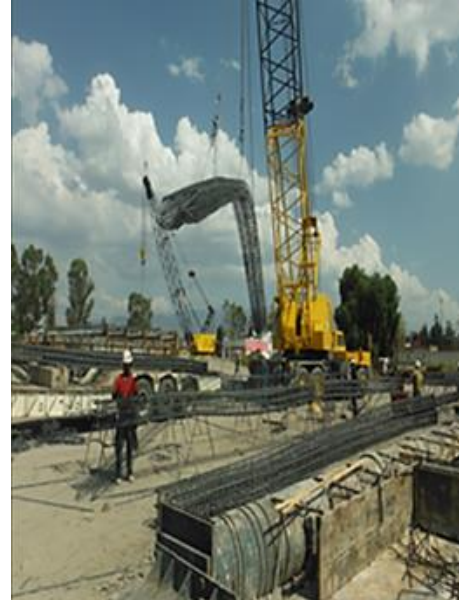
FOTOGRAFIA 43: COLOCACION DEL ARMADO EN EL MOLDE.
