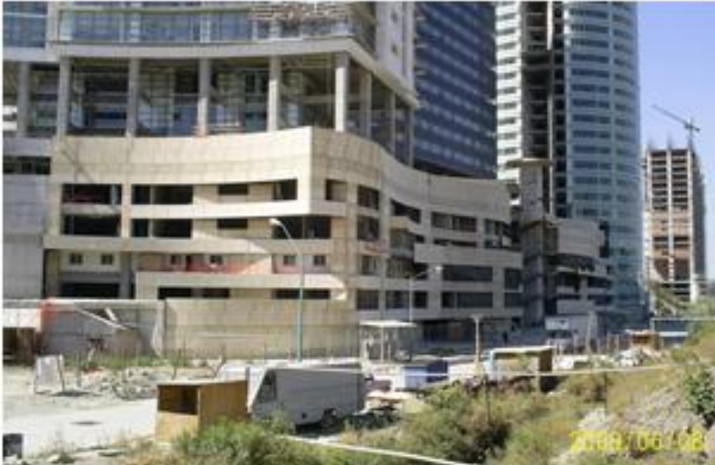
FOTOGRAFIA 82: MONTAJE DE LA FACHADA, COMPLEJO CITY SANTA FE.
