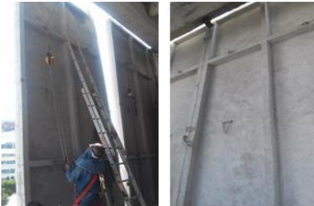
FOTOGRAFIA 88: MONTAJE DE LA FACHADA, CENTRO COMERCIAL VIA VALLEJO.
