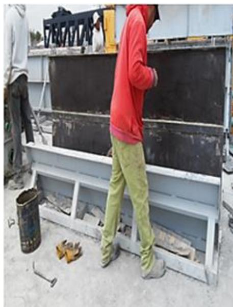
FOTOGRAFIA 20: ENGRASADO DE CIMBRA PARA PARAPETOS.
