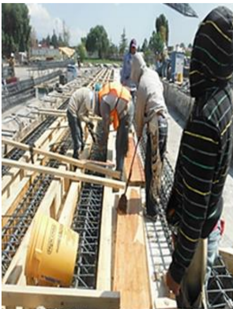
FOTOGRAFIA 44: COLOCACION DE CIMBRA EN EL ARMADO.
