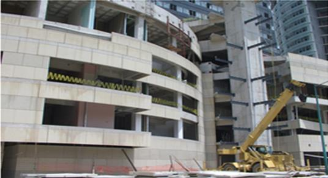
FOTOGRAFIA 4: MONTAJE DE LA RAPIDEZ DE LAS FACHADAS PREFABRICADAS, COMPLEJO CITY SANTA FE.
