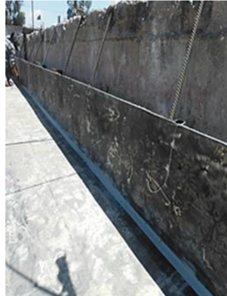
FOTOGRAFIA 35: TRAZO Y NIVELADO DE MOLDE DE LOS
