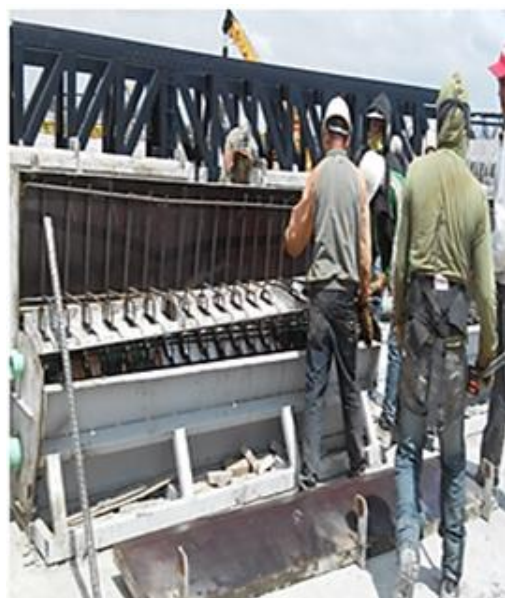
FOTOGRAFIA 24: ACOMODO DE ARMADO EN LA CIMBRA EN EL PARAPETO
