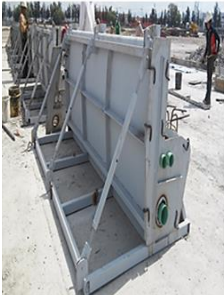
FOTOGRAFIA 18: CIMBRADO DE PARAPETOS.
