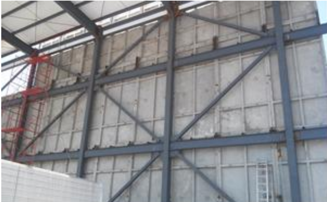
FOTOGRAFIA 87: MONTAJE DE LA FACHADA, CENTRO COMERCIAL VIA VALLEJO.
