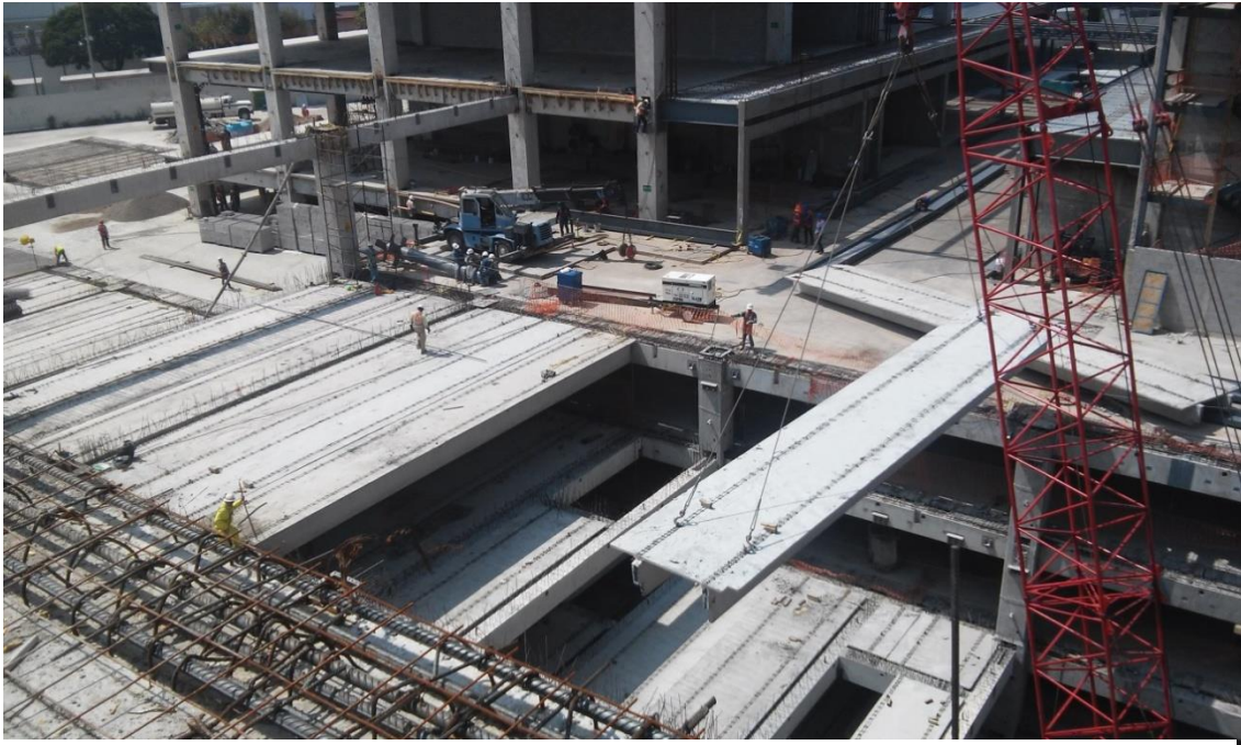
FOTOGRAFIA 14: MONTAJE DE VIGAS.
