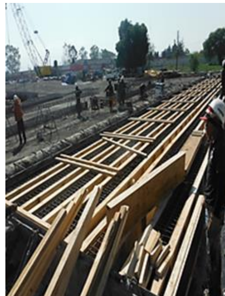
FOTOGRAFIA 45: COLOCACION DE CIMBRA EN EL ARMADO.
