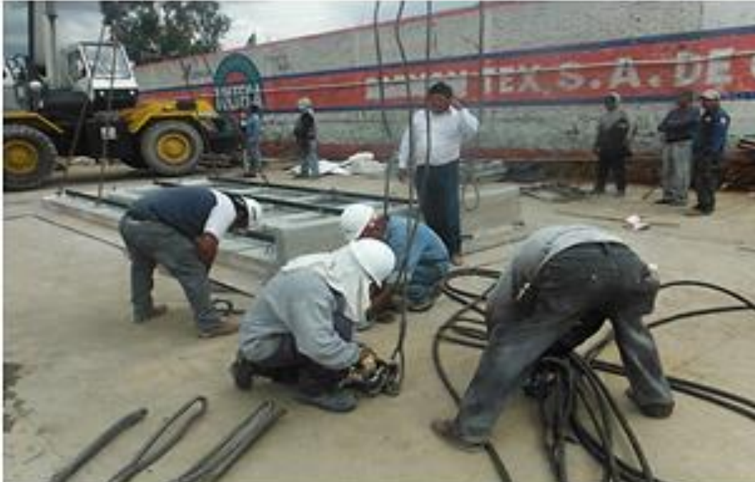
FOTOGRAFIA 66: DESMOLDE DE LA PIEZA, FACHADA ARCHIVO GENERAL DE LA NACION.
